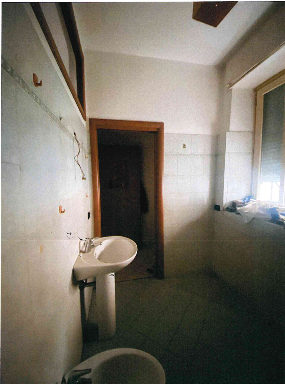
FOTO 7: TREZZO D'ADDA, via Torre 36, bagno
