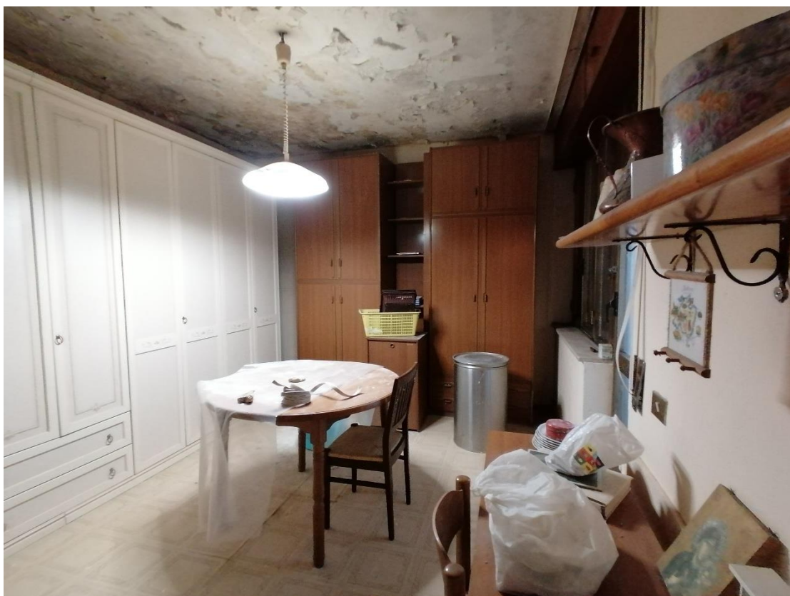
Foto 08: Interno u.i. Piano Terra - Camera esposta a Nord-Est presumibilmente da demolire.
