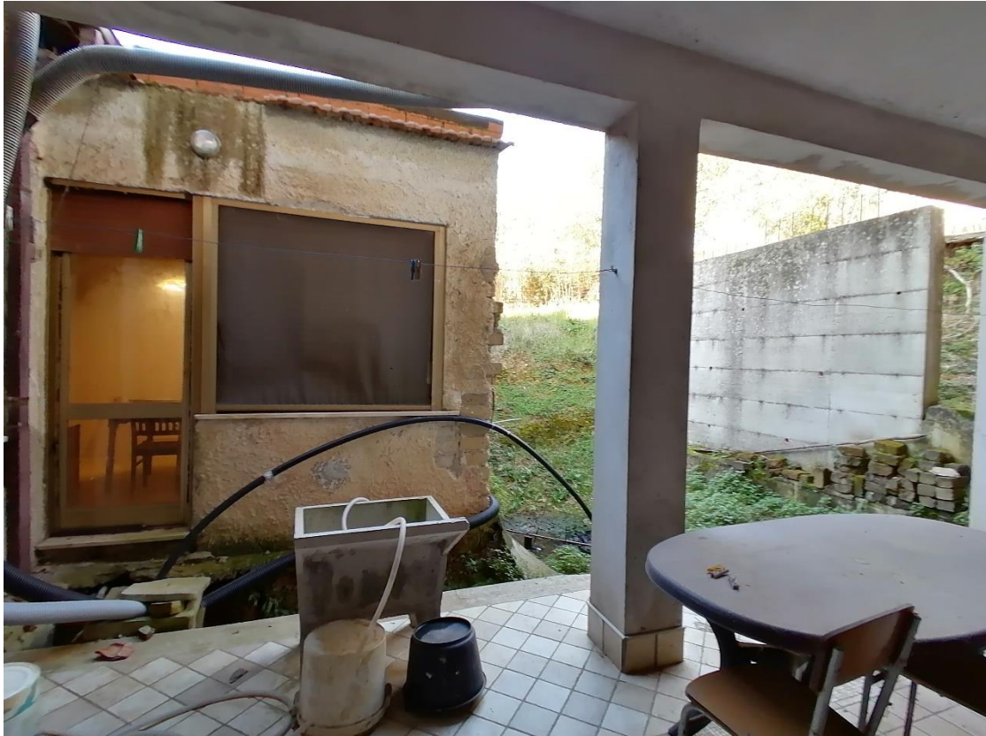
Foto 22: Esterno u.i. Piano Terra - Portico esposto ad Est e vista camera esposta a Nord-Est.
