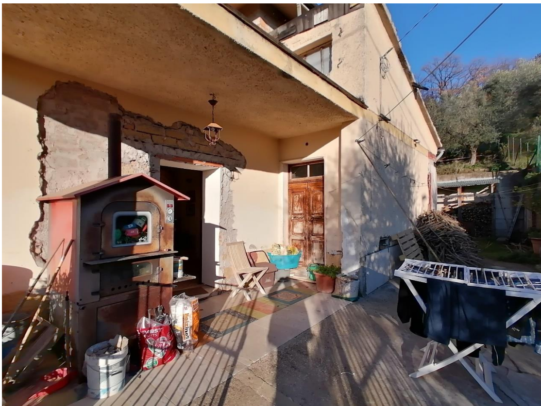
Foto 02: Prospetto Sud - Ingresso principale al fabbricato.
