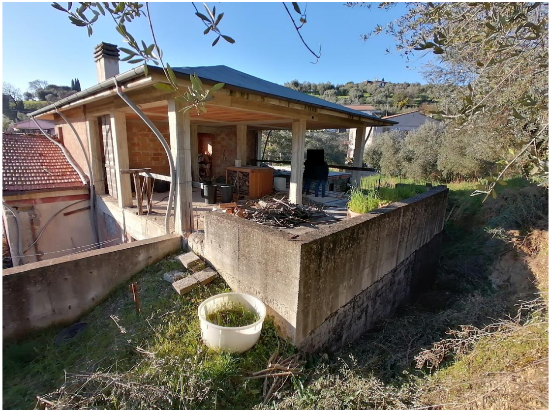
Foto 06: Prospetto Est - Portico e terrazzo di nuova costruzione ma ancora da ultimare.
