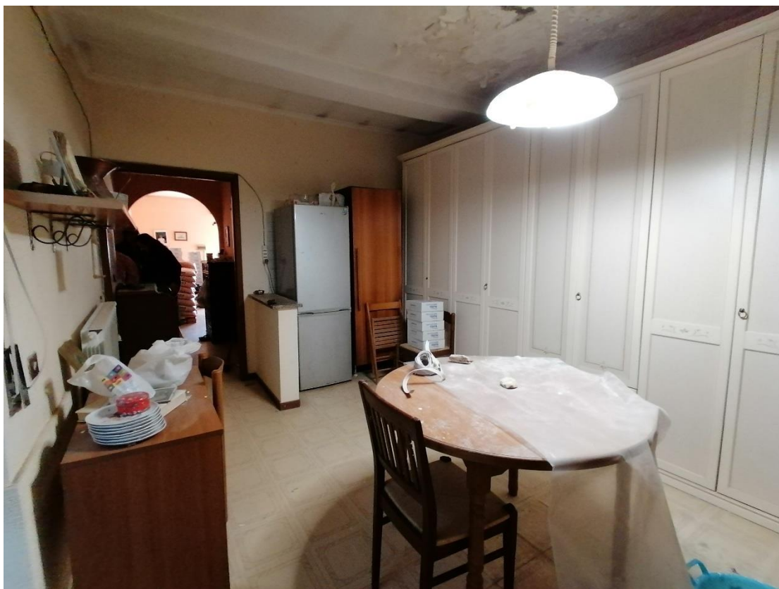
Foto 09: Interno u.i. Piano Terra - Camera esposta a Nord-Est presumibilmente da demolire.
