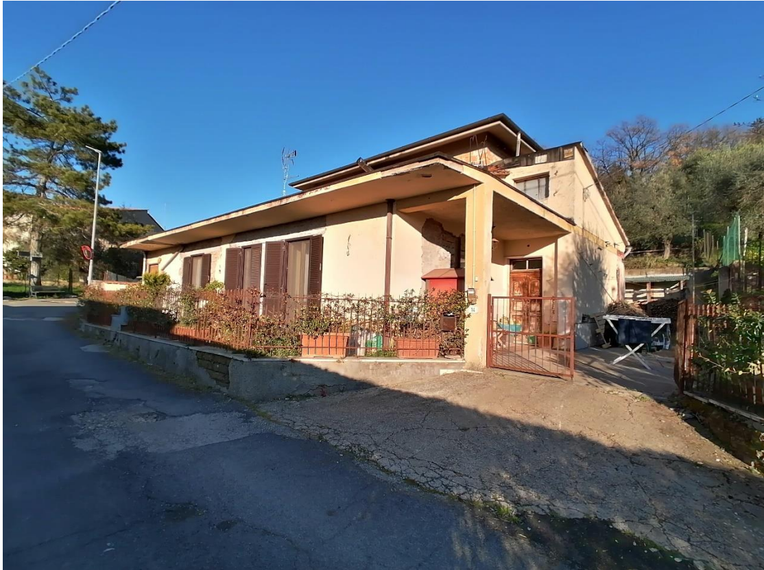
Foto 01: Prospetto Sud-Ovest - Ingresso al fabbricato.
