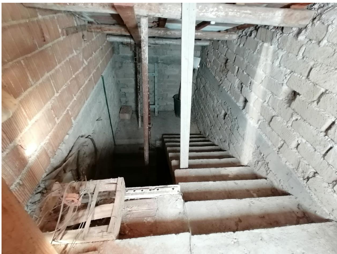
Foto 34: Interno u.i. Piano Terra / Piano Primo – Vano Scala.
