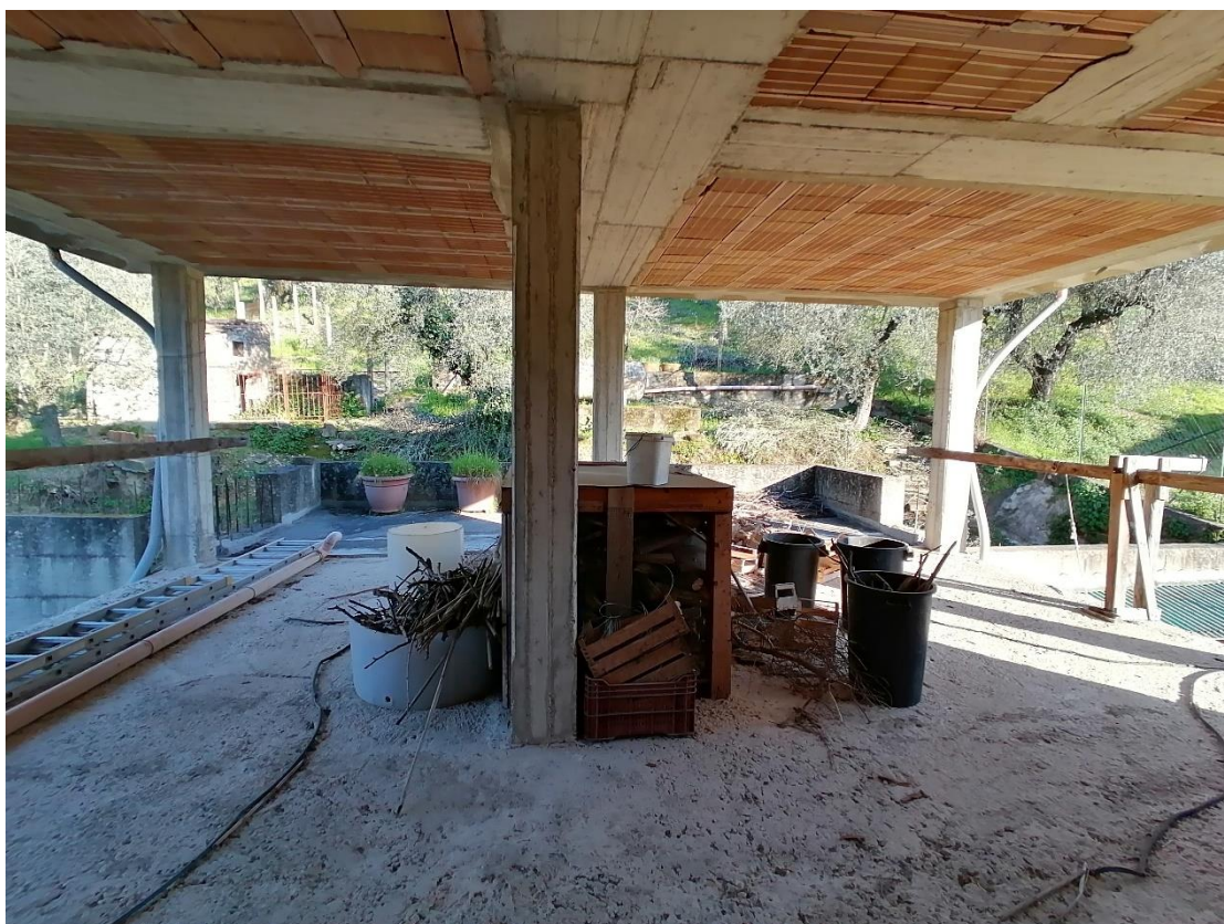
Foto 33: Interno u.i. Piano Primo – Portico al rustico.
