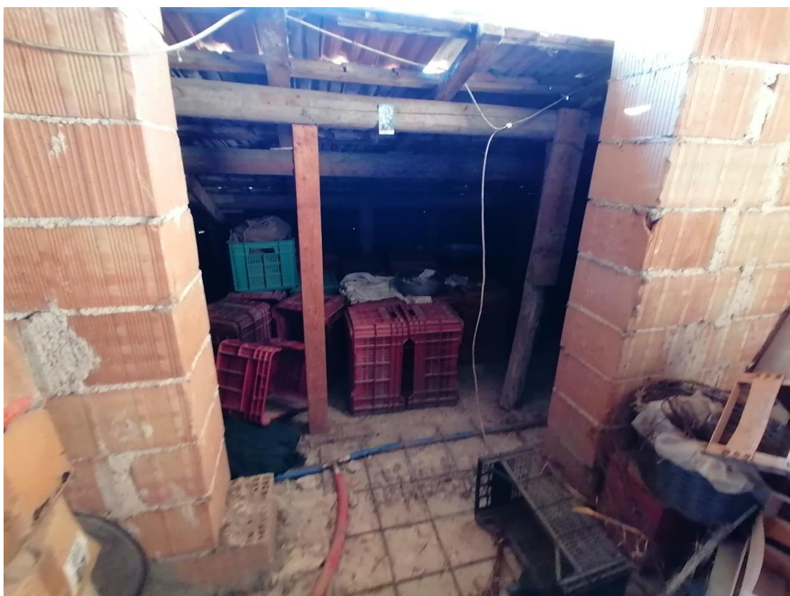
Foto 32: Interno u.i. Piano Primo – Vista porzione tetto a copertura del Piano Terra (potenziale terrazzo).
