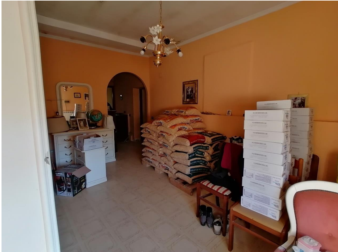
Foto 11: Interno u.i. Piano Terra - Camera esposta a Nord-Ovest presumibilmente da demolire.
