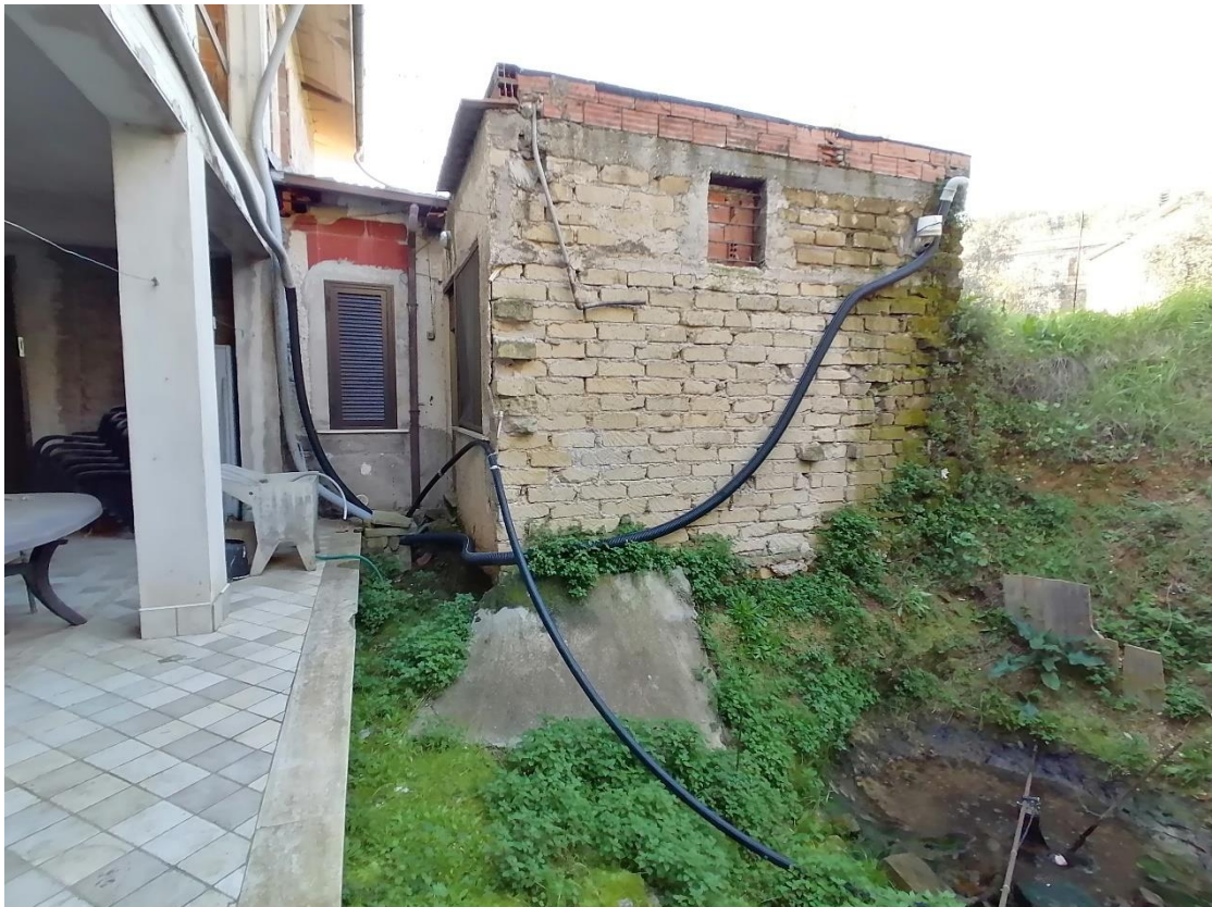
Foto 23: Esterno u.i. Piano Terra - Portico esposto ad Est e vista camera esposta a Nord-Est.
