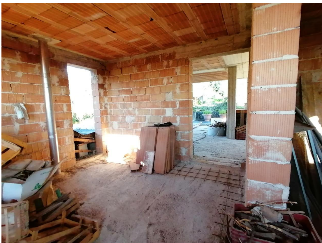
Foto 30: Interno u.i. Piano Primo – Locali al rustico.
