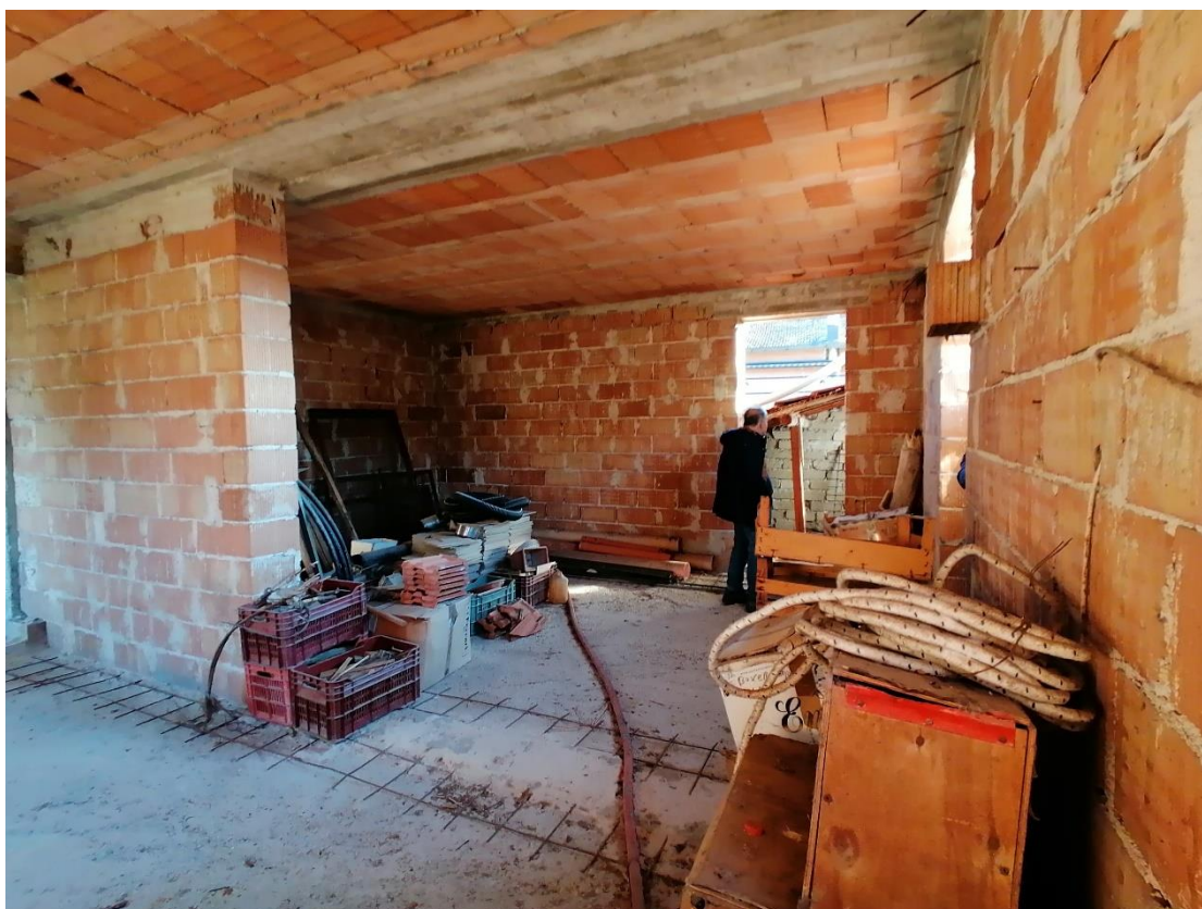
Foto 31: Interno u.i. Piano Primo – Locali al rustico.
