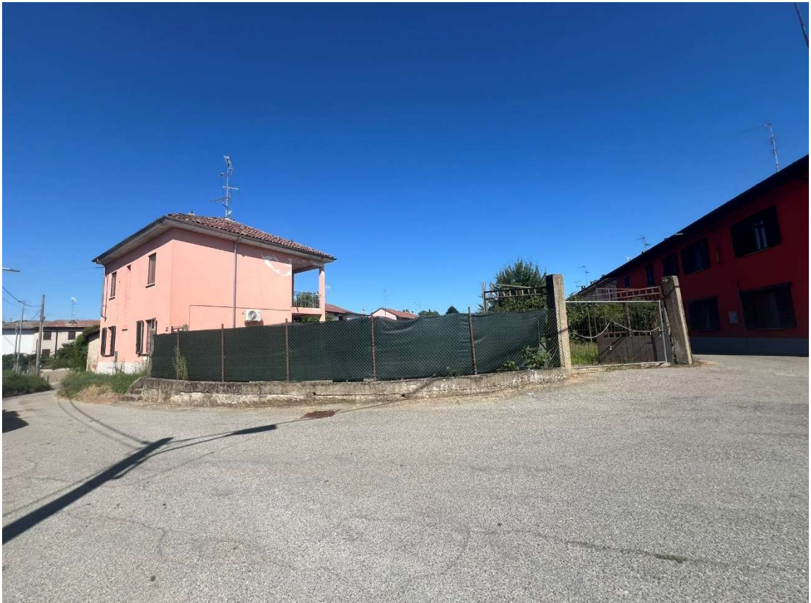
Vicolo Ossario – immobile affaccio su strada
