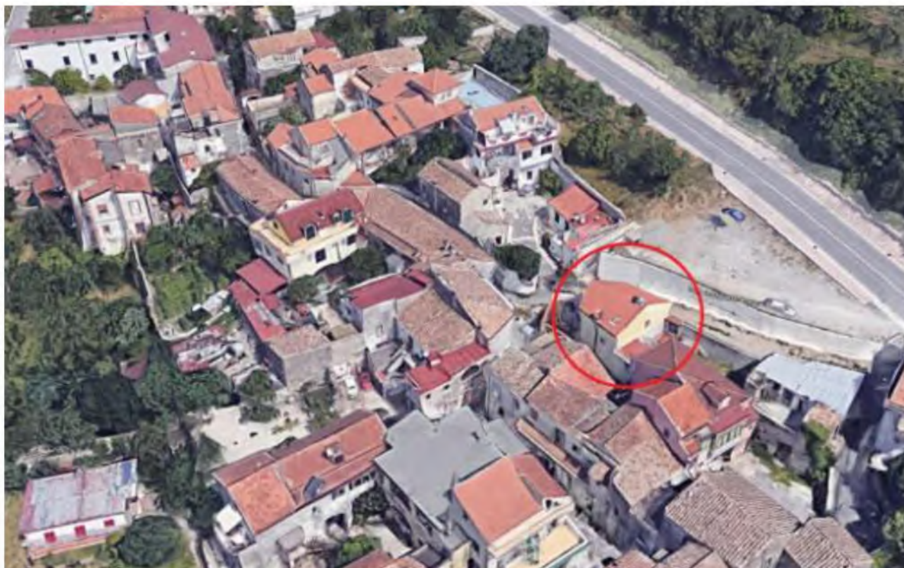
Figura 2/3/4: Individuazione della p.lla 488 su stralcio di mappa stradale (Google Maps) ed aerofotogrammetria (Fonte Google Heart)
