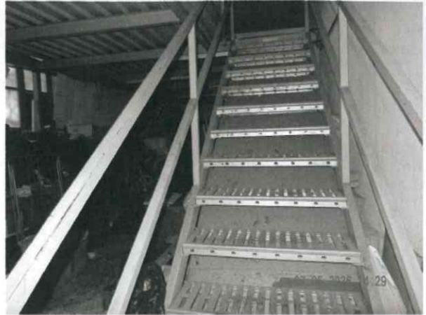
Scala di accesso al piano soppalco
