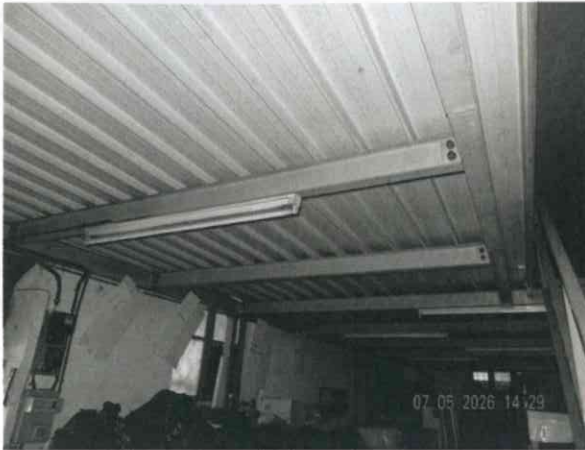
Vista struttura in ferro piano soppalco
