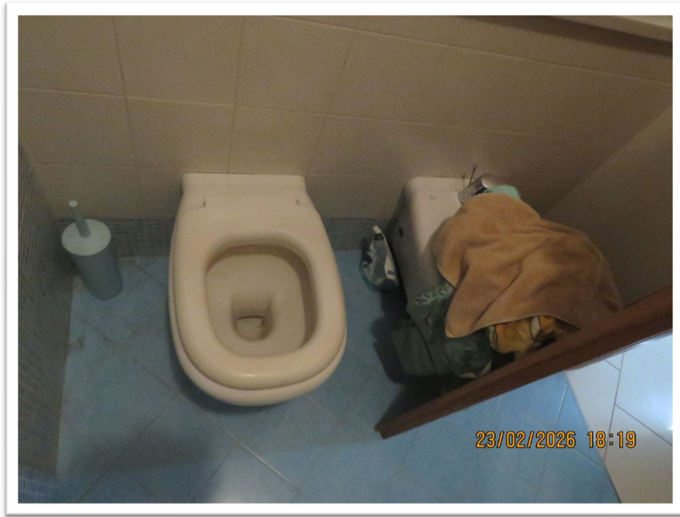
Particolari del bagno.
