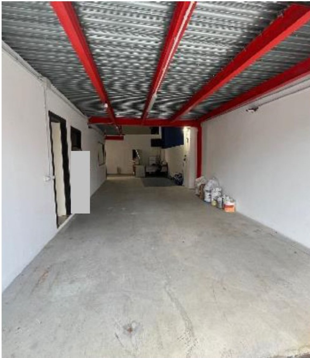
Zona frontale (vista da esterno)
