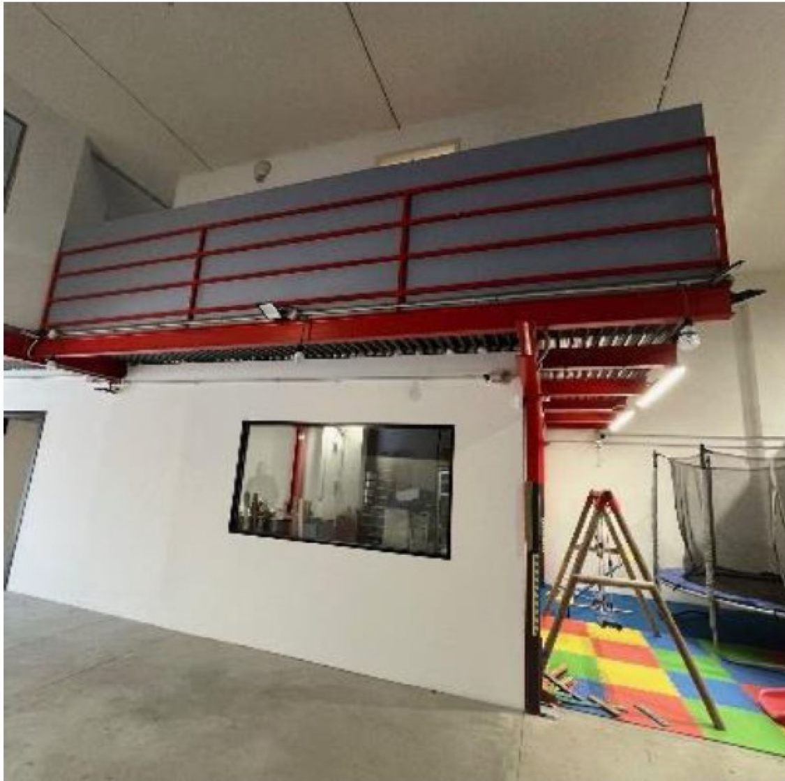
Vista soppalco e partizione interna
