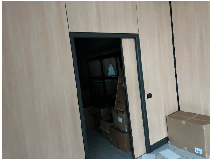
FOTO 49 Vista uffici P.1°
