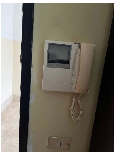
FOTO 123 Vista abitazione P.1°
