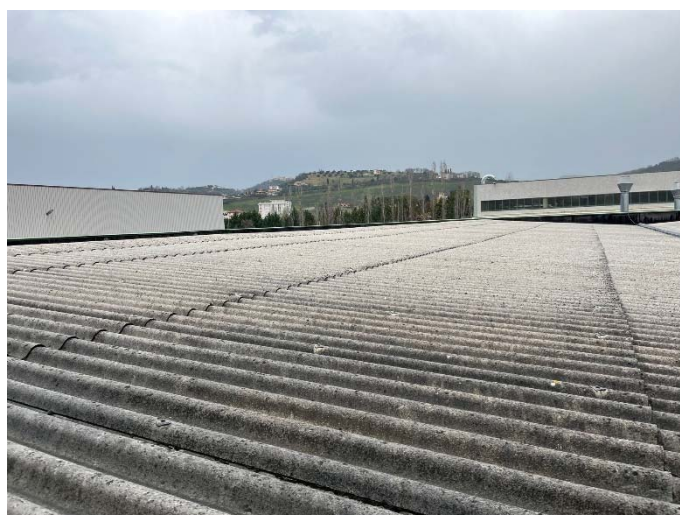
FOTO 124 Vista copertura capannone
