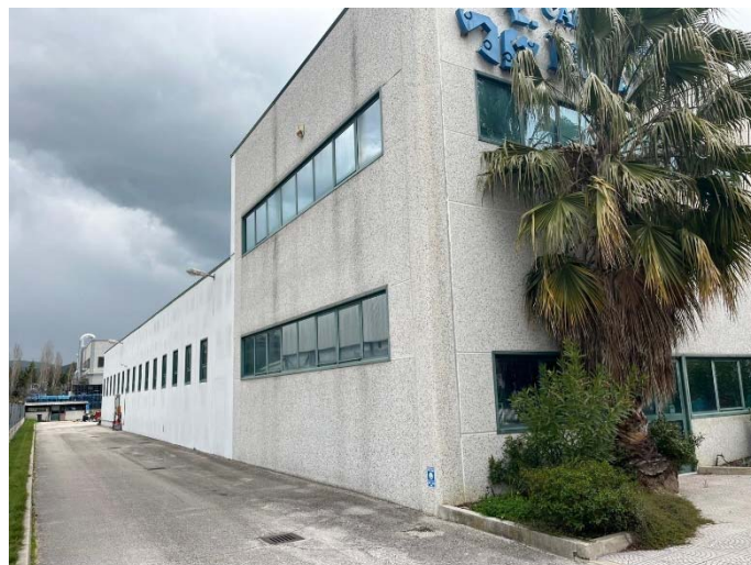
FOTO 14 Vista lato Ovest angolo lato Sud
