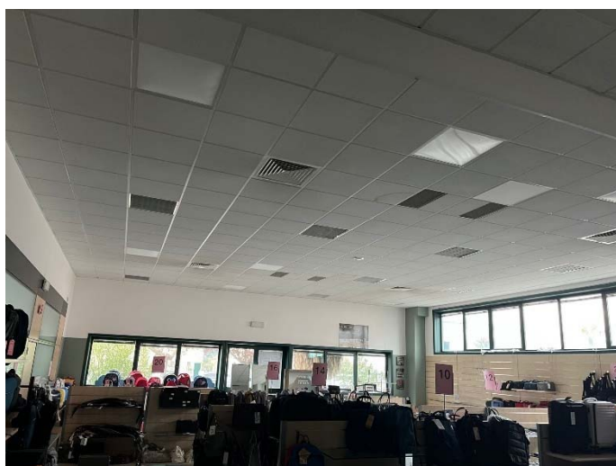
FOTO 59 Vista interno spaccio aziendale
