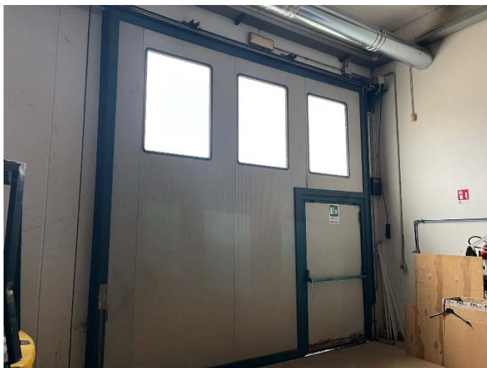
FOTO 77 Vista interno portoncino uscita sicurezza
