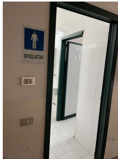
FOTO 104 Vista interno spogliatoioio uomini
