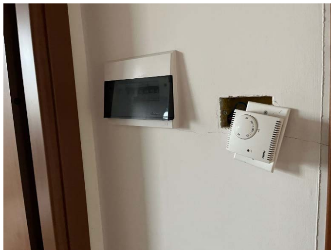
FOTO 122 Vista abitazione P.1°
