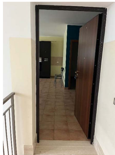
FOTO 112 Vista ingresso abitazione P.1°
