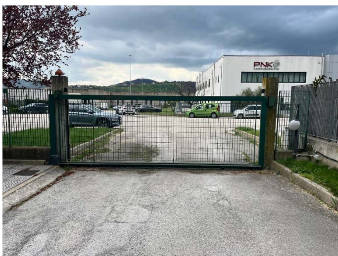
FOTO 27 Vista ingresso carrabile lato Sud/Ovest
