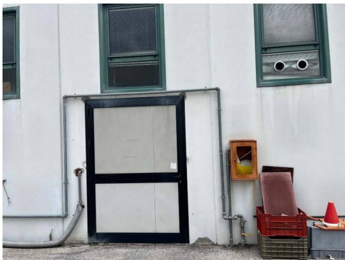
FOTO 13 Vista porta sicurezza su lato Ovest
