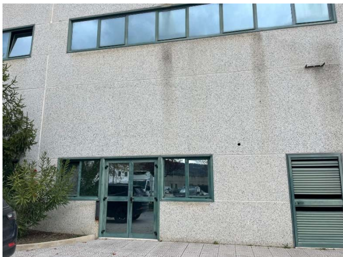
FOTO 19 Vista ingresso mensa lato Sud
