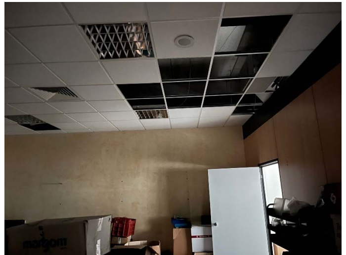
FOTO 50 Vista uffici P.1°
