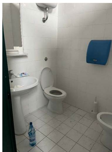
FOTO 96 Vista interno spogliatoio donne
