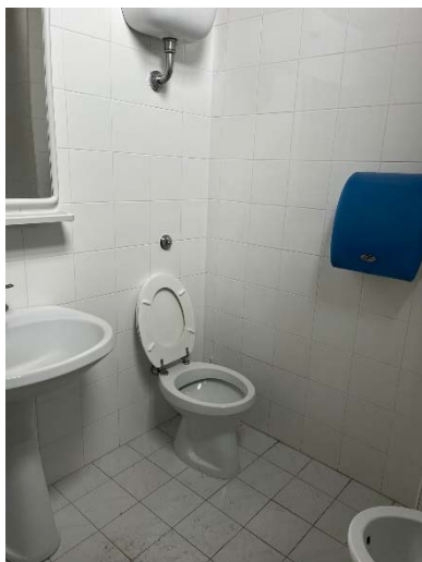
FOTO 97 Vista interno spogliatoio donne
