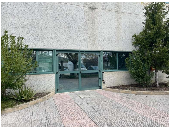
FOTO 17 Vista ingresso principale lato Sud
