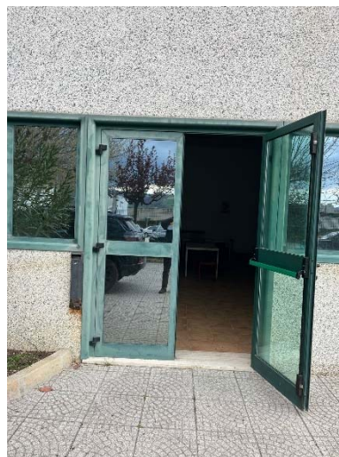
FOTO 18 Vista ingresso mensa lato Sud
