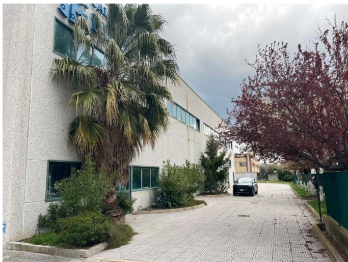
FOTO 15 Vista lato Sud
