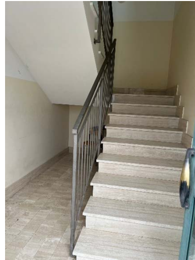
FOTO 110 Vista ingresso vano scale per accesso P.1° abitazione
