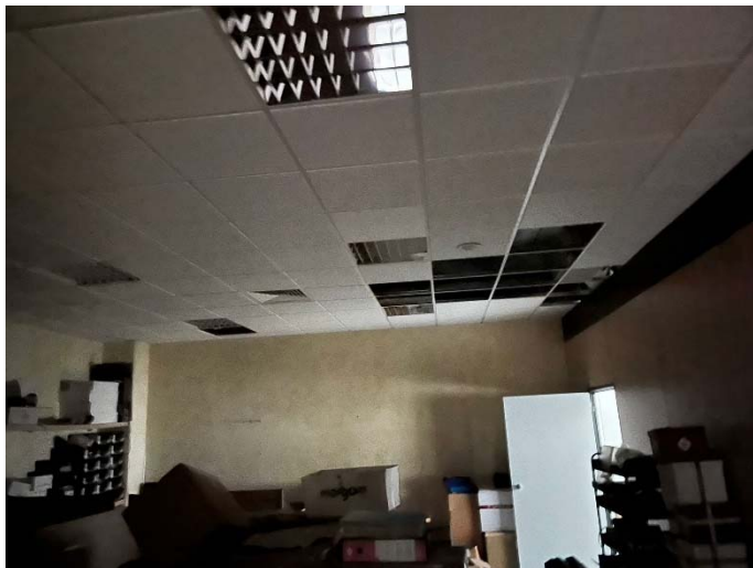
FOTO 51 Vista uffici P.1°
