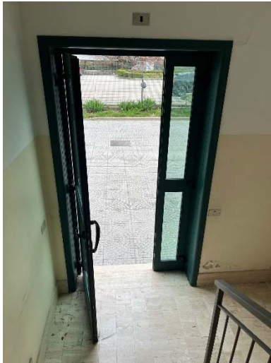
FOTO 109 Vista ingresso vano scale per accesso P.1° abitazione
