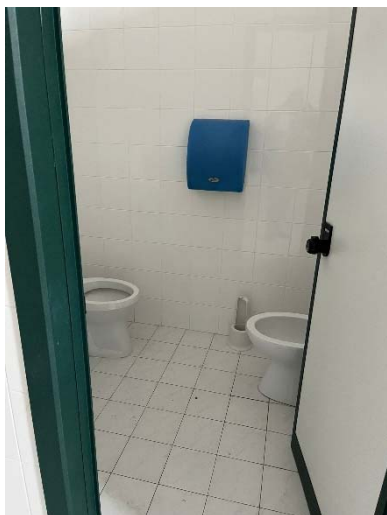
FOTO 99 Vista interno spogliatoio donne
