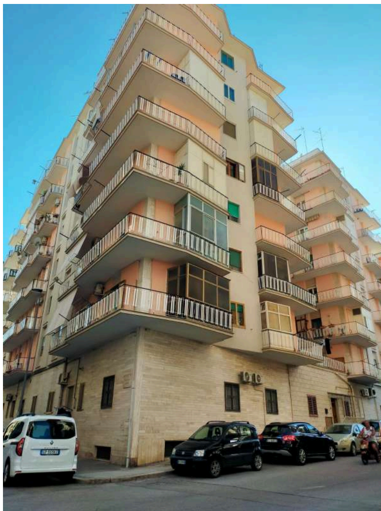
Vista esterna dell'edificio
