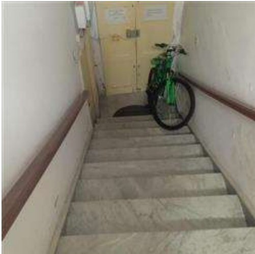
Foto n. 3 Scala di accesso al primo piano
