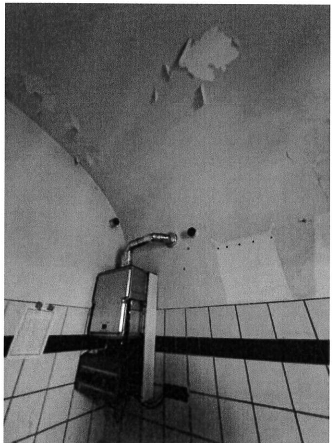
Figura 11- caldaia
