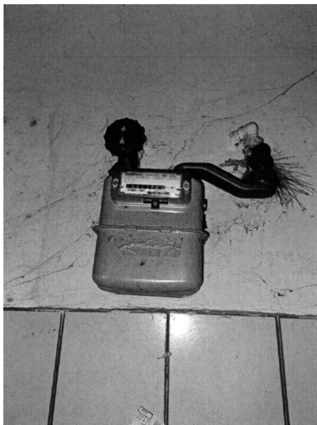
Figura 20- contatore metano
