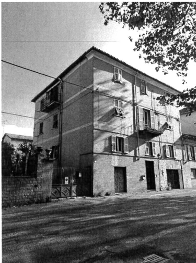
Figura 1- Facciata verso via P.Isola
