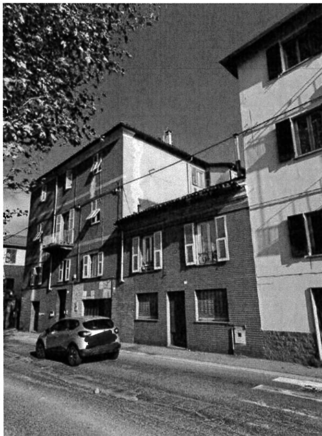
Figura 2- Facciata verso via P.Isola
