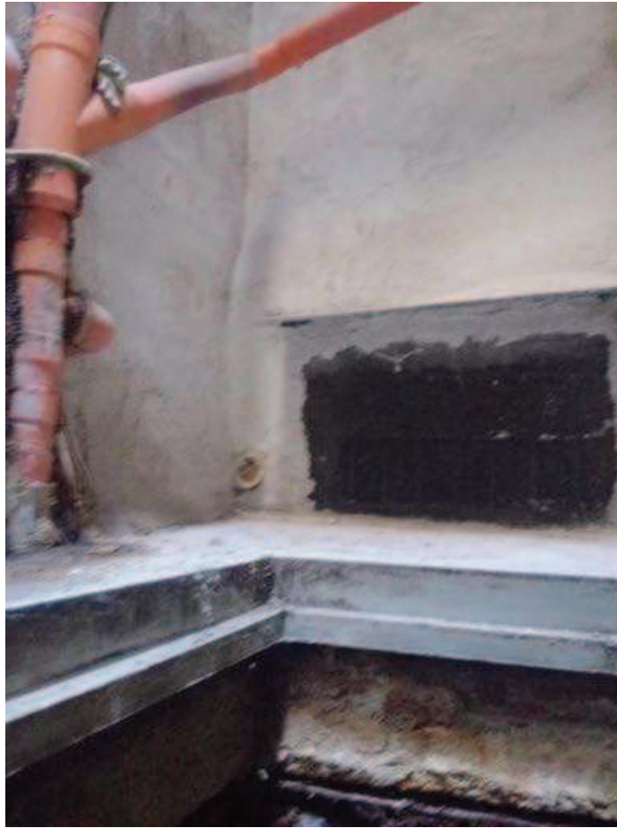
Foto 15- vista della finestra del wc su parete confinante con antibagno, dal pozzo luce
