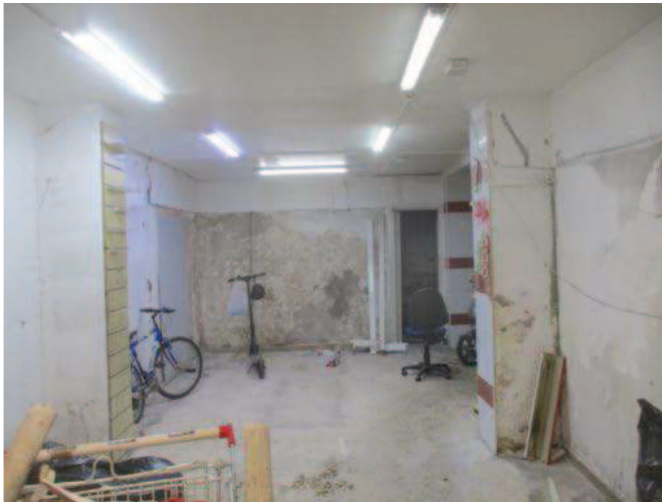
Foto 3- vista interna del bene pignorato al civ.91 di via Archimede
