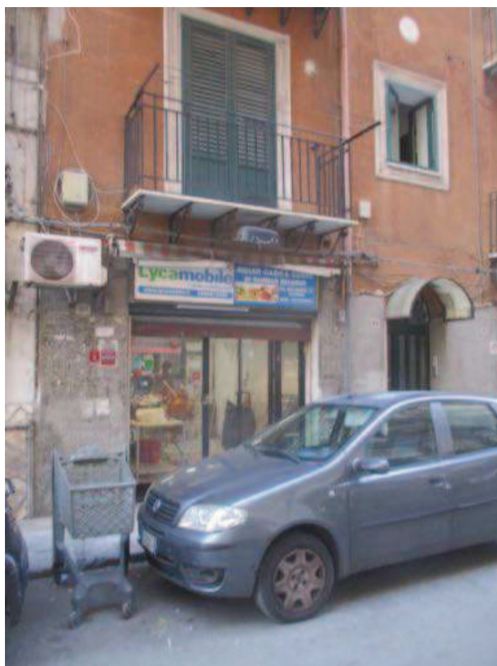
Foto 2- vista del bene pignorato al civ.91 di via Archimede
