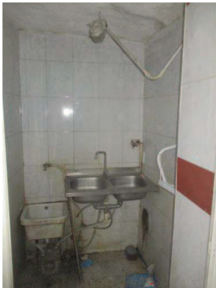
Foto 6- vista dell'antibagno corrispondente a porzione del pozzo luce chiuso
