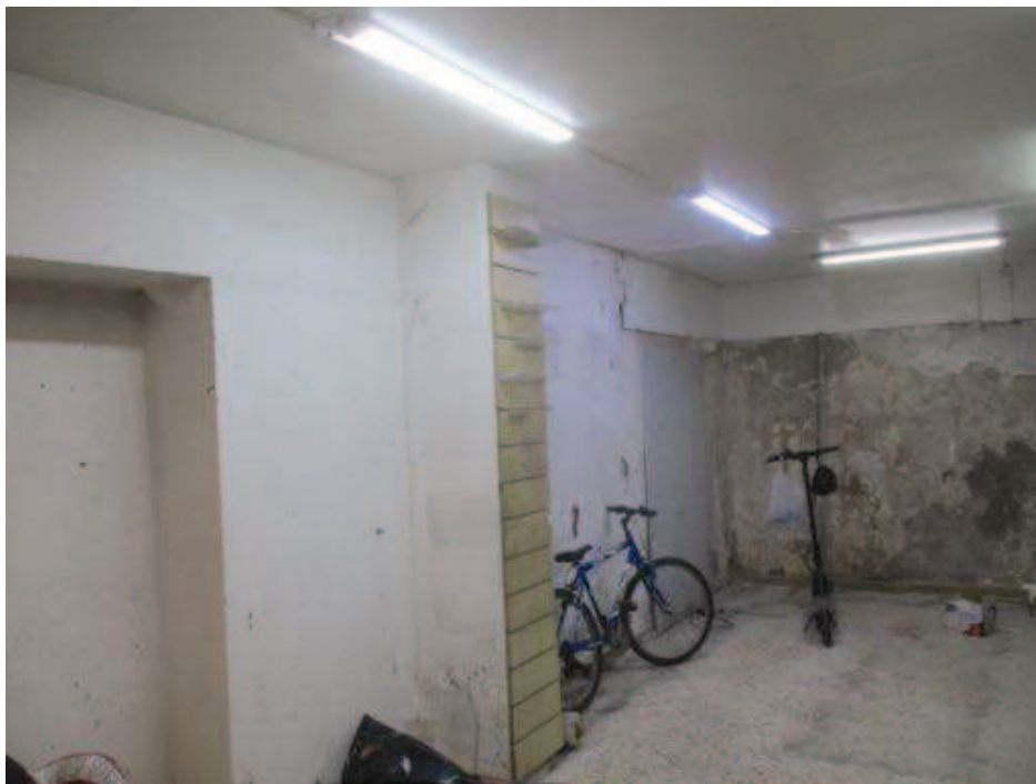
Foto 10- vista interna del bene pignorato al civ.91 di via Archimede
