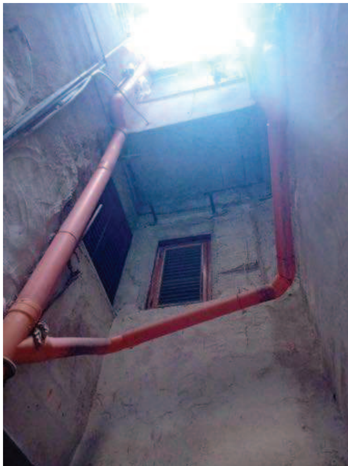
Foto 16- vista interna del pozzo luce del fabbricato
