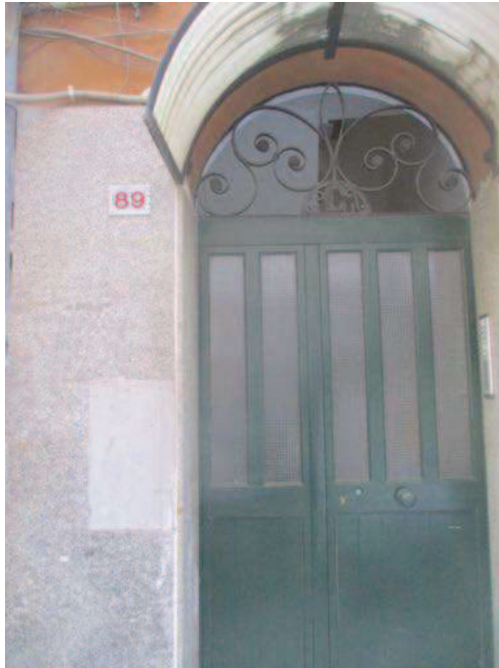
Foto 21- vista dell'ingresso a vano scala condominiale civ.89 di via Archimede
