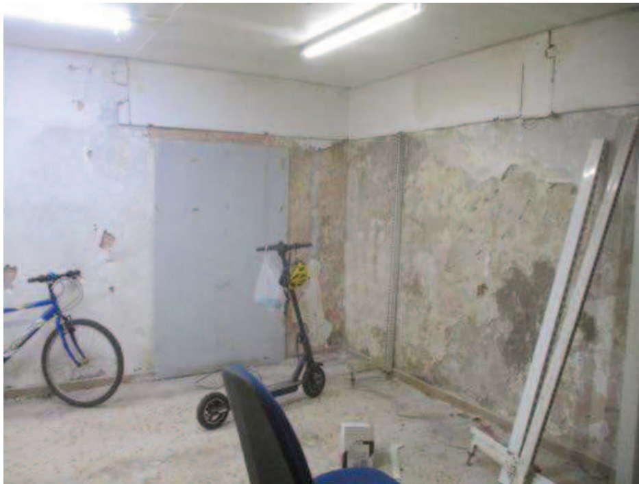
Foto 5- vista interna del bene pignorato al civ.91 di via Archimede
