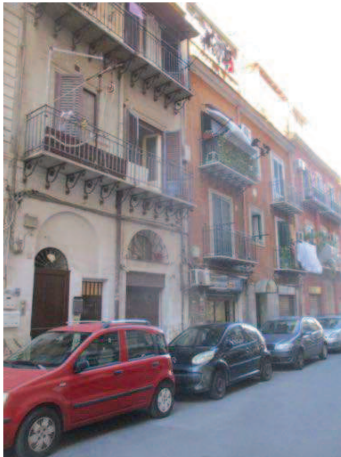
Foto 1- vista del maggiore fabbricato ove insiste il bene pignorato al civ.91 via Archimede
