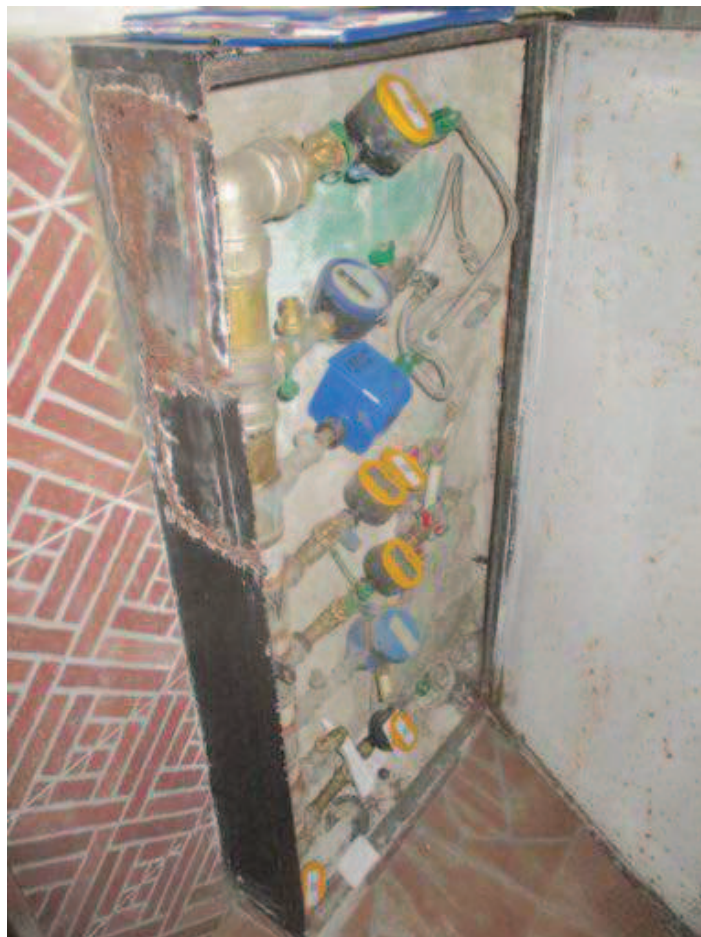
Foto 22 vista interna del bene pignorato al civ.91 di via Archimede
