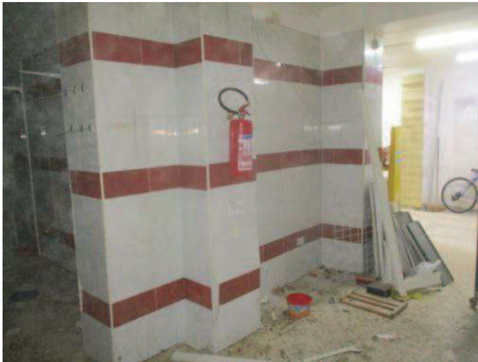
Foto 13- vista interna del bene pignorato al civ.91 di via Archimede
