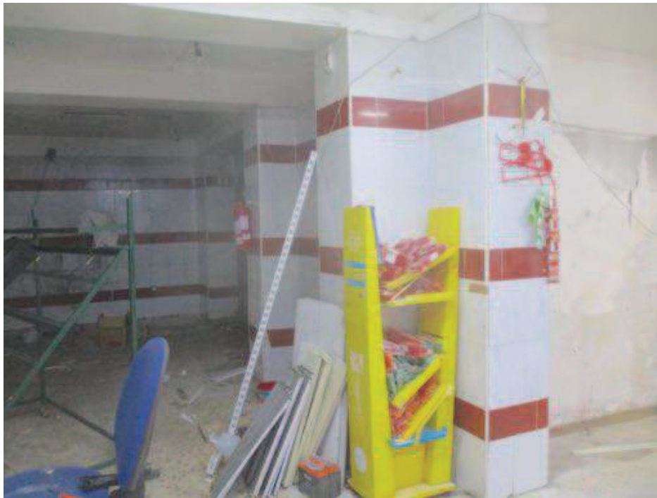
Foto 19- vista interna del bene pignorato al civ.91 di via Archimede
