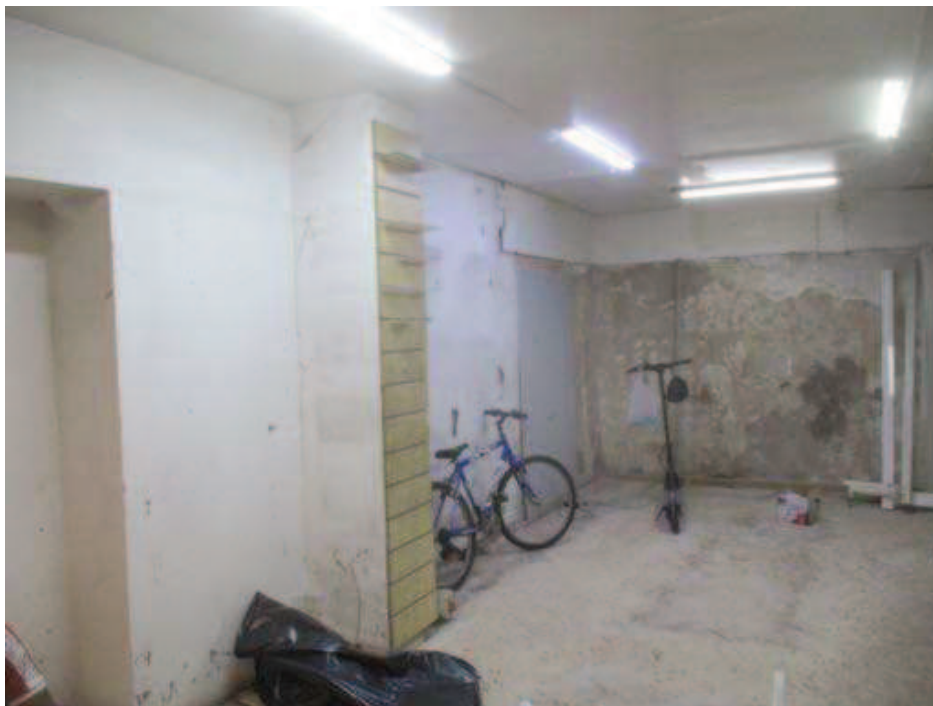
Foto 4- vista interna del bene pignorato al civ.91 di via Archimede
