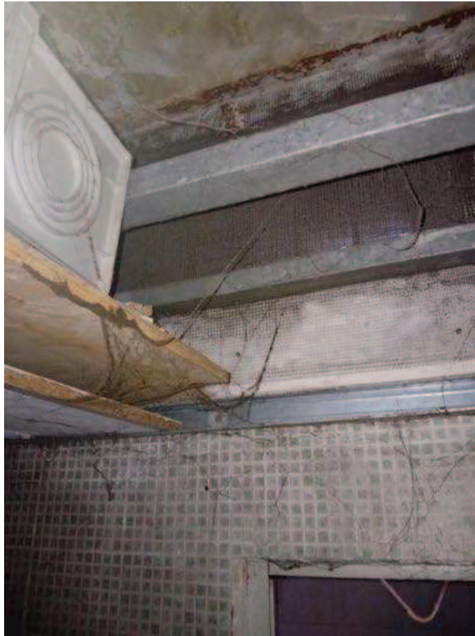
Foto 17- vista della finestra tra antibagno e bagno
