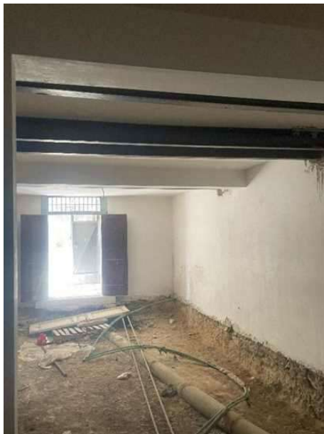
Figura 7 -Piano Terra_Locale di Sgombero
