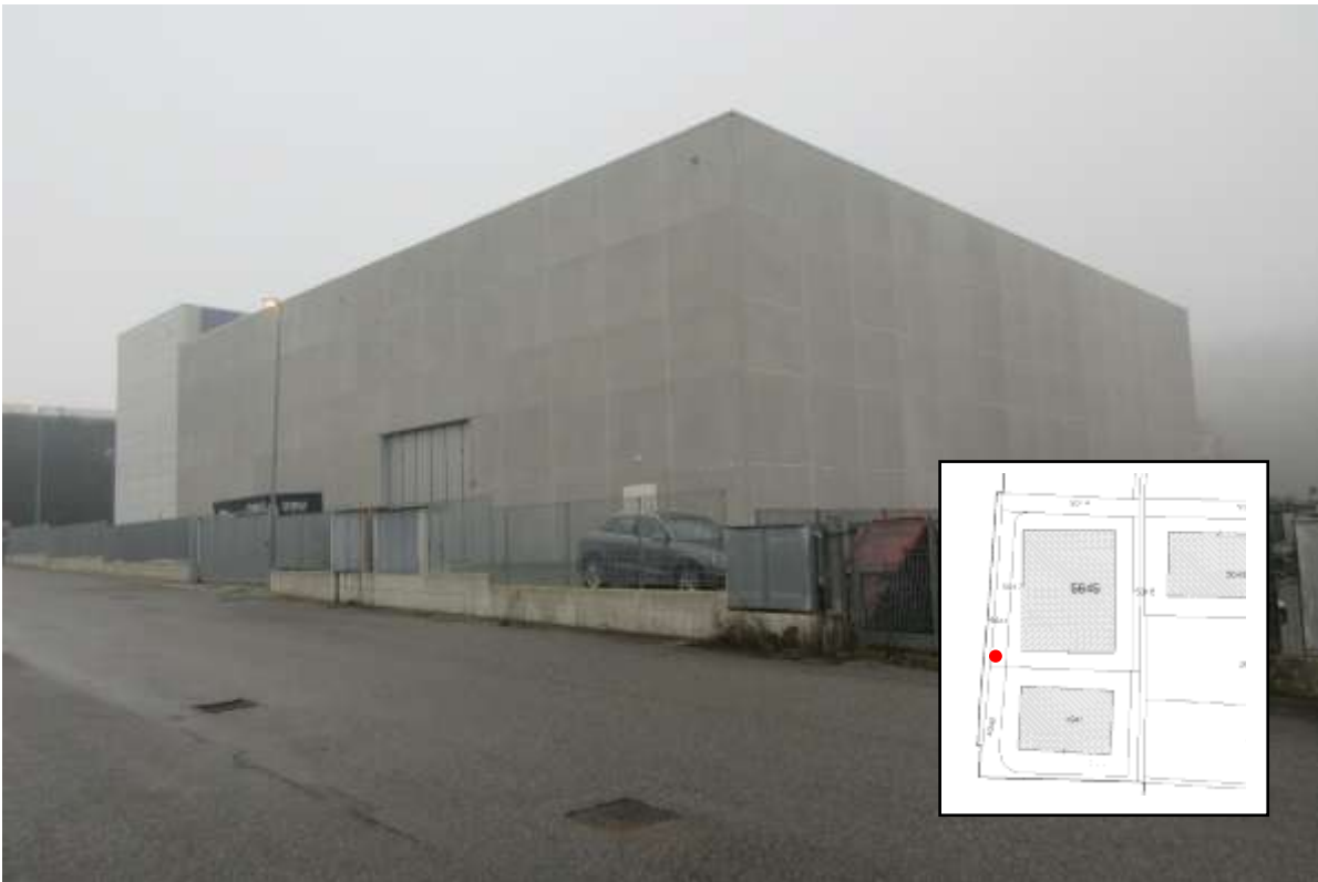
Vista del retro dell'immobile oggetto d'esecuzione con un ingresso carraio
