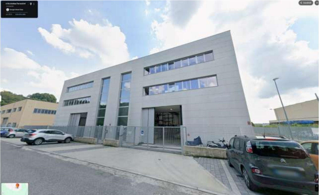
Ingresso carraio sulla Via Andrea Parravicini n° 8 con antistante parcheggio di proprietà
