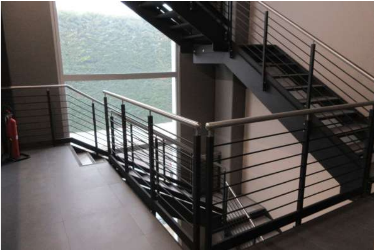
Scala interna con struttura in ferro e pedata rivestita in piastrelle che disimpegna l'accesso agli uffici ai piani primo e secondo
