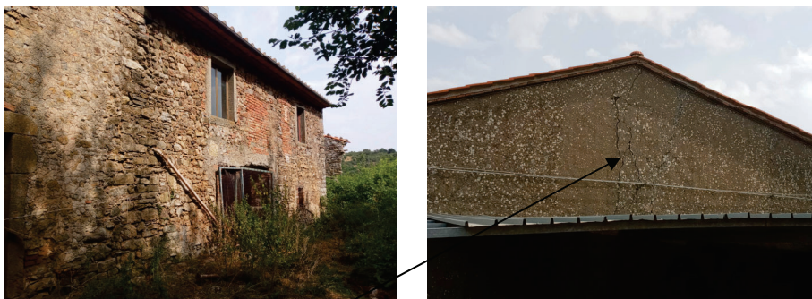
Particolare lesione verticale e spanciamento della muratura
