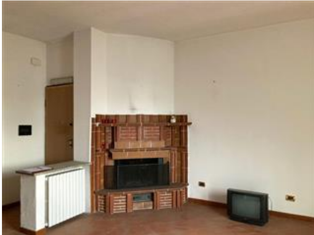
Irregolarità tramezzature interne
