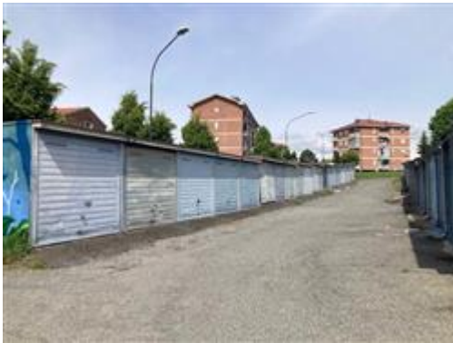
Area esterna blocco autorimesse
