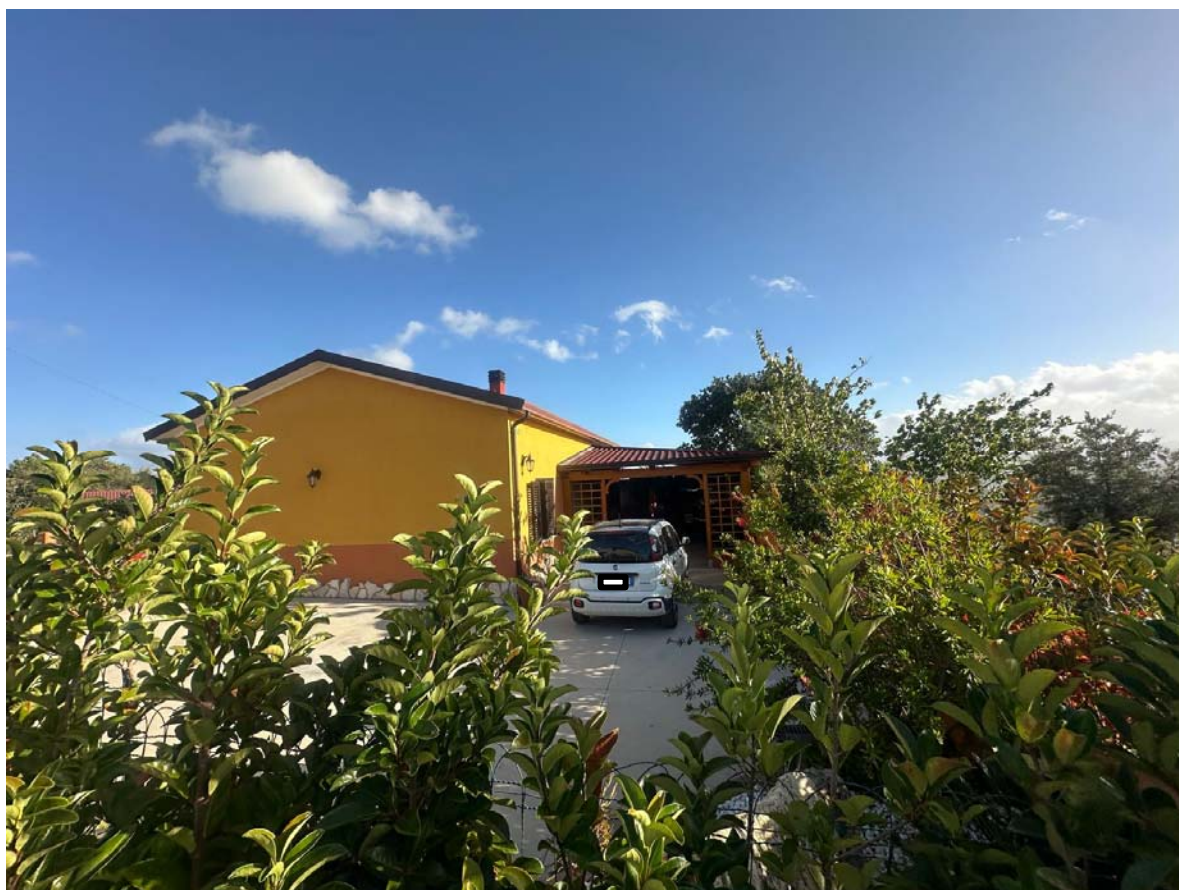
Foto n.17-18 : Comune di Fragneto Monforte (Bn) foto dell'unità immobiliare identificata al NCEU al foglio 12 particella 494 sub 4. Foto in alto vista da nord.
