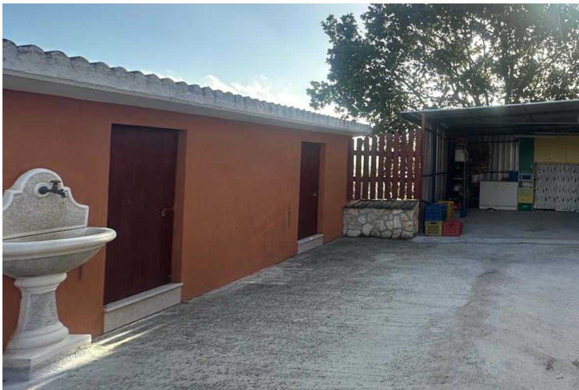
Foto n. 27-28: Comune di Fragneto Monforte (Bn) foto dell'unità immobiliare identificata al NCEU al foglio 12 particella 267 sub 5. Foto in alto il pollaio a piano terra vista da sud-est (tratteggio giallo); foto in basso le due porte della porcilaia (oggi deposito).
