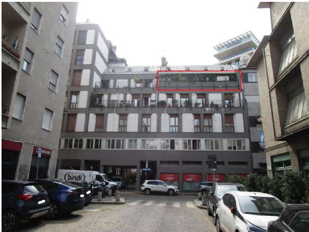
Foto 3 – Vista e inquadramento dell'appartamento con affaccio su via Lentasio
