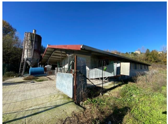
Particolare facciata dei fabbricati
