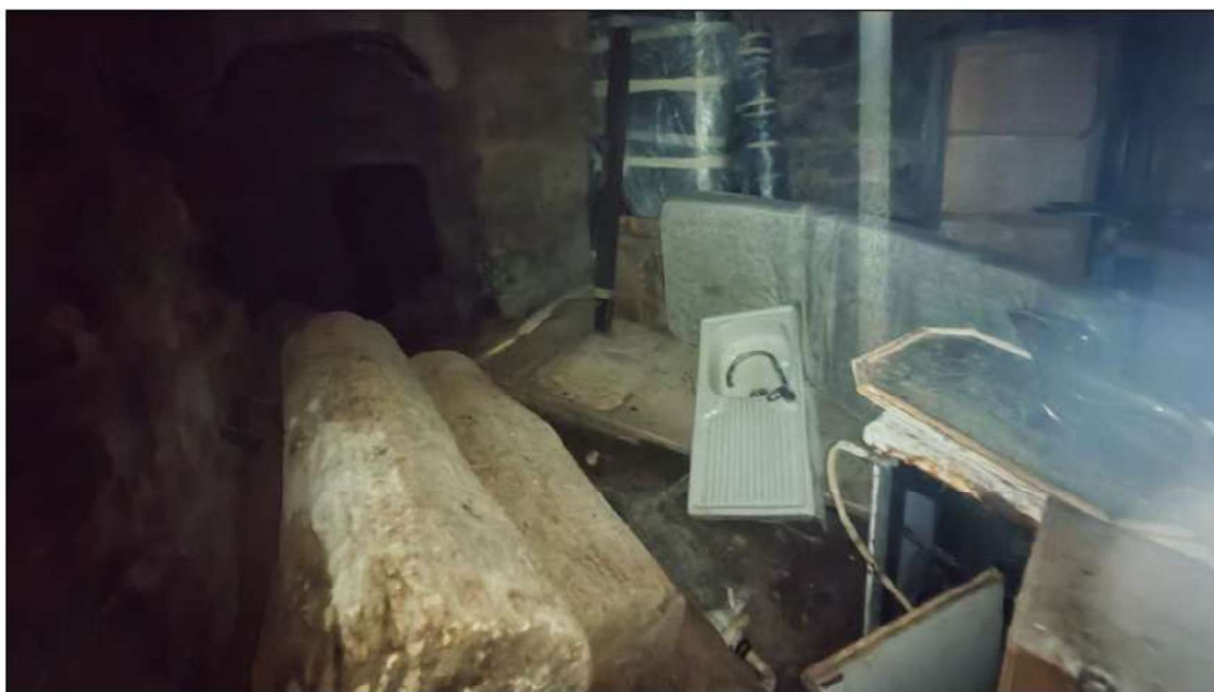
foto 43 - vista della cantina (LOTTO 1).
