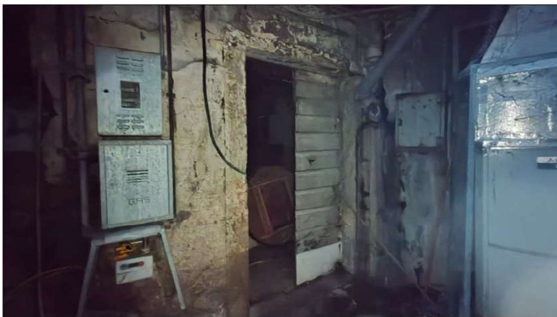
foto 41 - vista dell'accesso alla cantina (LOTTO 1).
