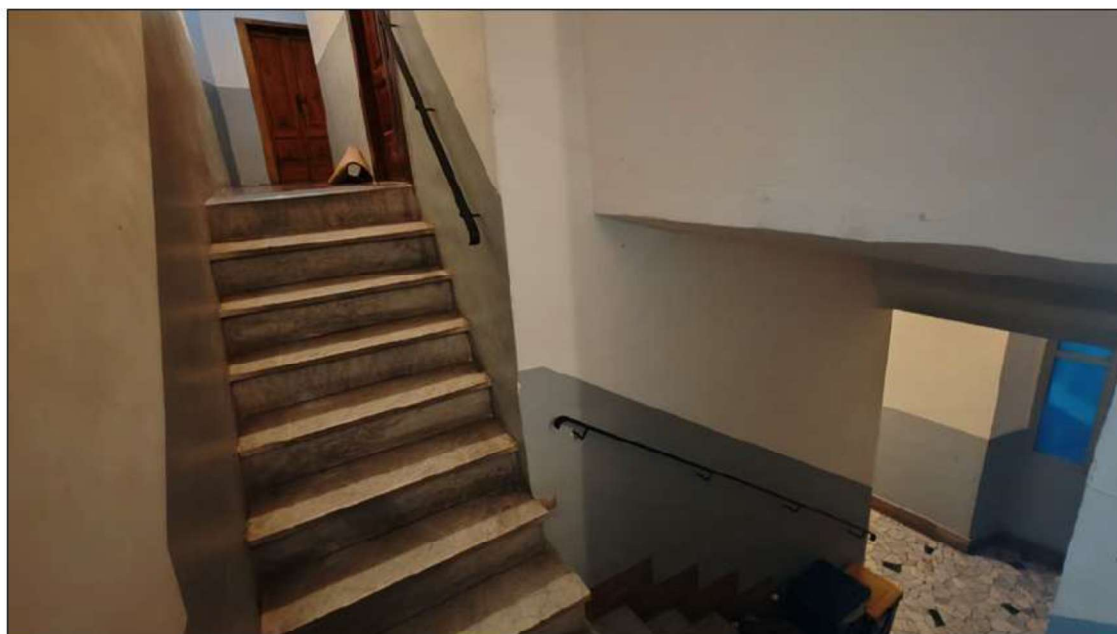
foto 5 - vista del vano scala di accesso al piano 3°.
