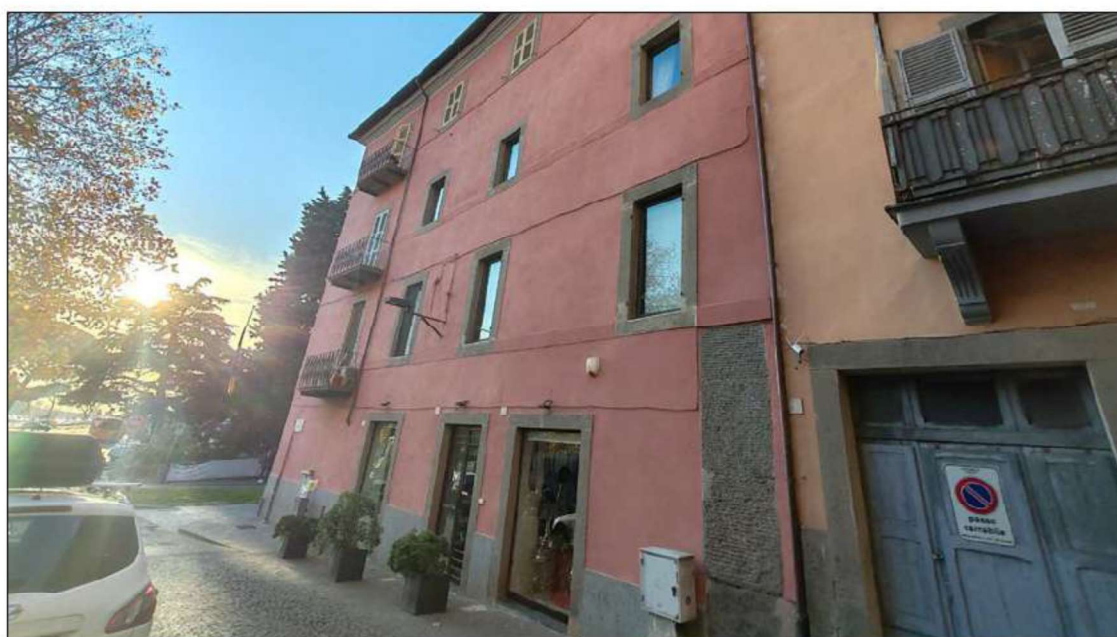
foto 4 - vista esterna dell'immobile da via Emilio Bianchi.
