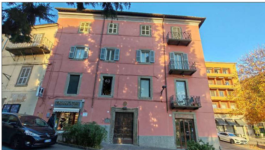
foto 1 - vista esterna da via Cairoli dell'edificio nel quale sono posti ai p. S1-T e 3° i beni pignorati.
