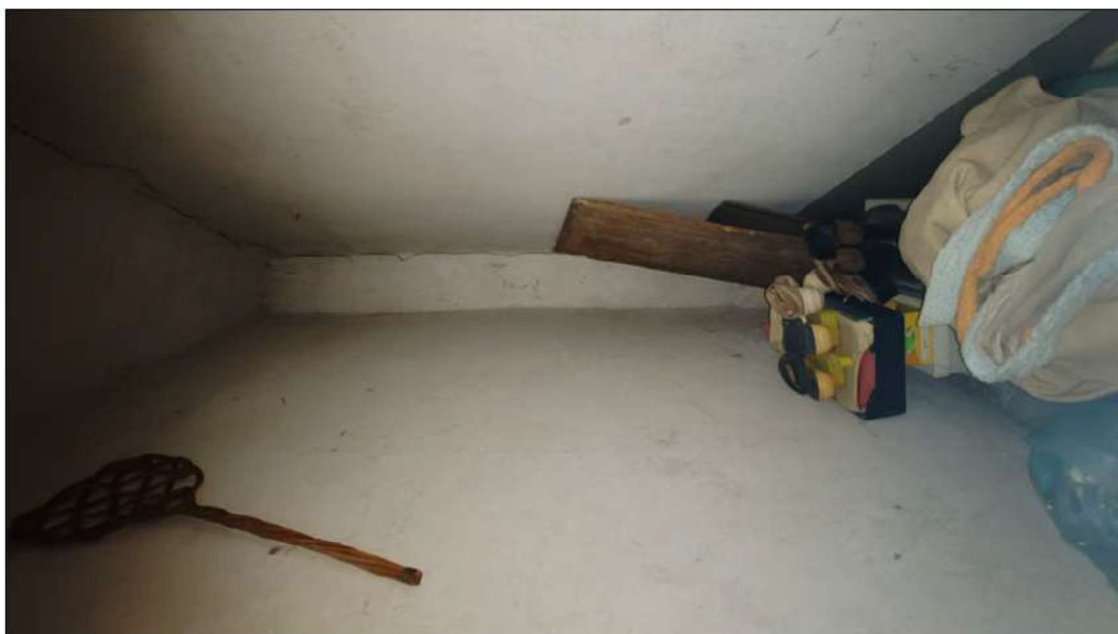
foto 19 - vista del ripostiglio (LOTTO 1).
