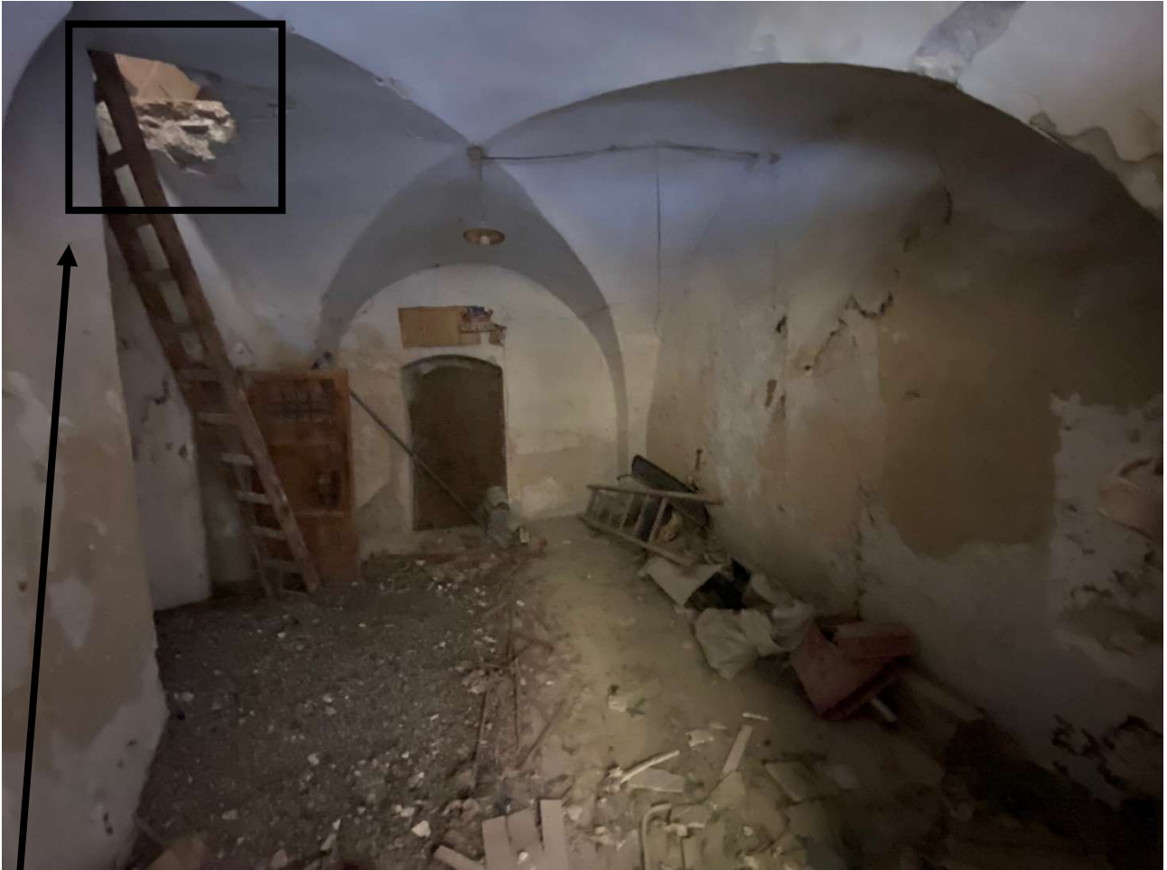
Porzione di solaio crollato, da cui si accede al Piano Primo (tramite scala in legno)
