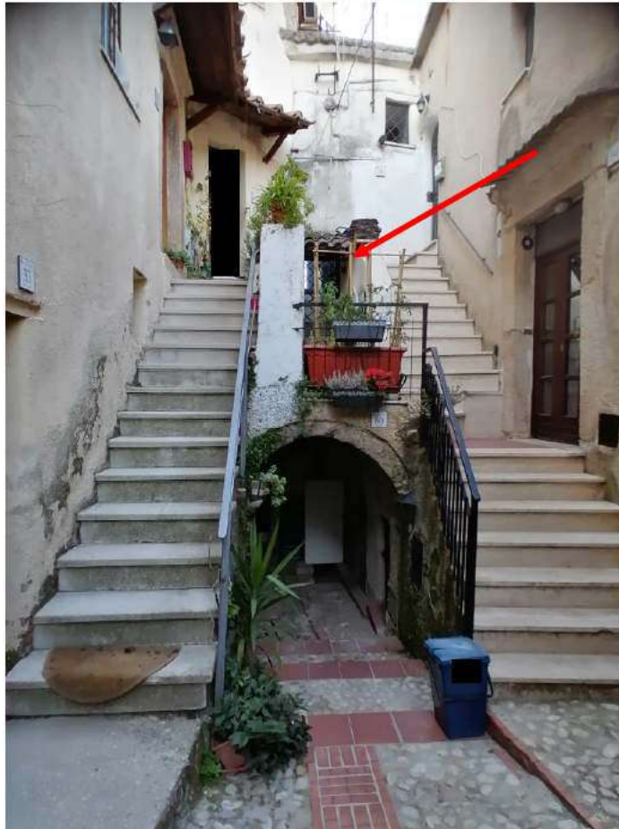
FOTO N°03: Zona di accesso alla U.I.
