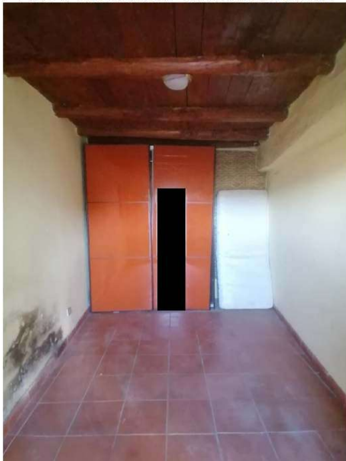
FOTO N°10: Camera U.I. – vista verso muro di fondo.
