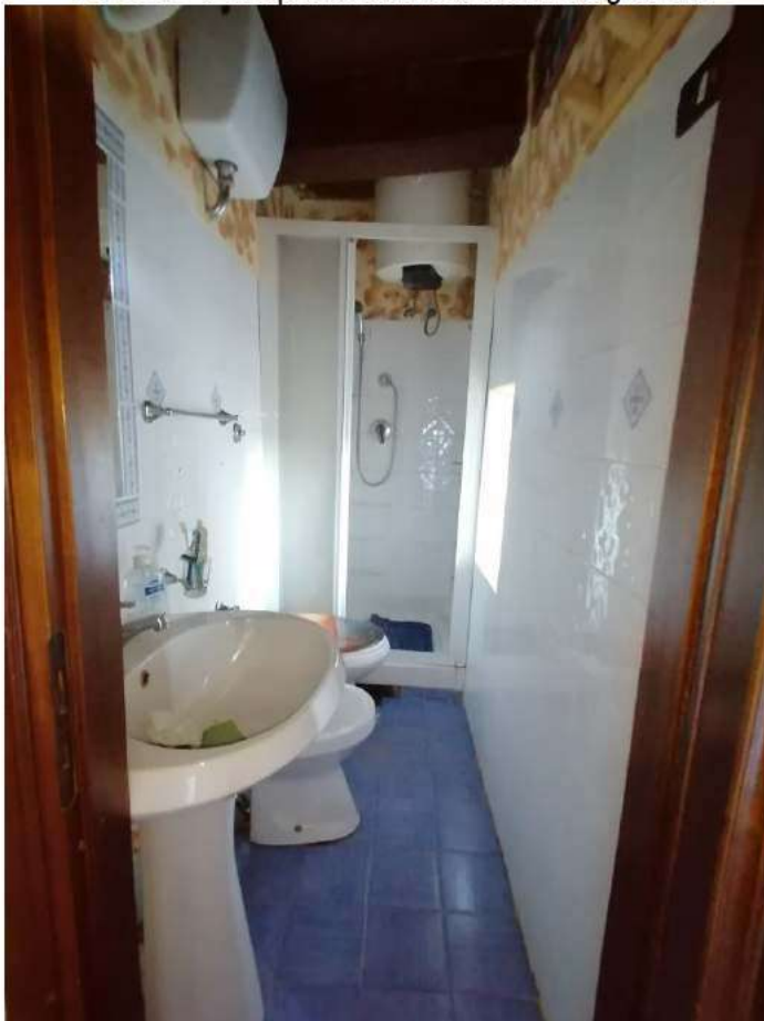
FOTO N°12: Inquadramento del servizio igienico.
