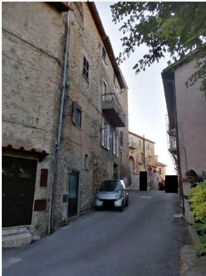
FOTO N°02: Prospetto su strada – Vista Nord.
