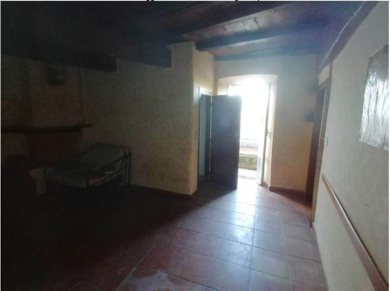
FOTO N°09: Soggiorno – Vista verso bagno e portafinestra.
