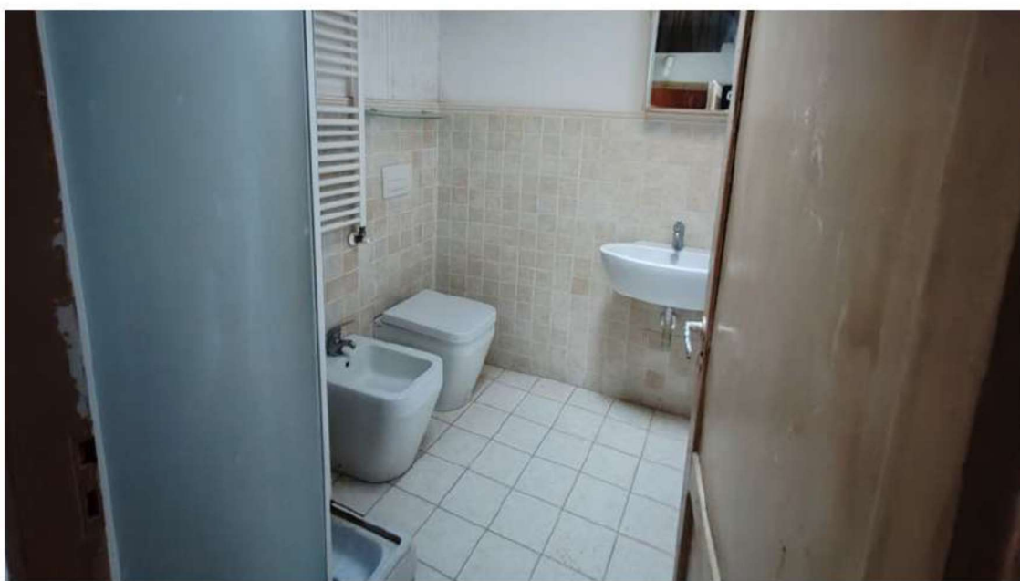
foto 38 - vista del bagno (LOTTO 3).
