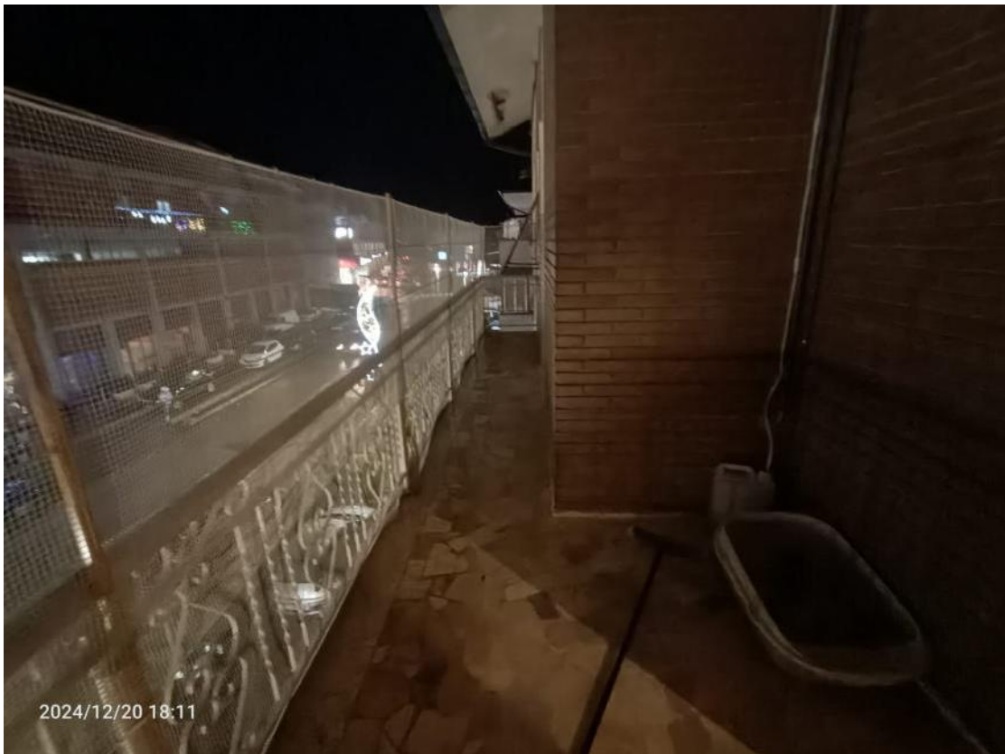
Comune di Montegranaro, Foglio 17 Particella 219 sub 5; balcone piano 2°
