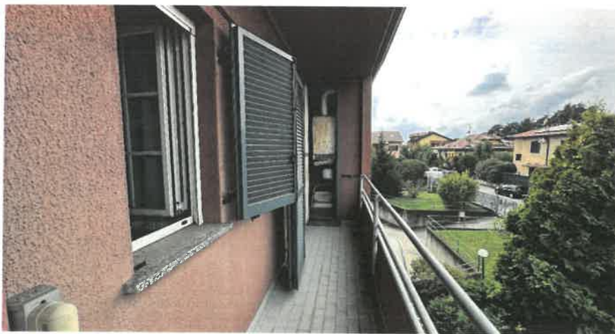
Foto 9: balcone piano primo
