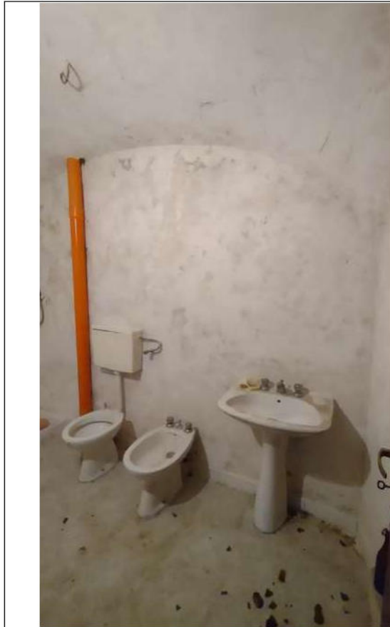
Foto n. 22 - Bagno (piano terra)
