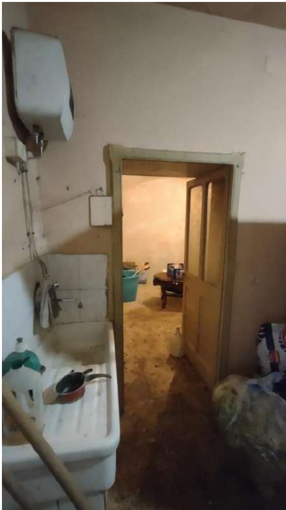
Foto n. 17 – Cantina 1 (piano terra)
