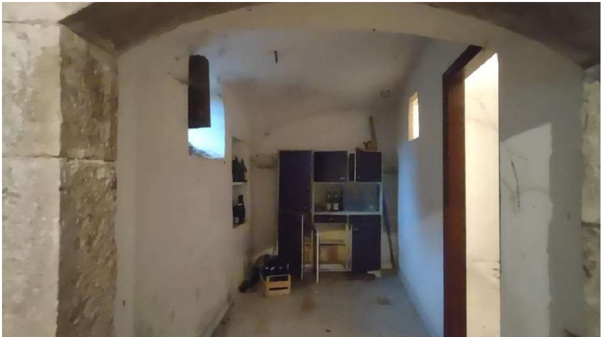
Foto n. 21 - Ripostiglio (piano terra)
