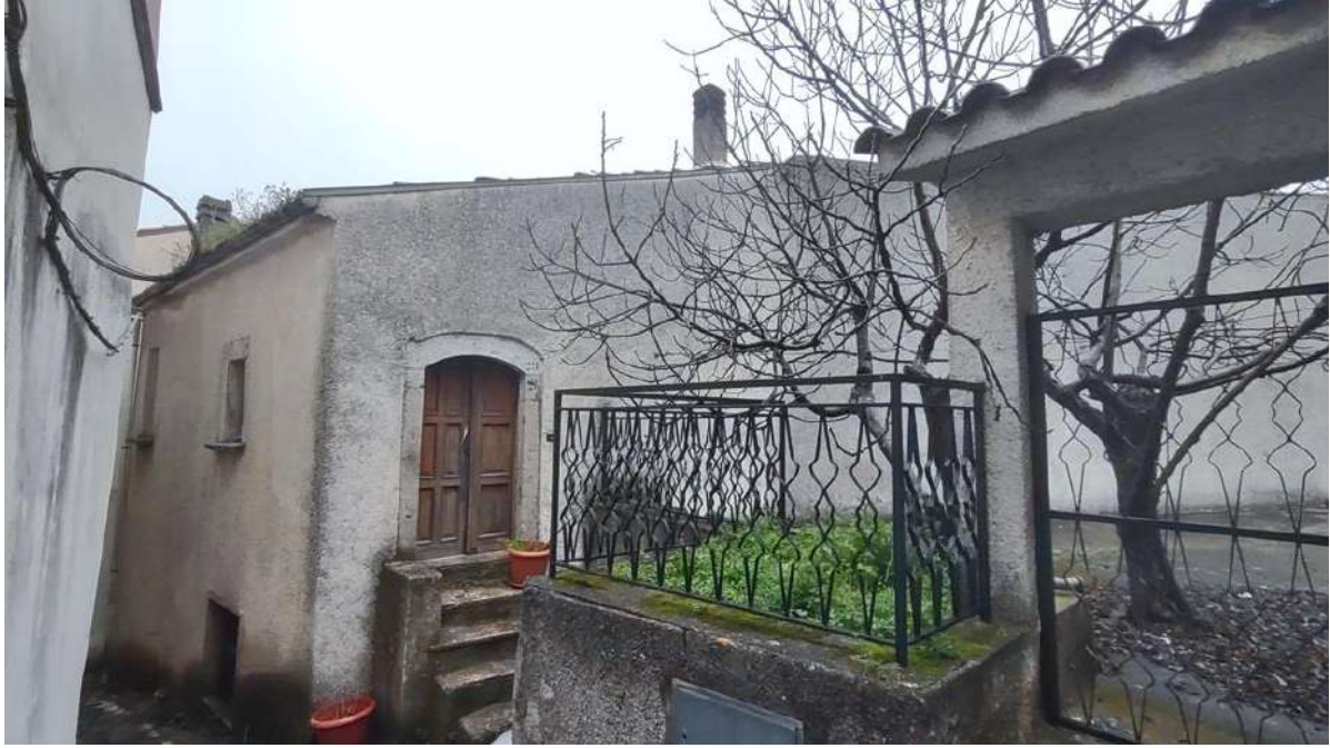
Foto n. 1 – Ingresso piano primo
