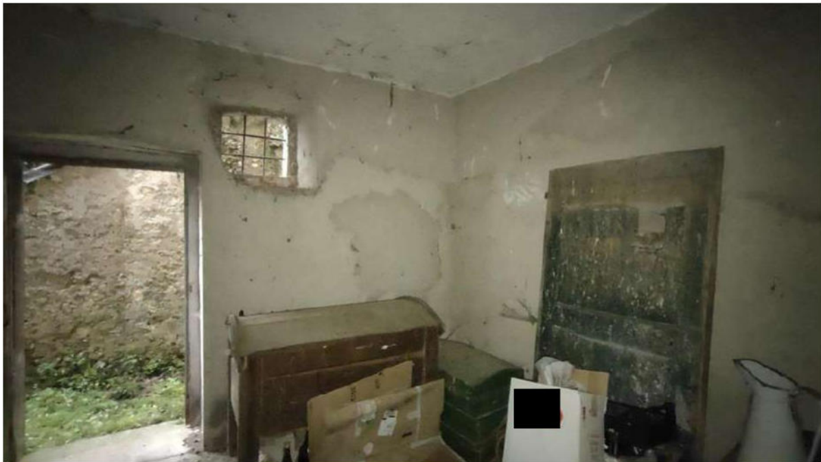
Foto n. 24 – Cantina 3 (piano terra)
