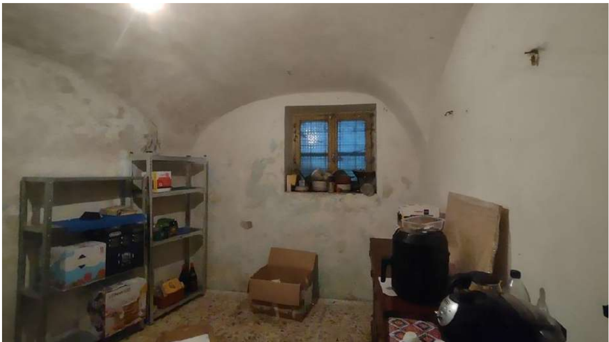
Foto n. 19 - Cantina 2 (piano terra)
