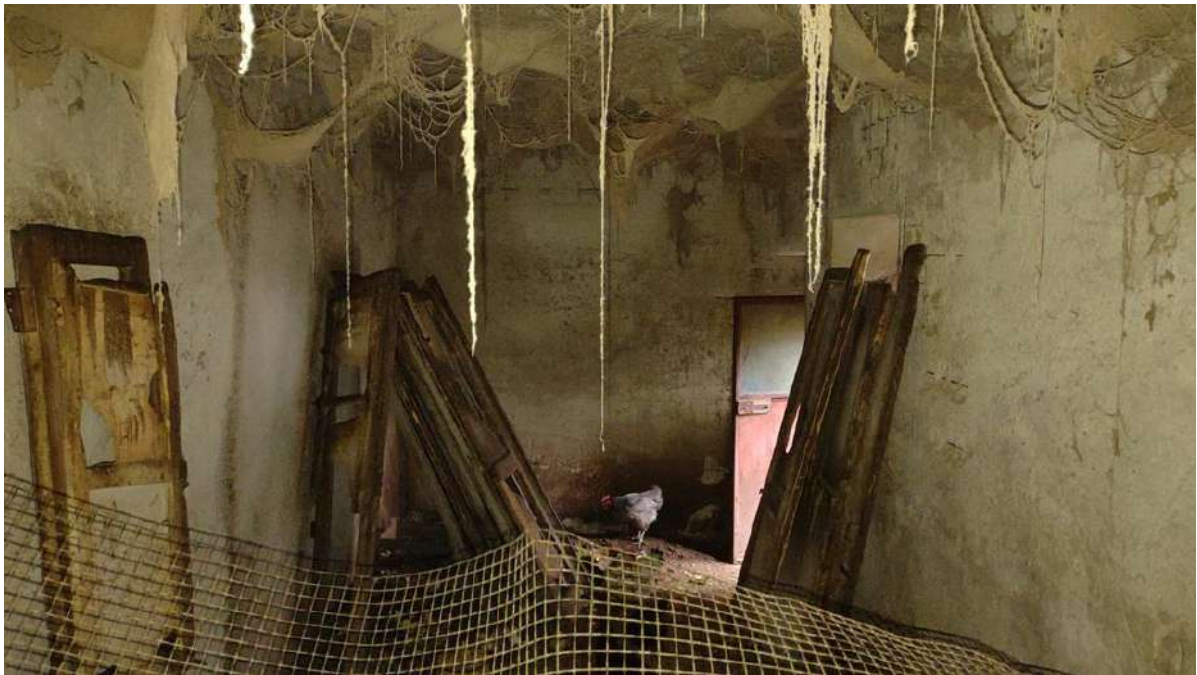
Foto n. 28 – Stalla Sub. 1 (piano terra)
