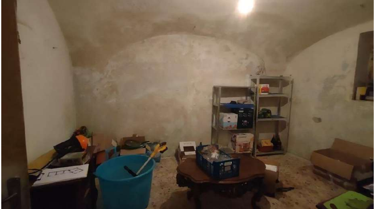
Foto n. 18 – Cantina 2 (piano terra)
