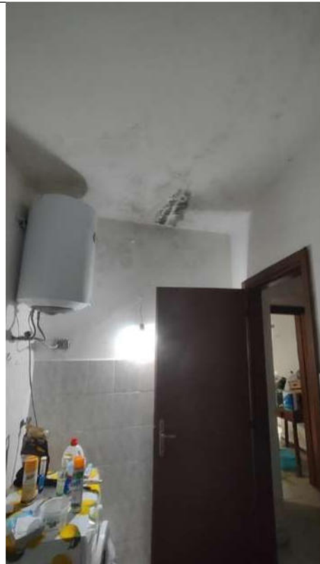
Foto n. 11 – Bagno (piano primo)
