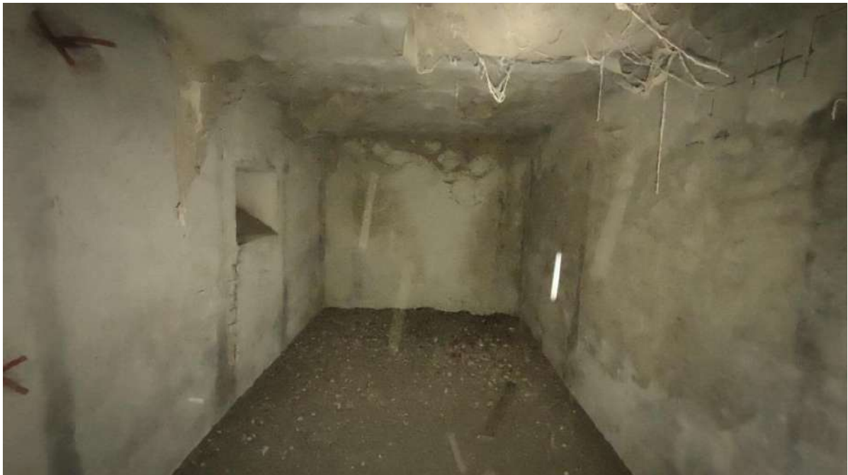
Foto n. 26 – Stalla Sub. 2 (piano terra)
