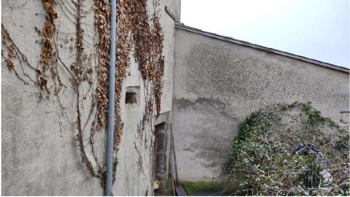
Foto n. 27 – Accesso Stalla Sub. 1 (piano terra)
