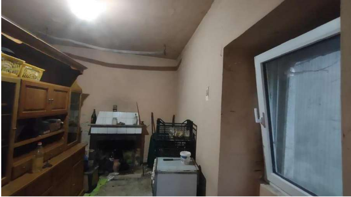
Foto n. 16 – Cantina 1 (piano terra)
