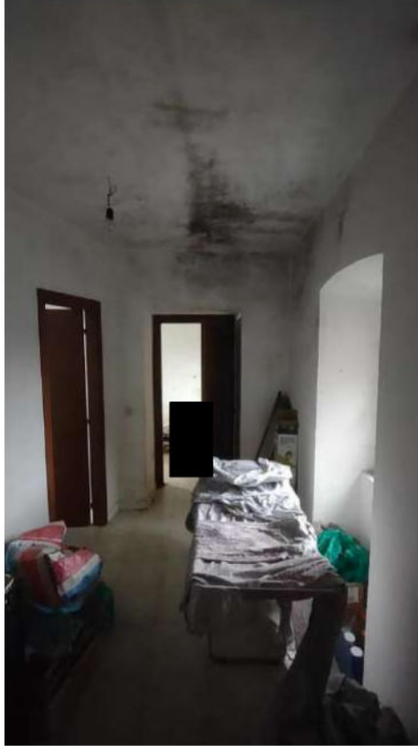
Foto n. 12 – Disimpegno 2 (piano primo)
