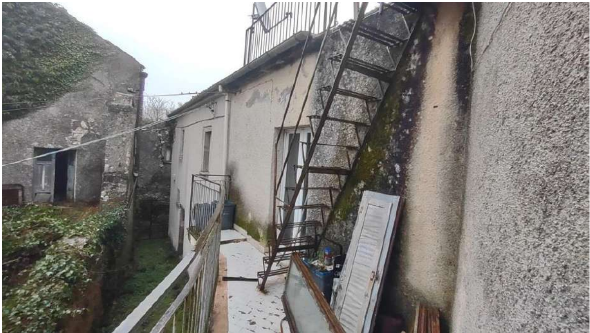
Foto n. 15 - Balcone (piano primo)
