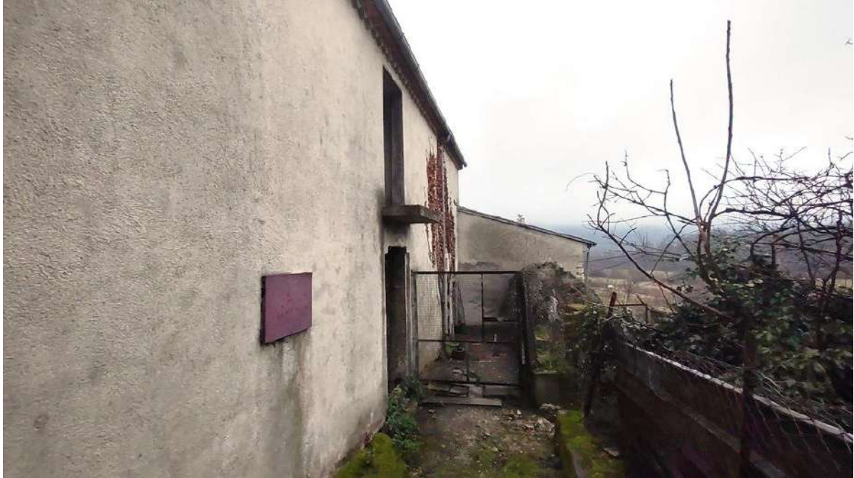
Foto n. 25 – Accesso Stalla Sub. 2 (piano terra)
