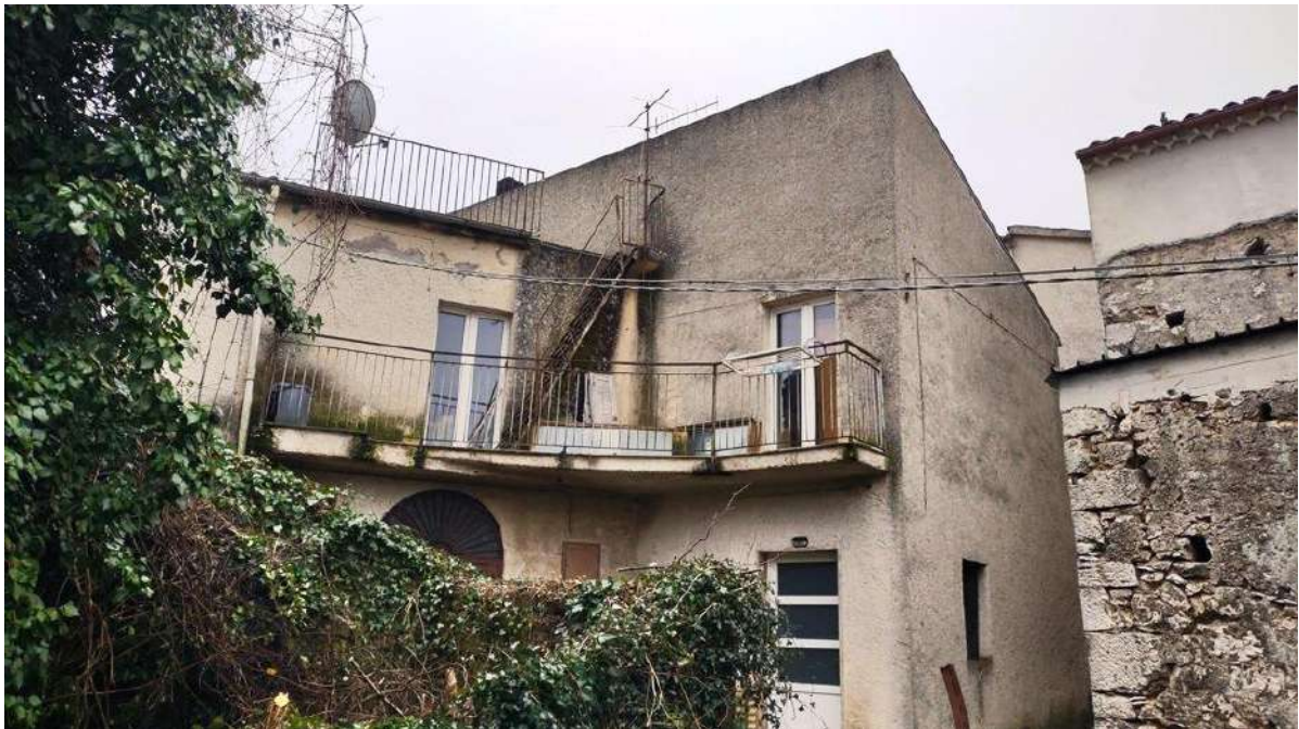
Foto n. 4 – Ingressi piano terra - Spigolo Nord Ovest
