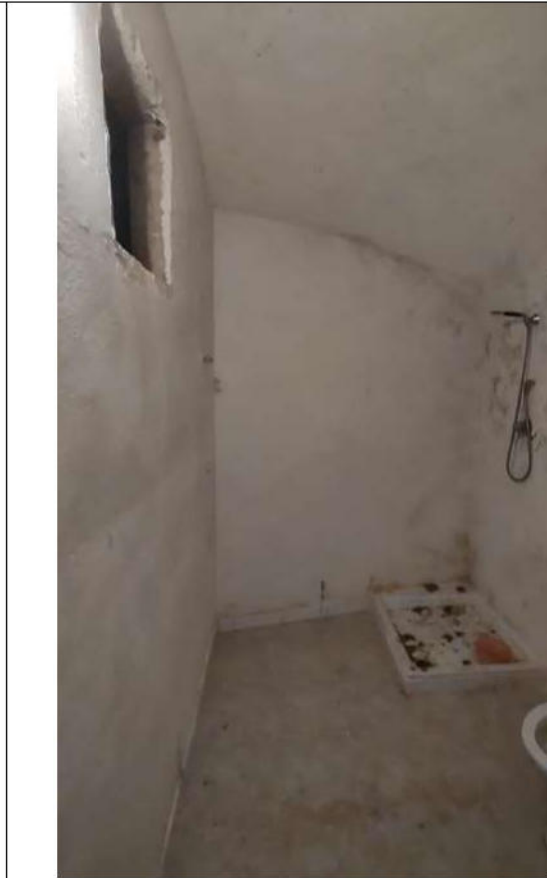
Foto n. 23 - Bagno (piano terra)
