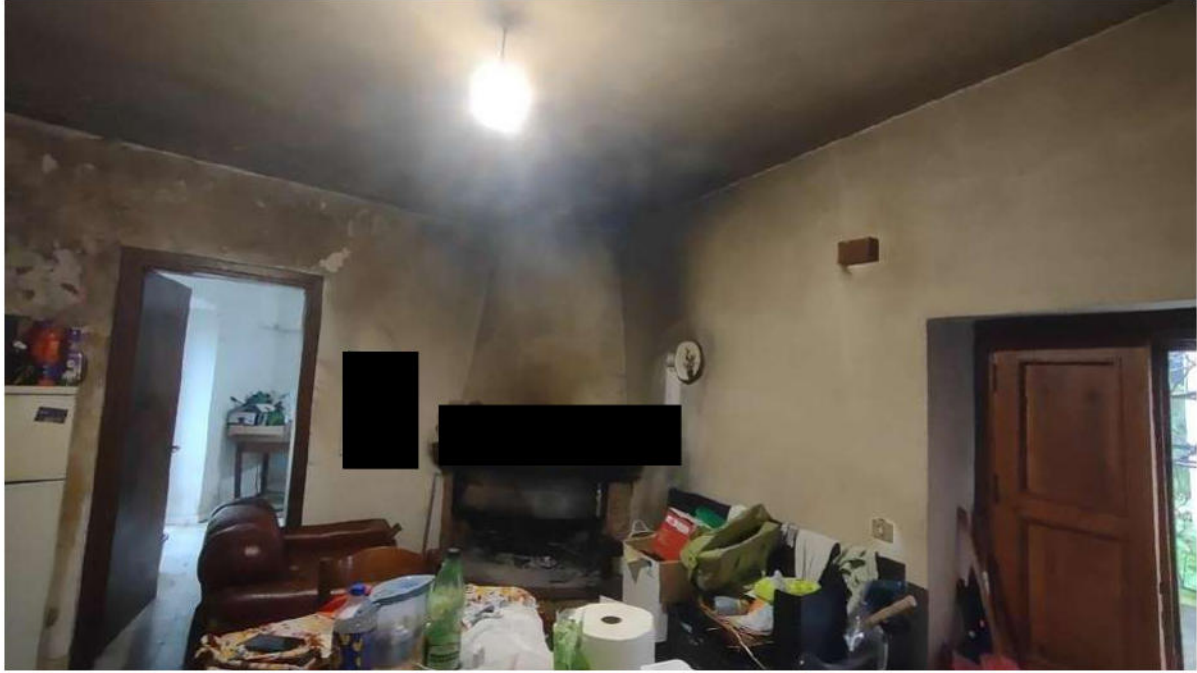
Foto n. 7 – Cucina (piano primo)
