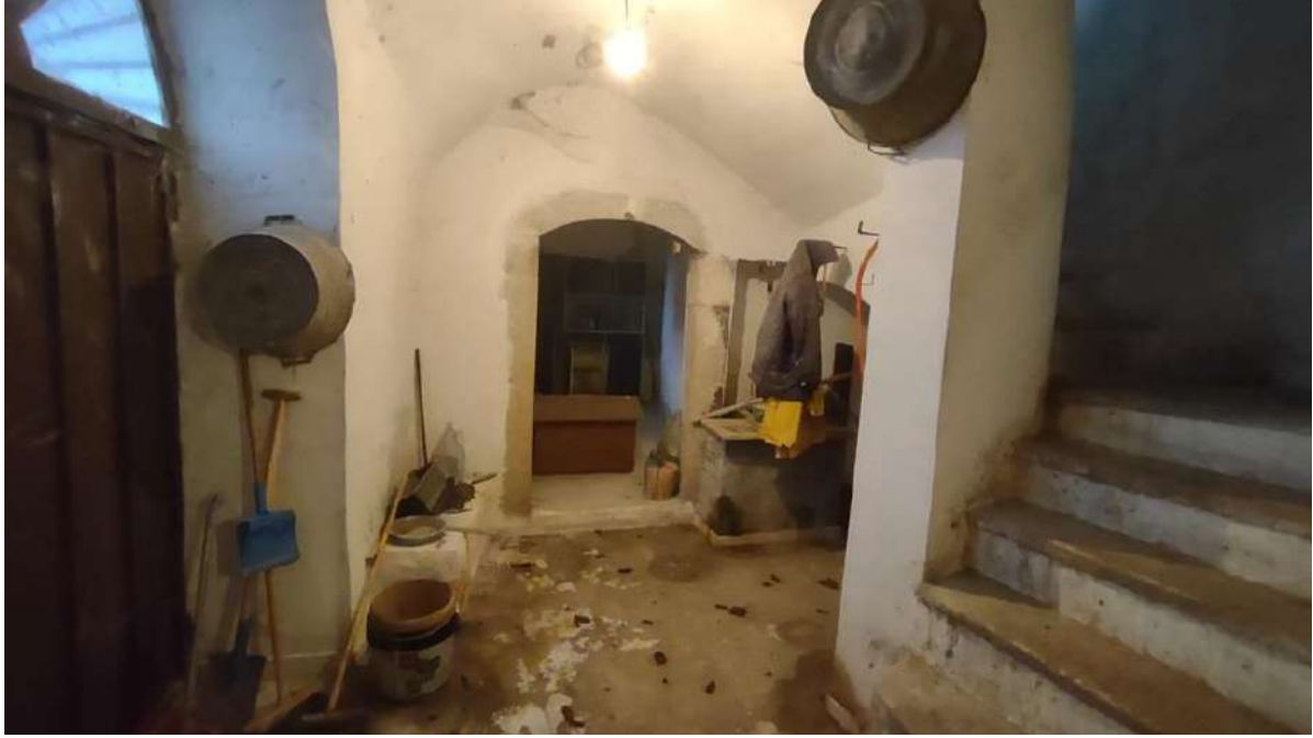
Foto n. 20 - Ingresso (piano terra)
