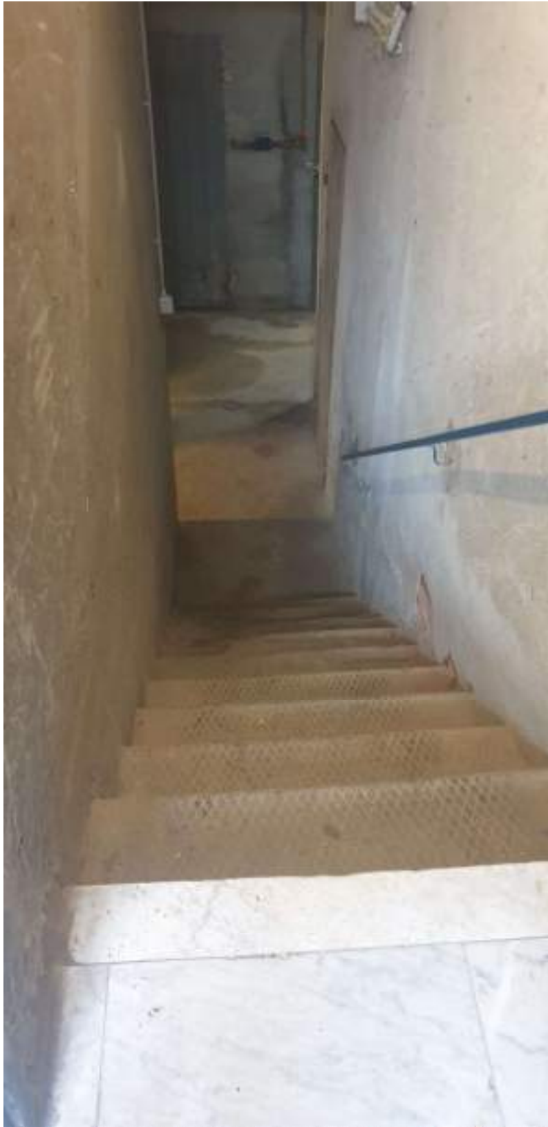
Vano scala di accesso al piano cantinato
