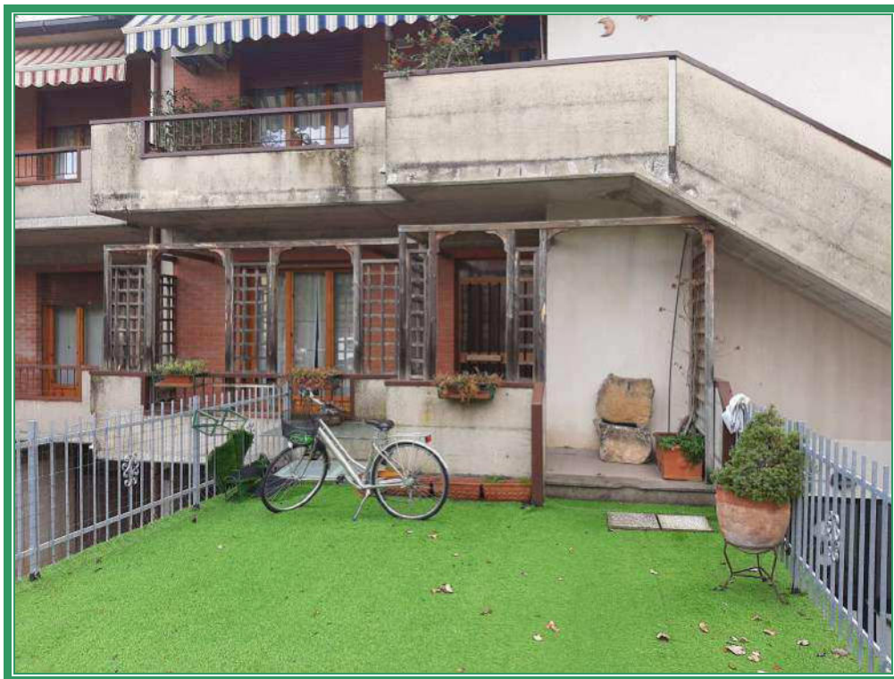
Foto 4) Particolare frontale dell'appartamento oggetto di esecuzione immobiliare
