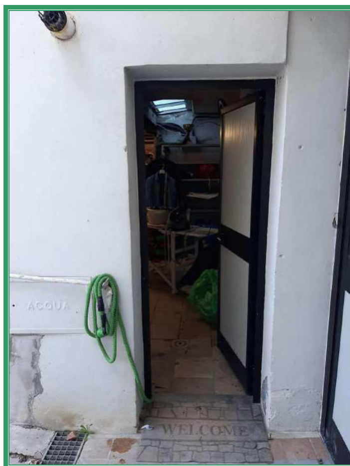
Foto 32) Particolare porta cantina da intercludere
