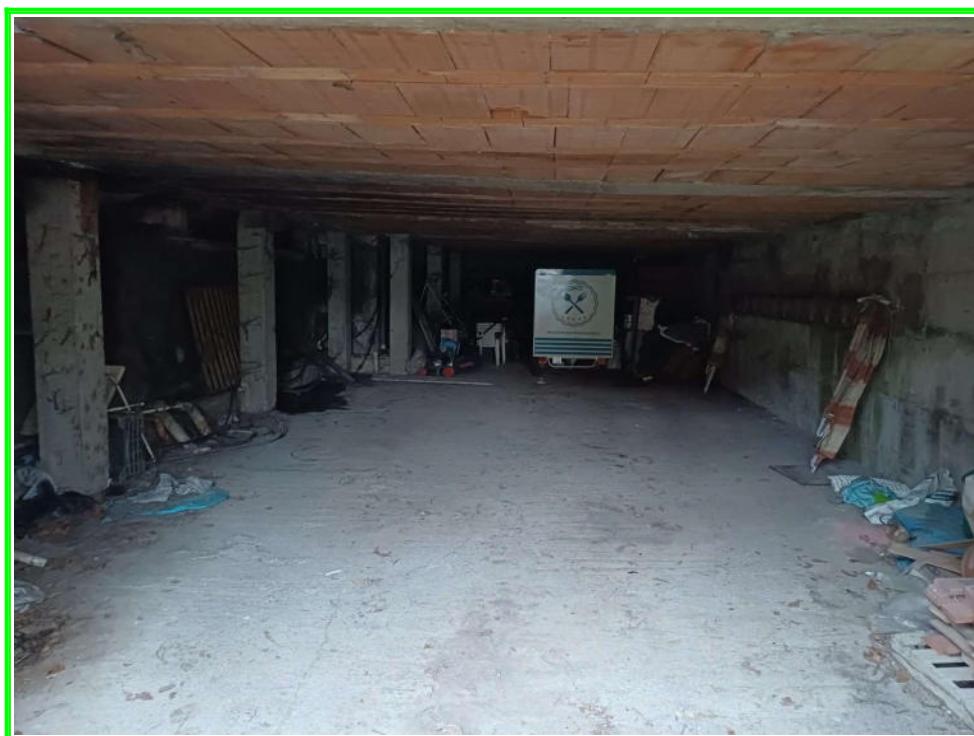
Foto 4) Veduta generale del garage
