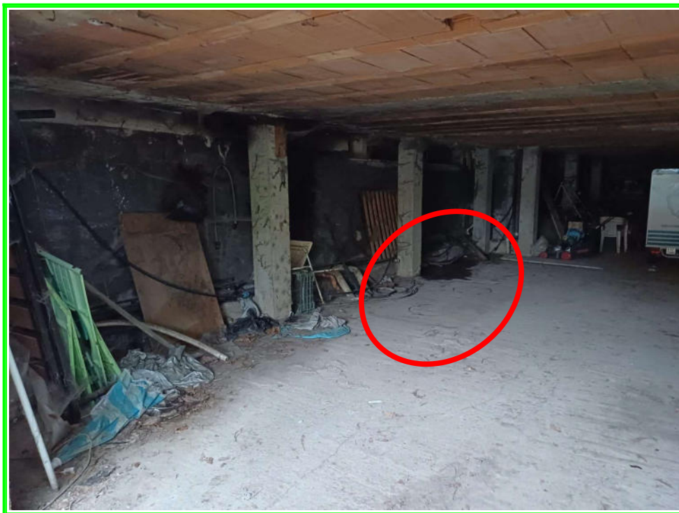
Foto 5) Veduta della porzione laterale del garage e zona di installazione fosse biologiche
