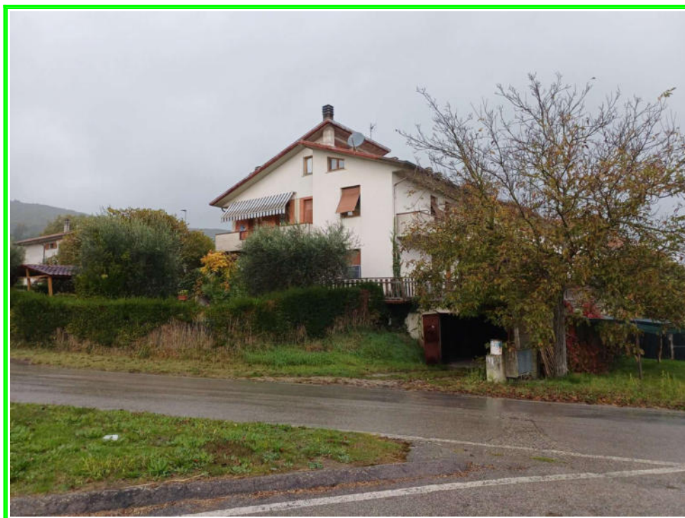
Foto 1) Veduta d'insieme del fabbricato e del garage pertinenziale
