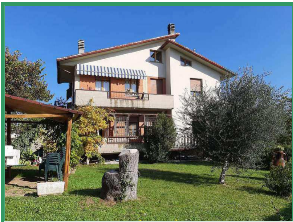
Foto 5) Vista laterale dell'edificio
