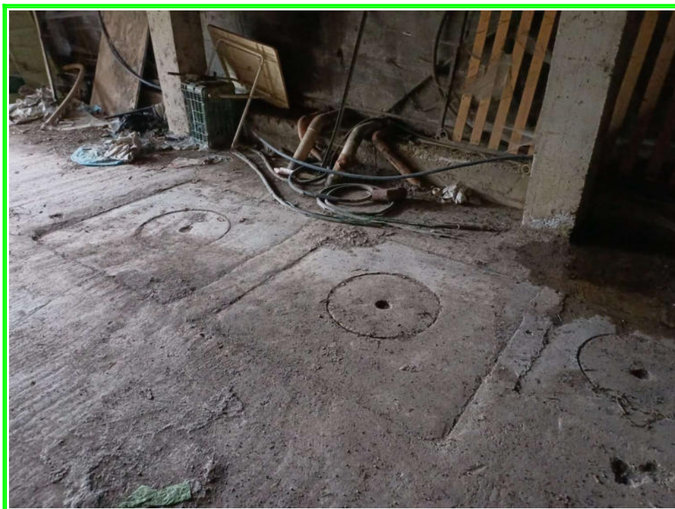
Foto 6) Particolare fosse biologiche
