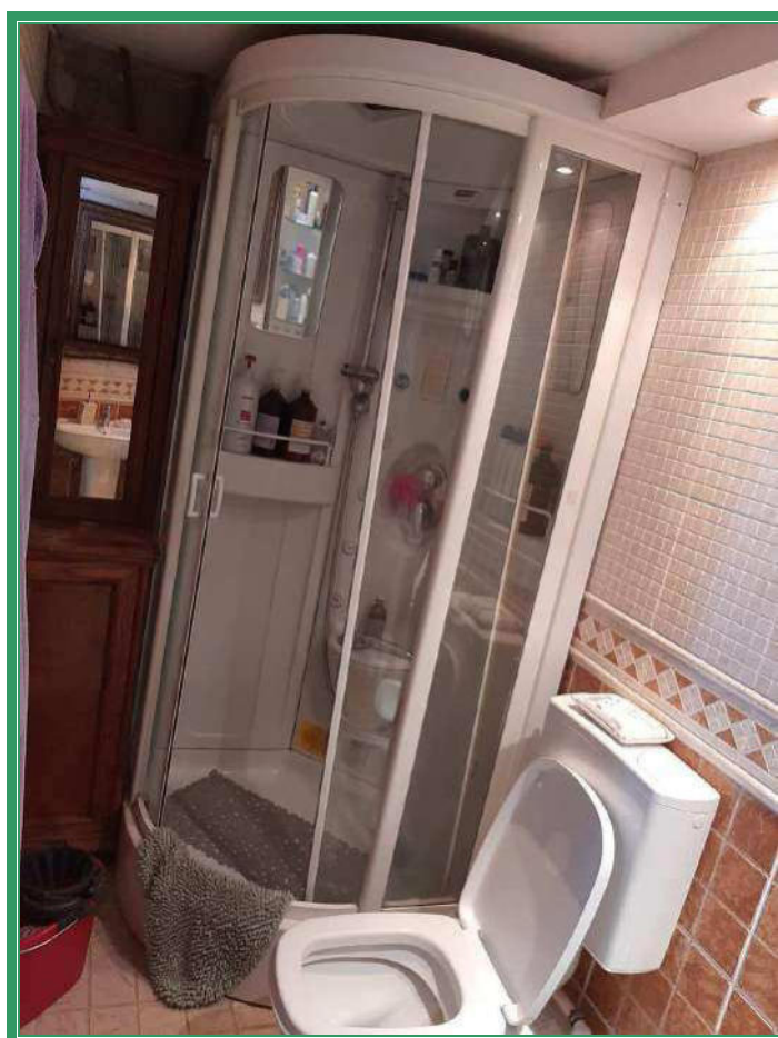
Foto 30) Particolare bagno realizzato in un vano con destinazione pertinenziale del garage (ripostiglio)
