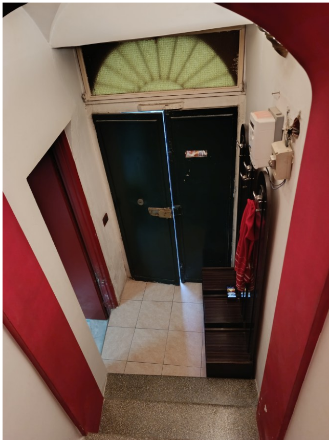
Foto n. 10 – Ingresso piano terra
