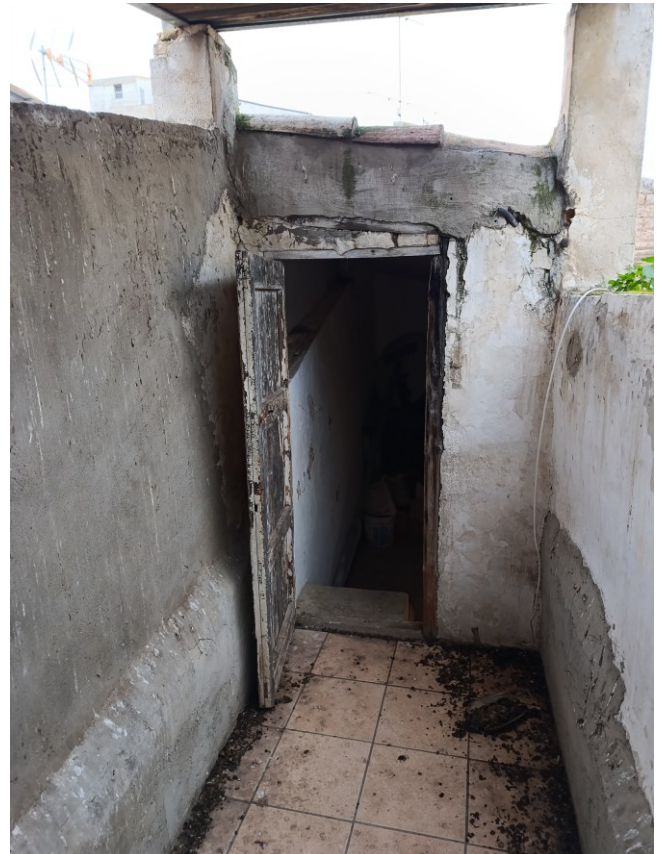
Foto n. 20- Arrivo terrazza copertura
