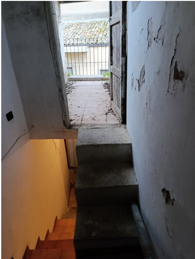
Foto n. 19 Scala accesso copertura
