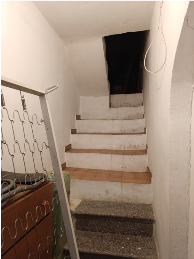
Foto n. 16 Scala accesso sottotetto
