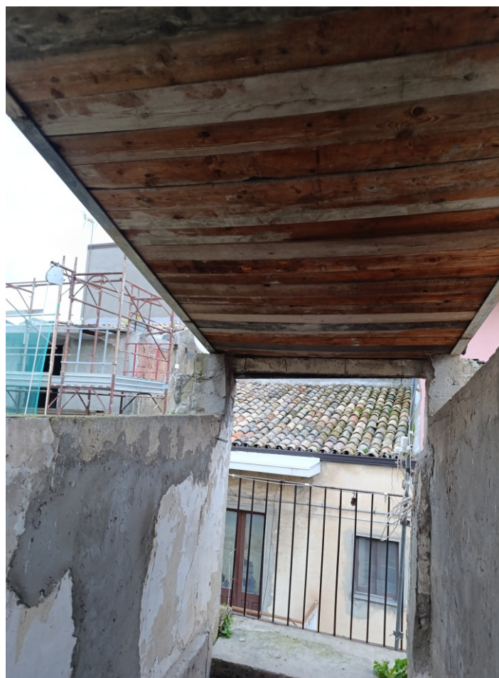
Foto n. 21 - Terrazza piana coperta
