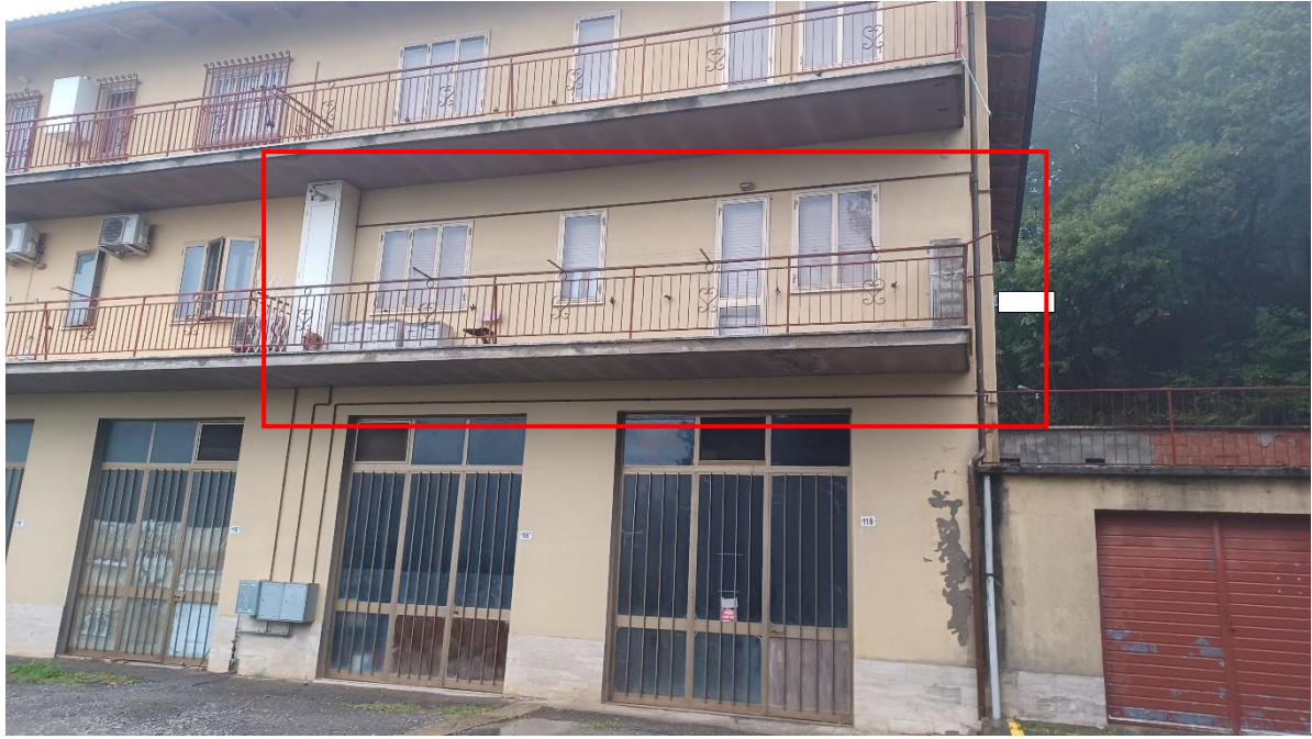
Foto n. 3 – Vista da Via Mario Luzi del prospetto Est dell'appartamento in oggetto (vista del balcone e delle finestre delle camere matrimoniale e del bagno)
