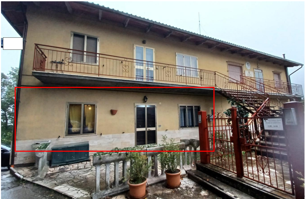
Foto n. 2 – Vista dalla corte comune del prospetto Ovest del fabbricato e dell'ingresso all'appartamento
