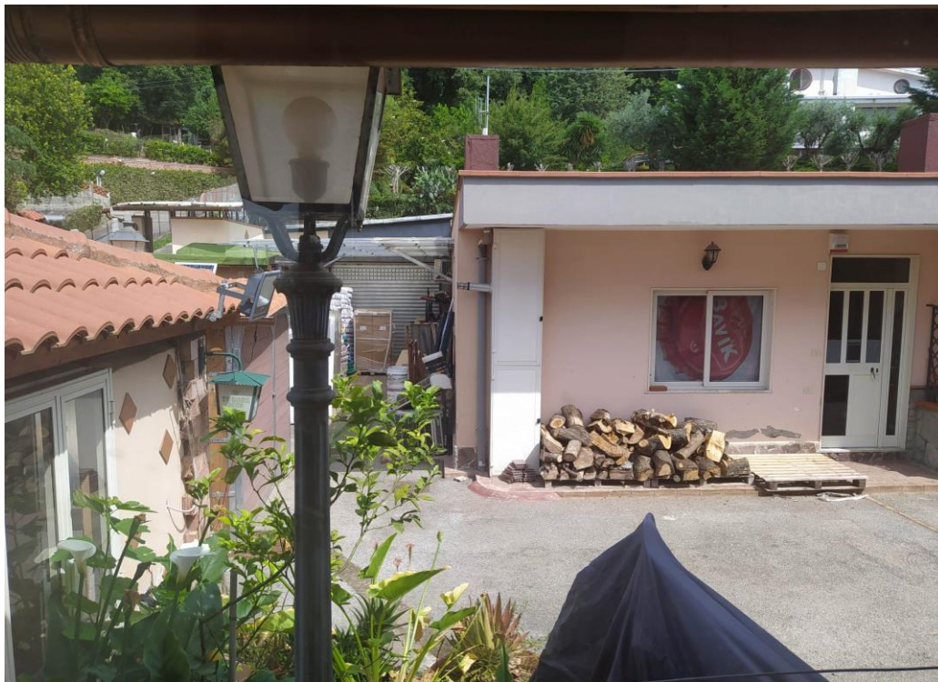
Foto n.18: Vista di altro immobile che ha in comune il piazzale con quello in oggetto
