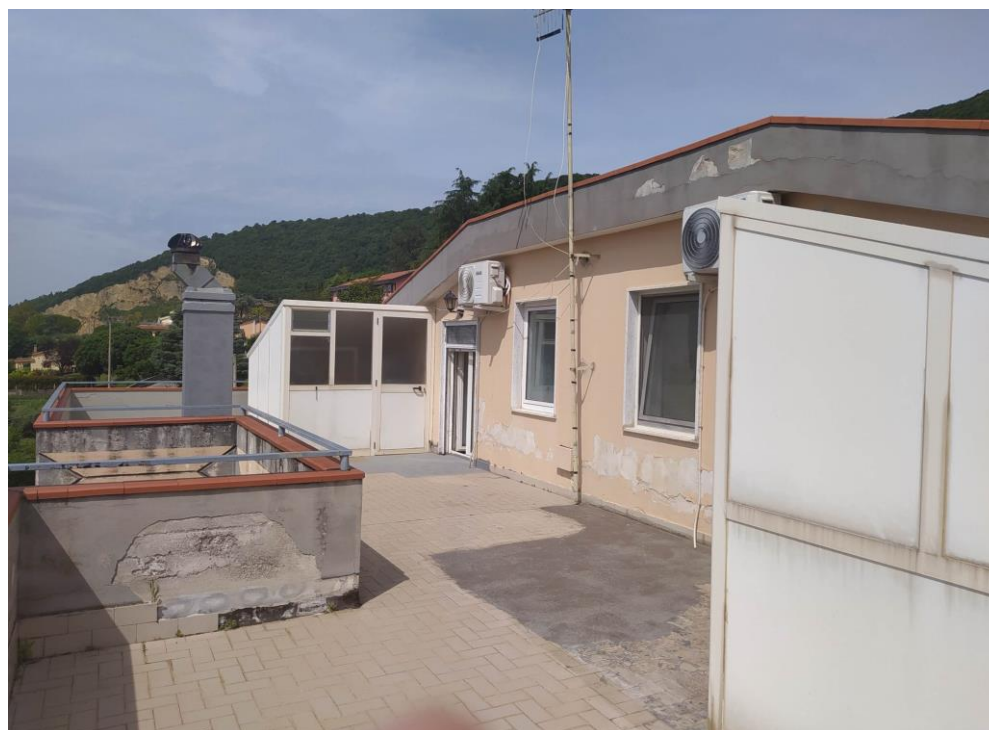
Foto n.17: Vista del terrazzo
