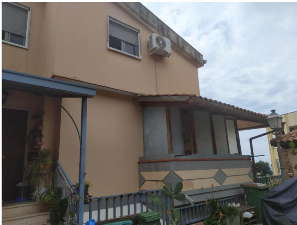
Foto n.12: Vista del balcone chiuso dall'esterno
