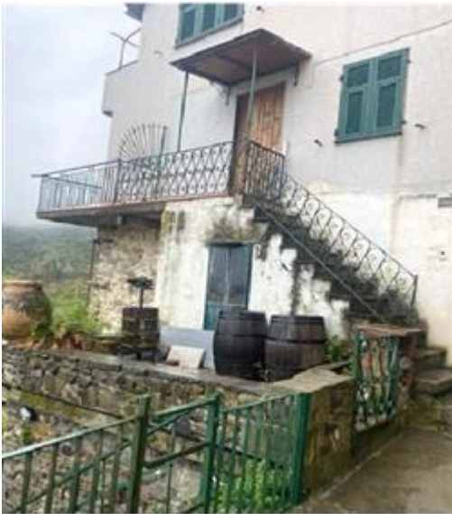
fabbricato di via alla marina
