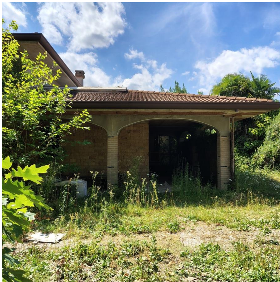
3 - lotto 1 Corpo A portico
