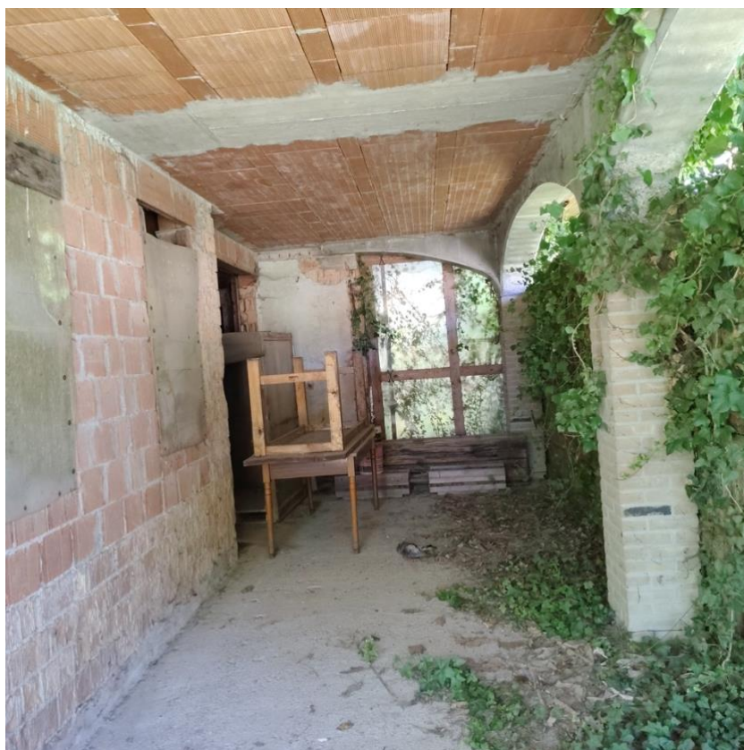
10 - lotto 1 Corpo A portico
