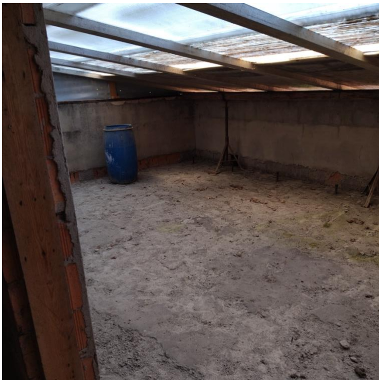
14 lotto 1 - Corpo A terrazza con copertura provvisoria
