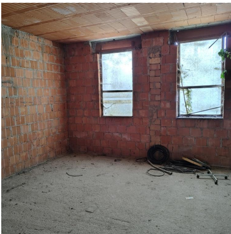
27 - lotto 1 Corpo C ripostiglio p.1
