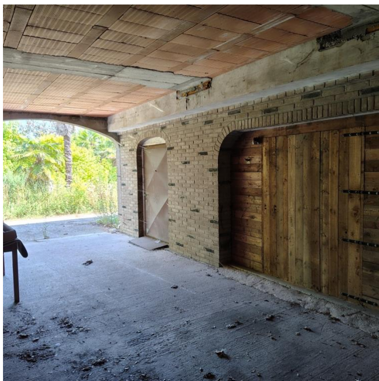
17 - lotto 1 Corpo B autorimessa
