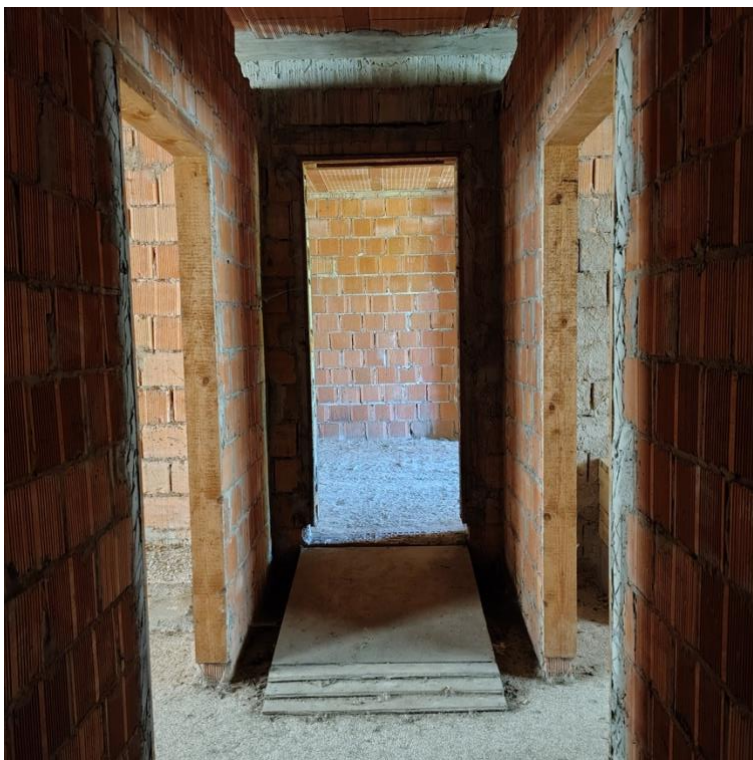
26 - lotto 1 Corpo C ripostiglio agricolo p.1
