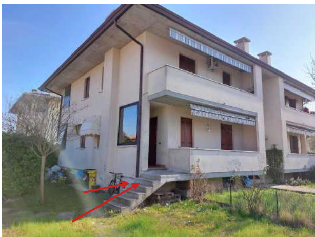
Vista accesso appartamento
