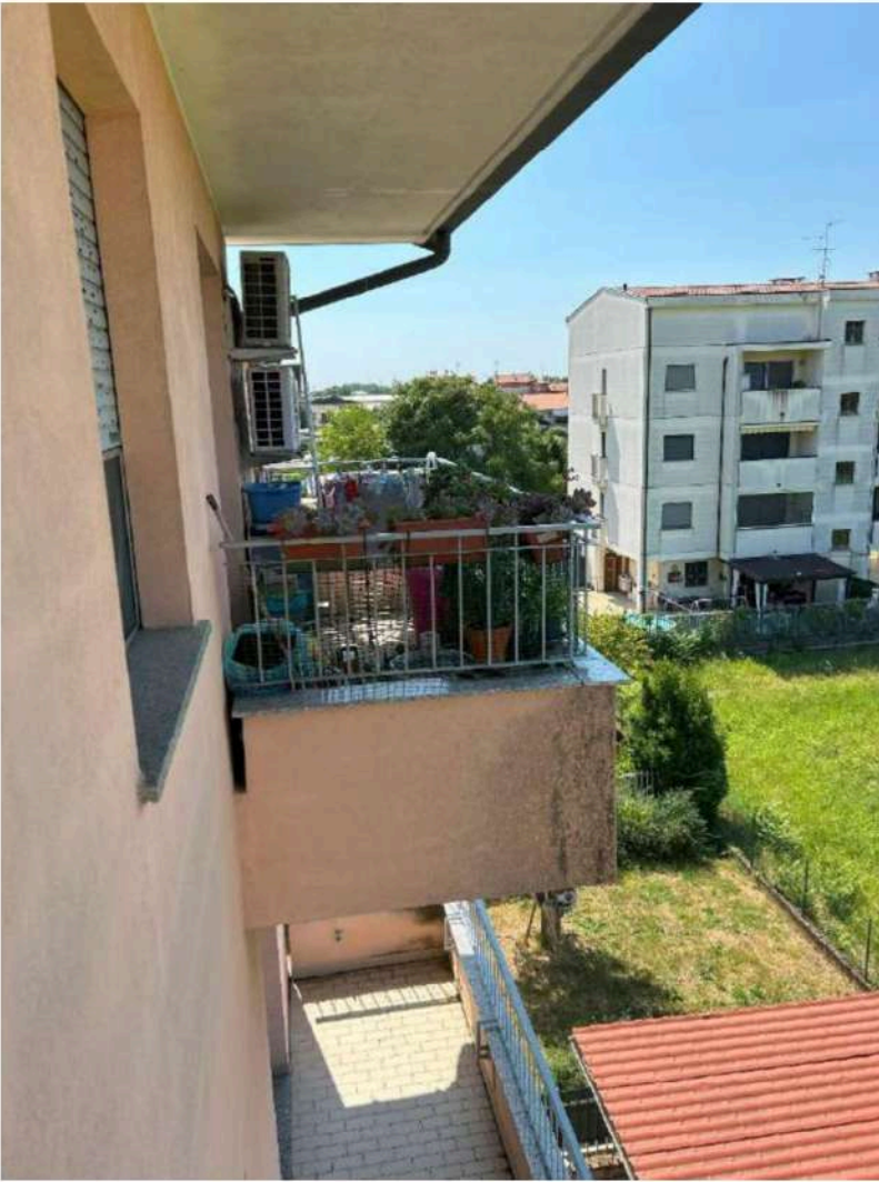
11 – Balcone lato camera matrimoniale
