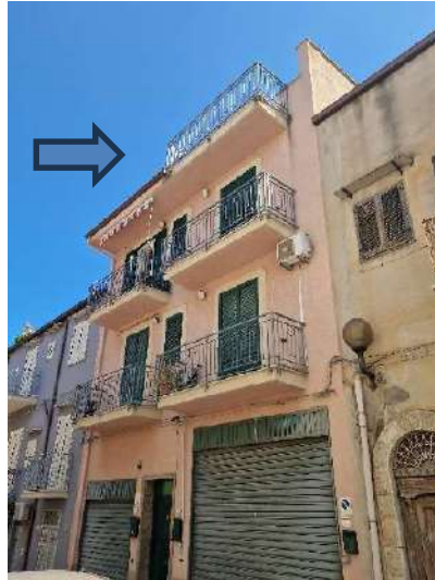
Esterno - Prospetto su Via IV Novembre
