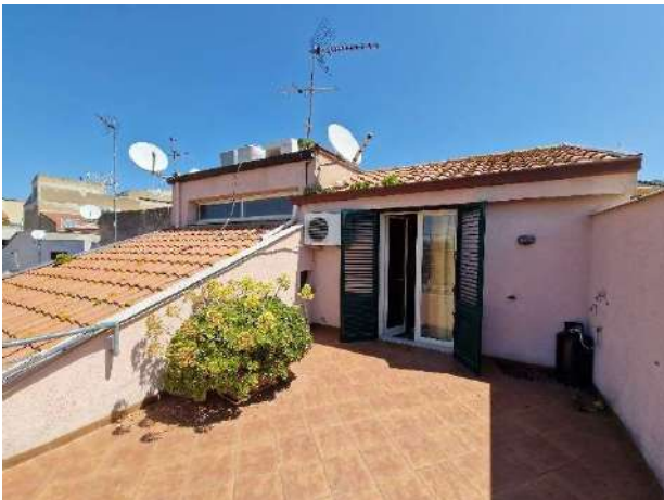
Esterno - Terrazzo a livello su Via IV Novembre
