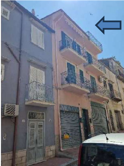
Esterno - Prospetto su Via IV Novembre
