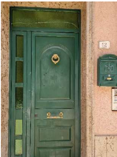
Esterno – Portoncino d'ingresso su Via IV Novembre
