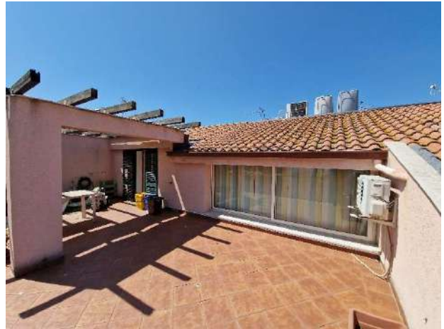
Esterno - Terrazzo a livello su Via Rosselli
