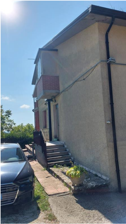
Foto 5: Entrata al vano scale dalla corte a nord-est.
