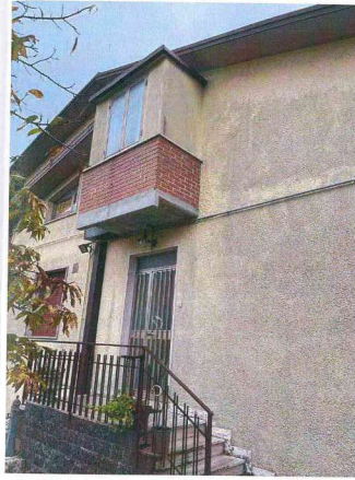
FOTO - DETTAGLIO N. 2
