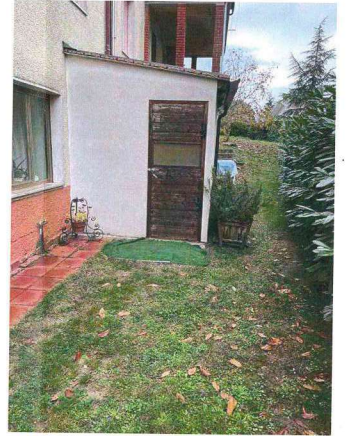
FOTO - DETTAGLIO N. 1
