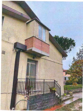
FOTO - DETTAGLIO N. 2
