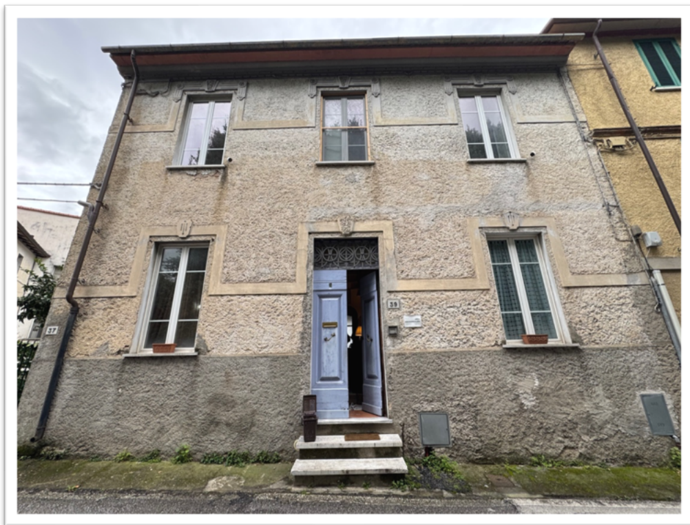
1. Prospetto Principale – Via Corce Verde n. 39
