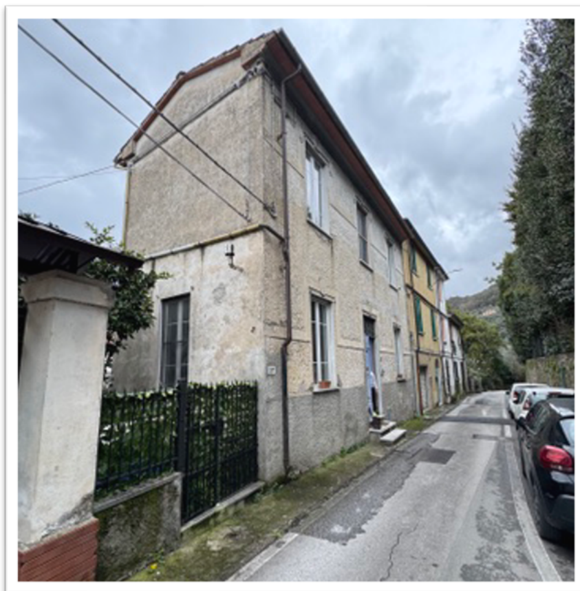
3. Prospetto Principale - Via Corce Verde n. 37 -39
