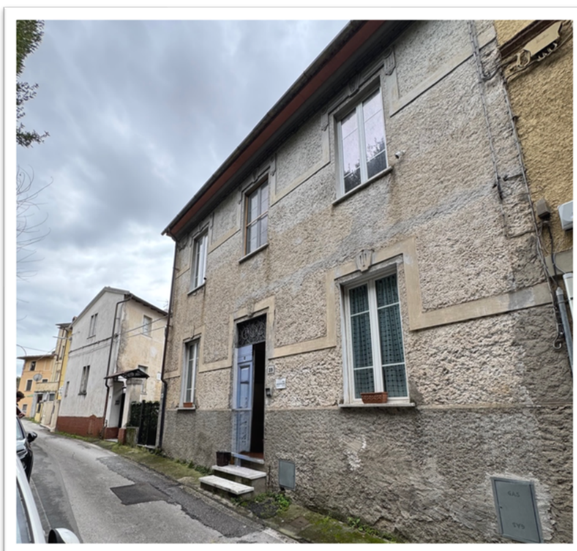
4. Prospetto Principale - Via Corce Verde n. 37 -39
