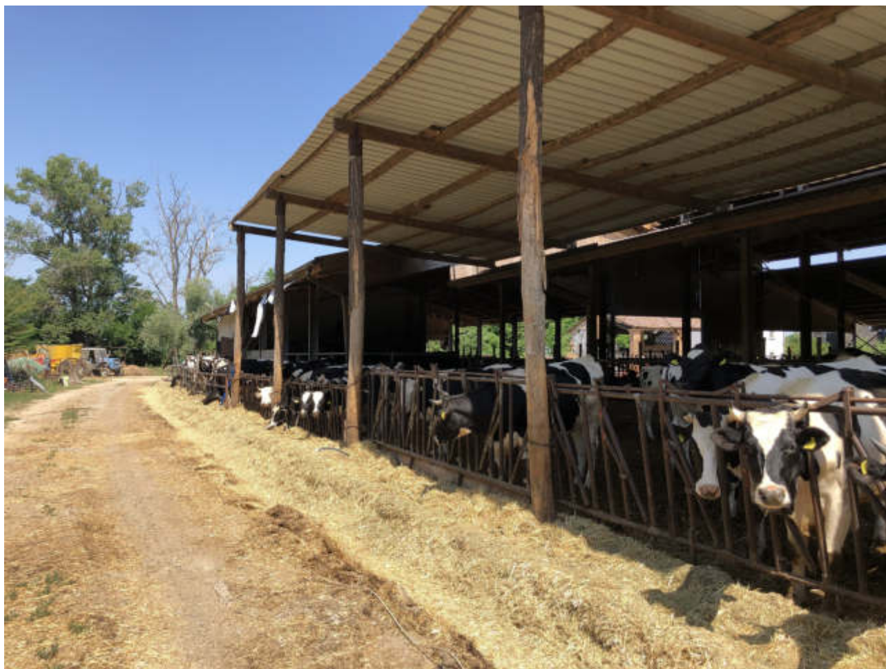
FOTO N. 24 VISTA ESTERNA - FGL. 10, MAPP. 283, SUB. 1
