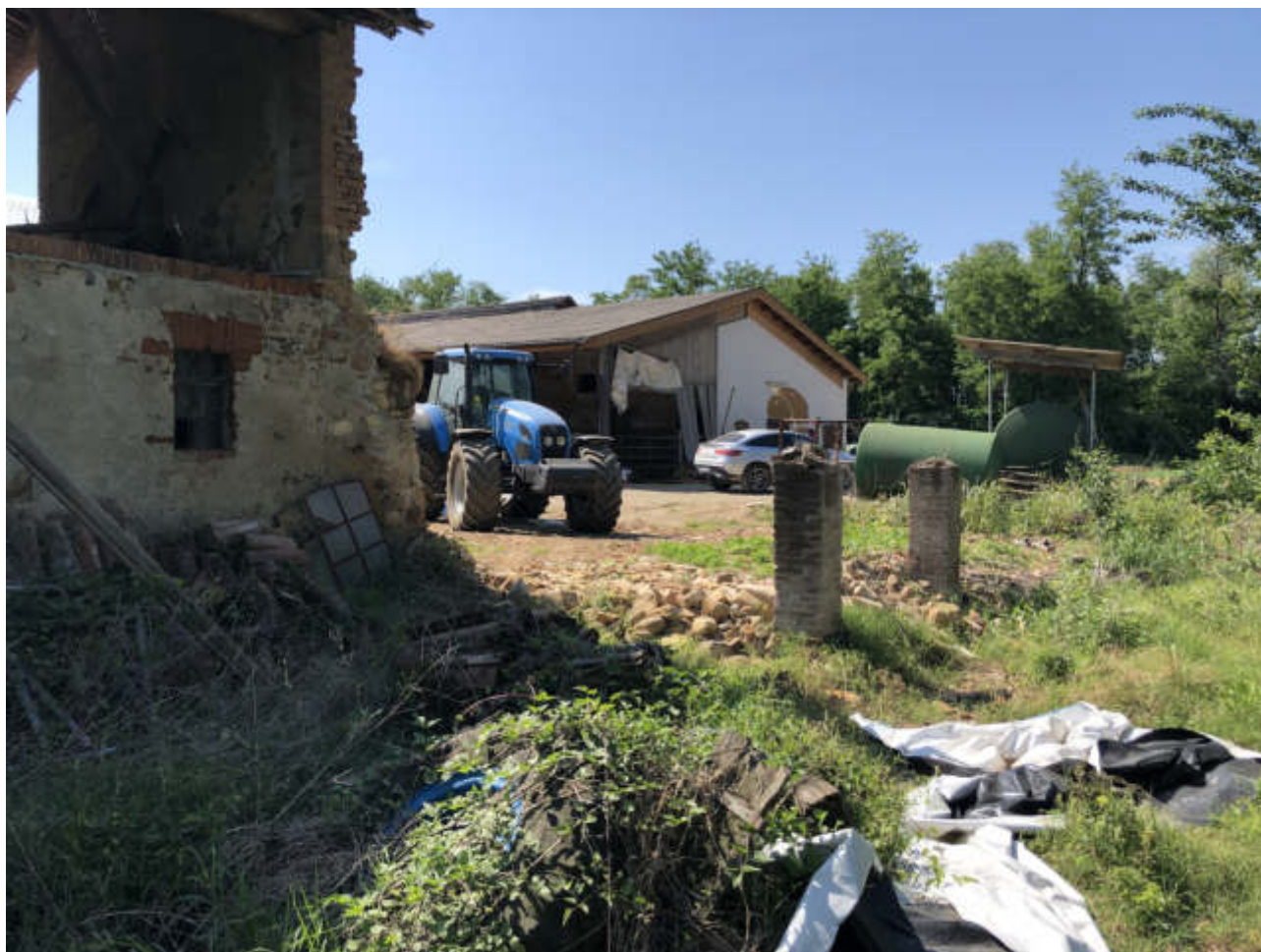
FOTO N. 30 VISTA ESTERNA - FGL. 10, MAPP. 283, SUB. 3
