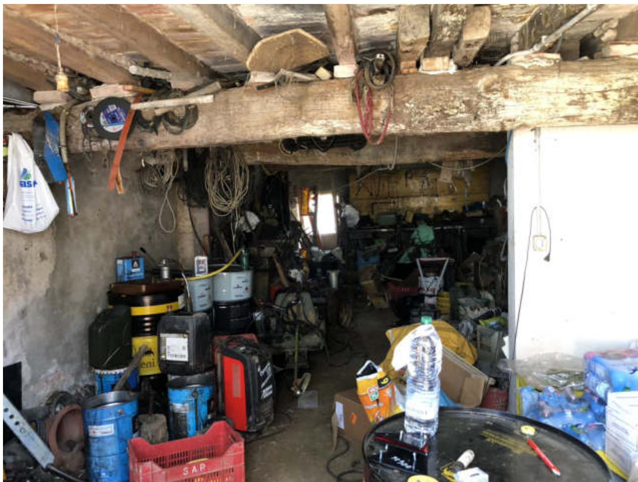
FOTO N. 34 VISTA INTERNA - FGL. 10, MAPP. 283, SUB. 3
