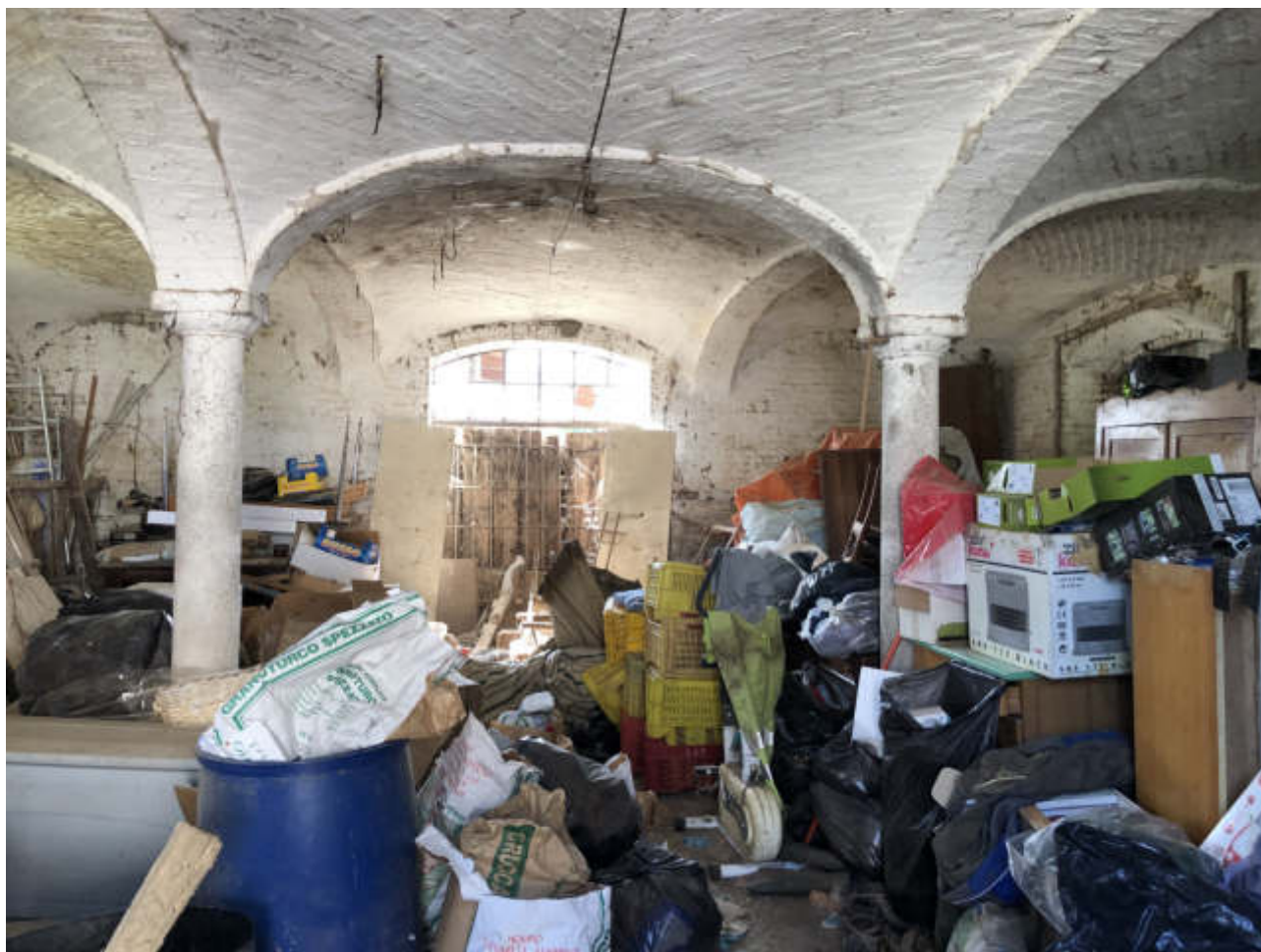
FOTO N. 14 VISTA INTERNA - FGL. 10, MAPP. 283, SUB. 1
