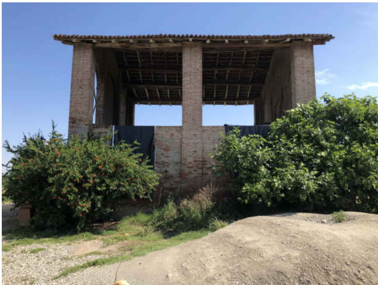
FOTO N. 12 VISTA ESTERNA - FGL. 10, MAPP. 283, SUB. 1
