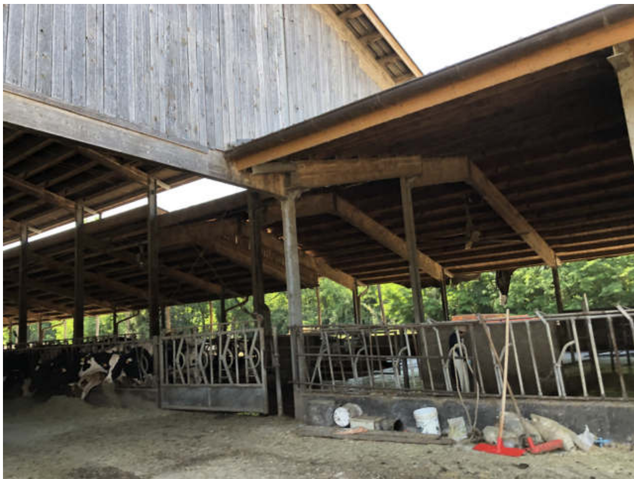
FOTO N. 28 VISTA ESTERNA - FGL. 10, MAPP. 283, SUB. 1
