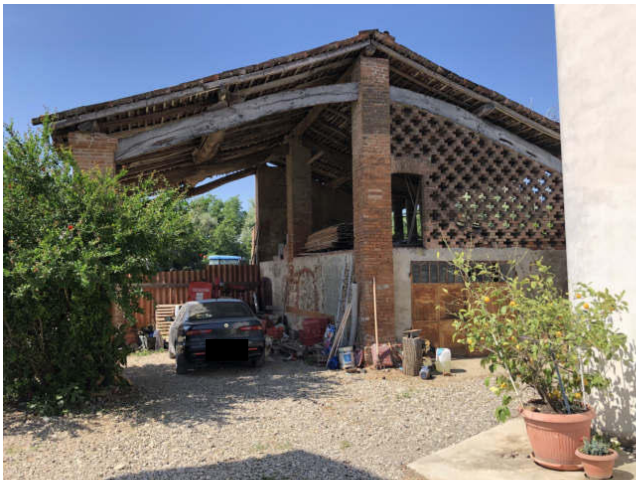
FOTO N. 29 VISTA ESTERNA - FGL. 10, MAPP. 283, SUB. 3
