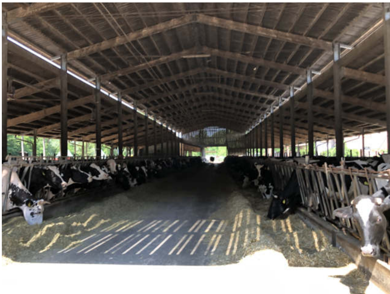
FOTO N. 23 VISTA INTERNA - FGL. 10, MAPP. 283, SUB. 1
