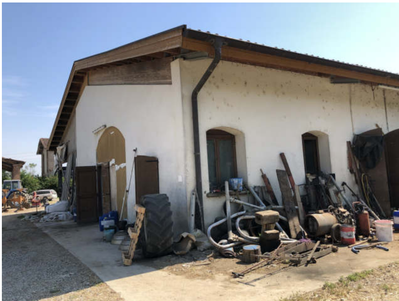
FOTO N. 25 VISTA ESTERNA - FGL. 10, MAPP. 283, SUB. 1
