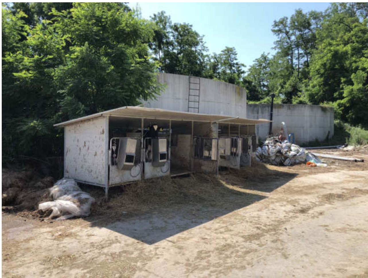
FOTO N. 22 VISTA ESTERNA - FGL. 10, MAPP. 283, SUB. 1
