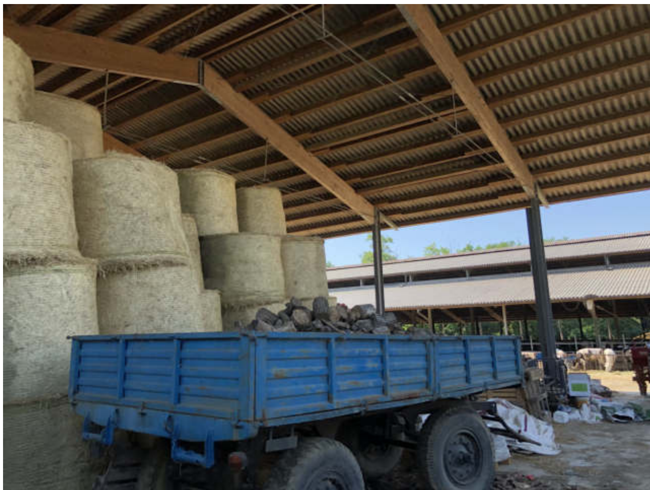
FOTO N. 16 VISTA INTERNA - FGL. 10, MAPP. 283, SUB. 1
