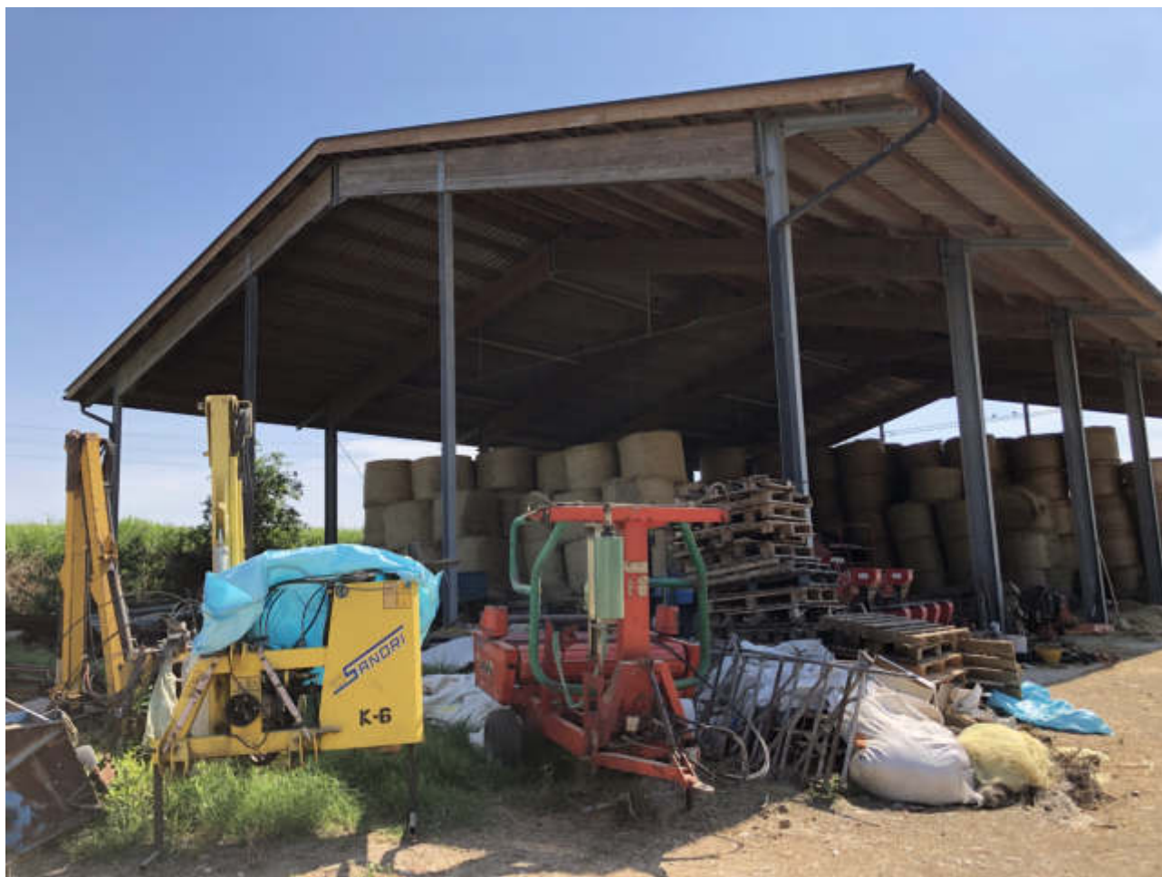
FOTO N. 15 VISTA ESTERNA - FGL. 10, MAPP. 283, SUB. 1
