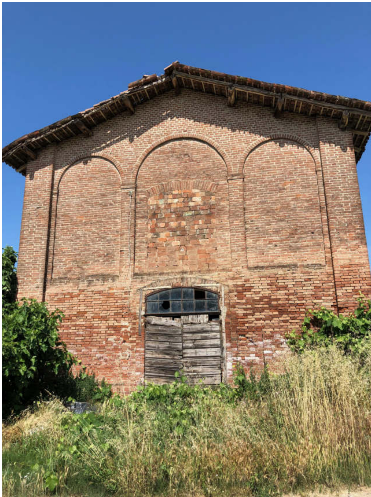
FOTO N. 11 VISTA ESTERNA - FGL. 10, MAPP. 283, SUB. 1
