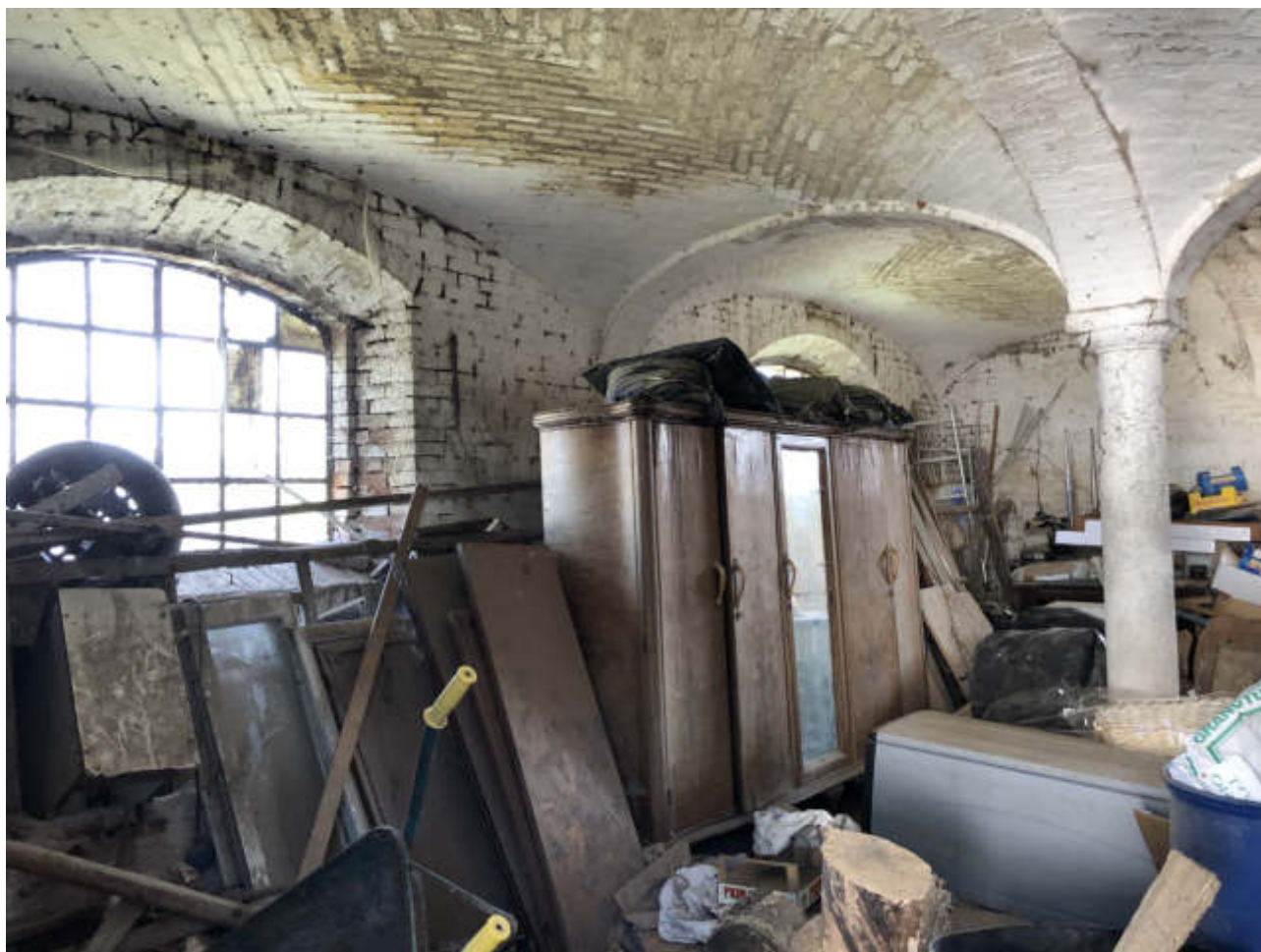
FOTO N. 13 VISTA INTERNA - FGL. 10, MAPP. 283, SUB. 1
