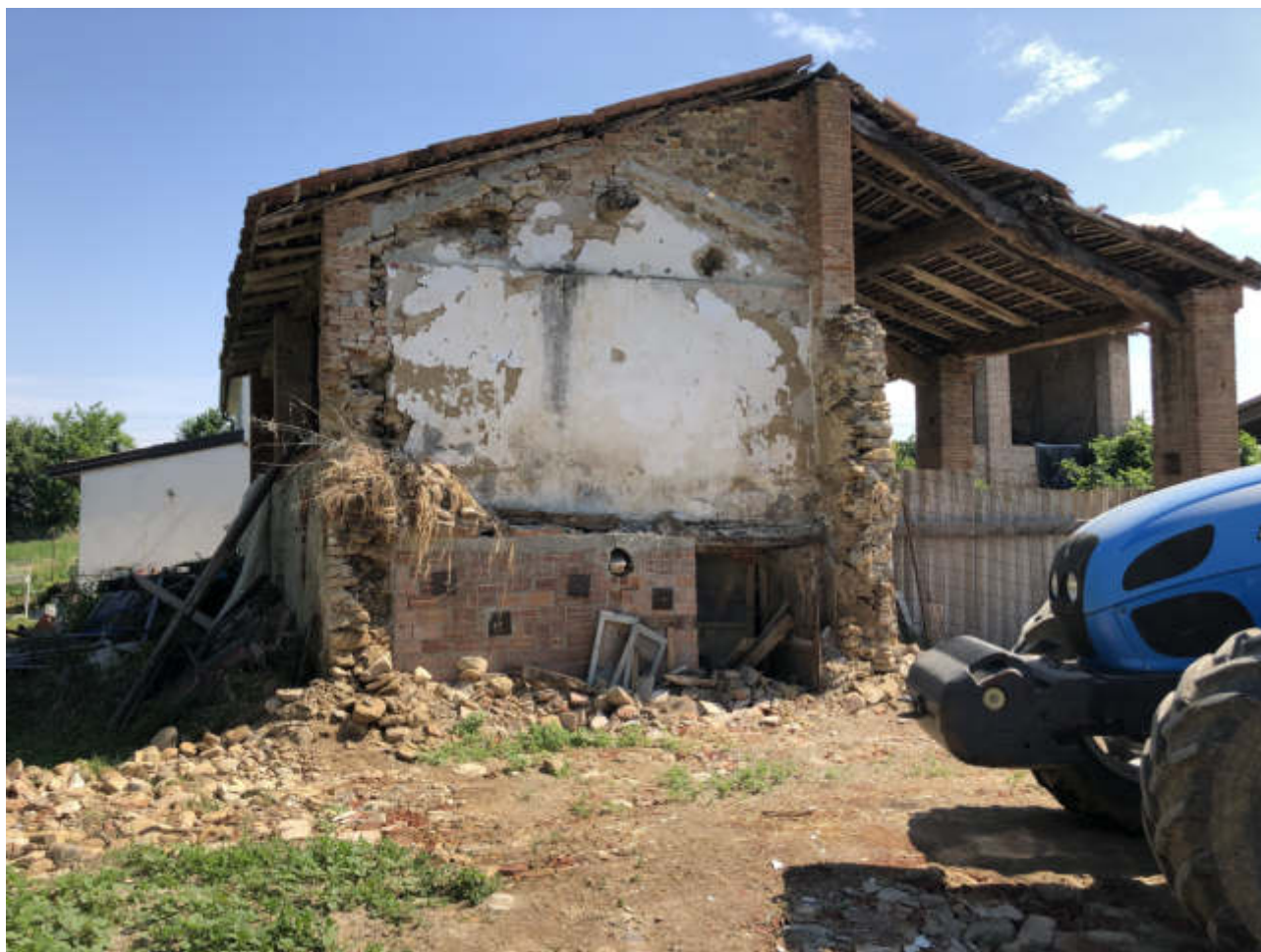
FOTO N. 33 VISTA ESTERNA - FGL. 10, MAPP. 283, SUB. 3
