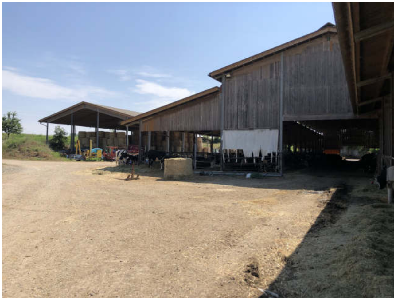
FOTO N. 26 VISTA ESTERNA - FGL. 10, MAPP. 283, SUB. 1
