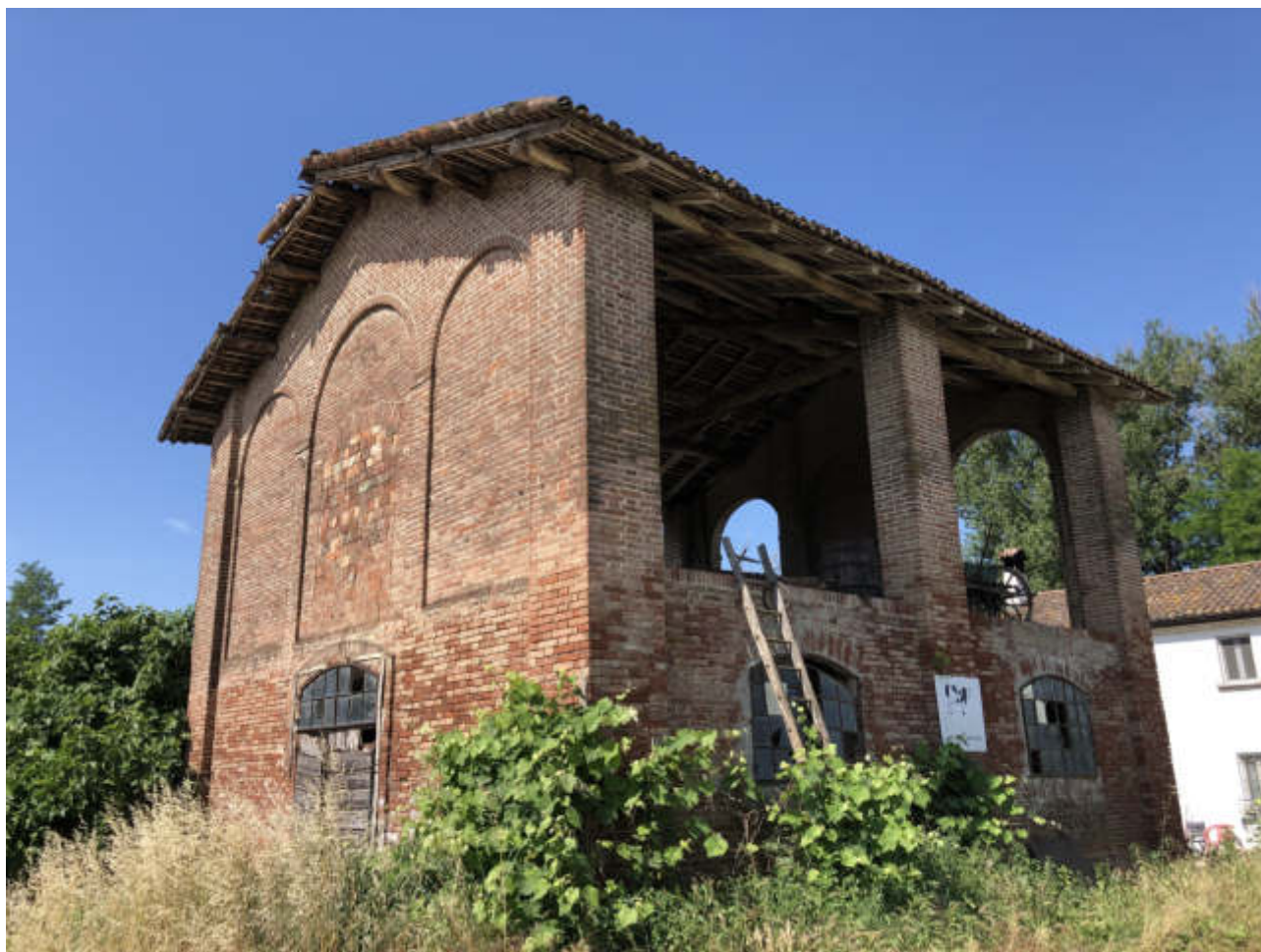
FOTO N. 10 VISTA ESTERNA - FGL. 10, MAPP. 283, SUB. 1
