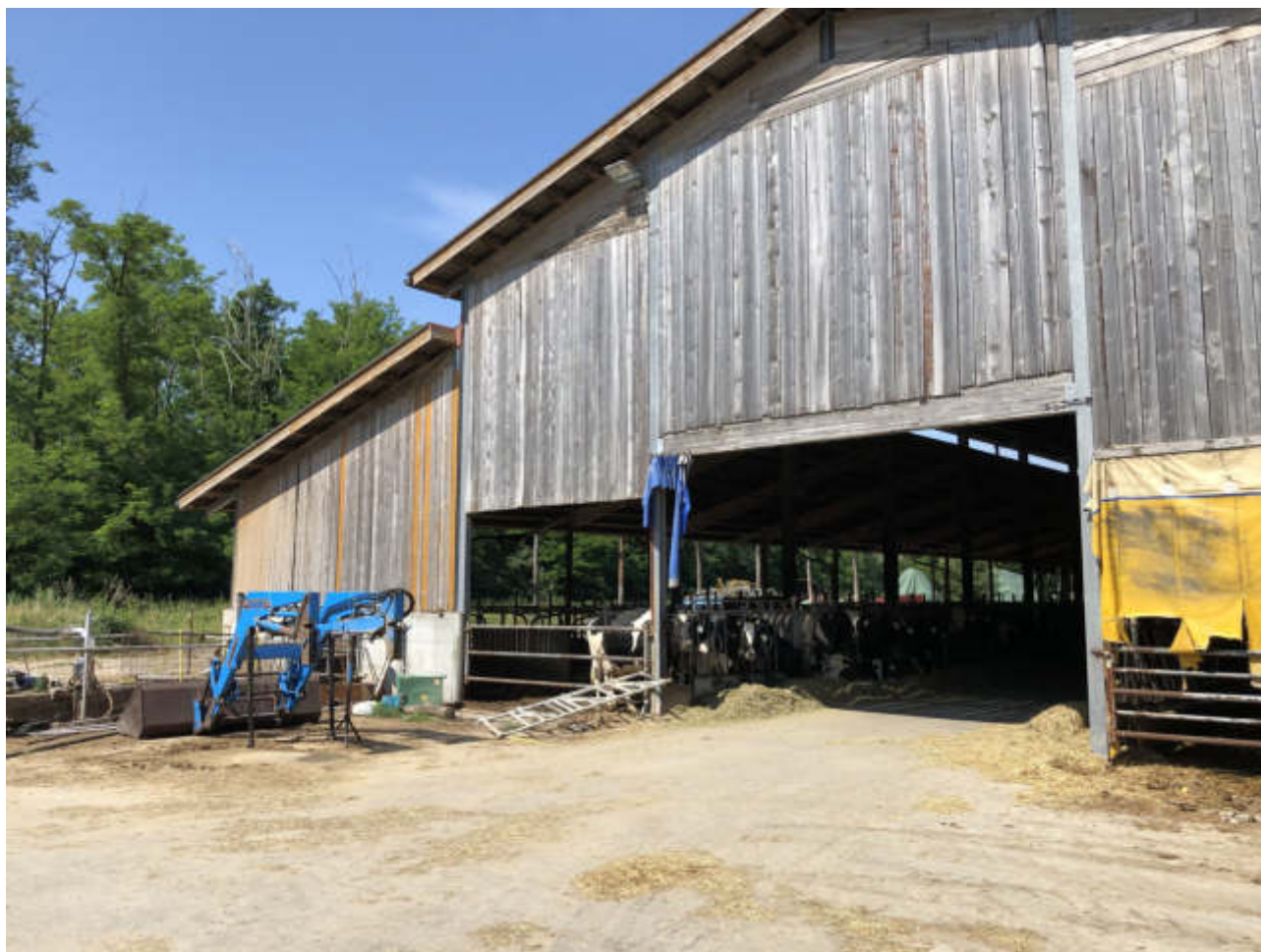
FOTO N. 20 VISTA ESTERNA - FGL. 10, MAPP. 283, SUB. 1
