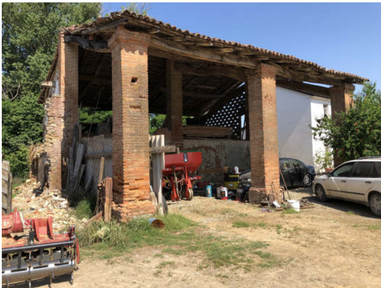
FOTO N. 32 VISTA ESTERNA - FGL. 10, MAPP. 283, SUB. 3
