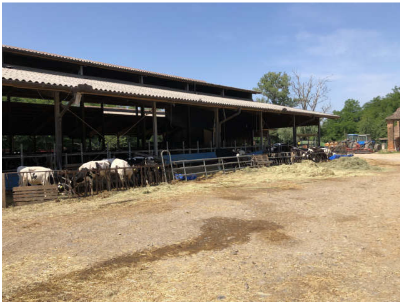
FOTO N. 18 VISTA ESTERNA - FGL. 10, MAPP. 283, SUB. 1
