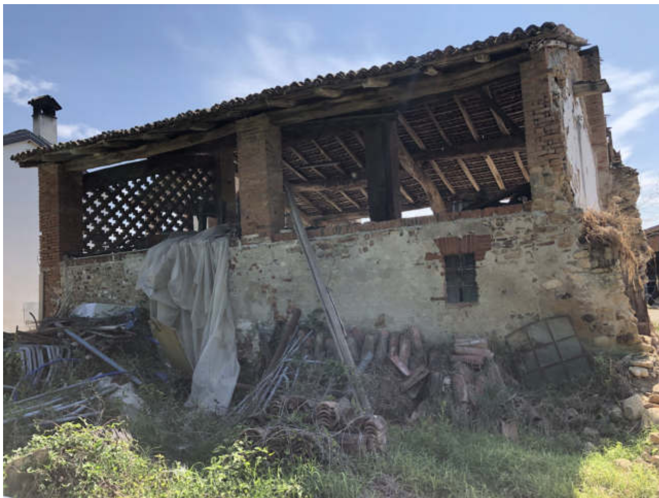
FOTO N. 31 VISTA ESTERNA - FGL. 10, MAPP. 283, SUB. 3
