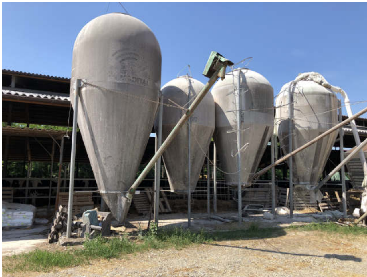
FOTO N. 19 VISTA ESTERNA - FGL. 10, MAPP. 283, SUB. 1
