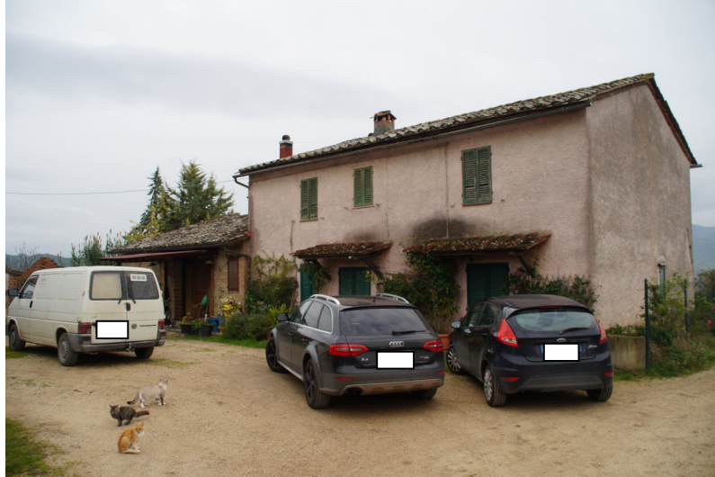
Foto n°3: particolare della corte e vista lato Nord – Ovest del fabbricato.
