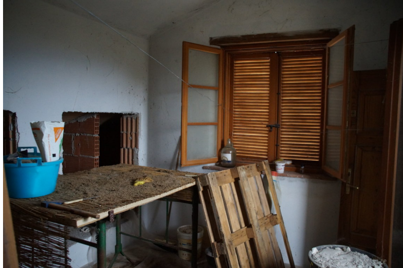
Foto n°33: particolare del locale avente destinazione d'uso a cucina.
