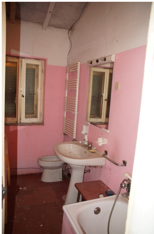
Foto n°38: particolare del bagno con vasca del piano primo.
