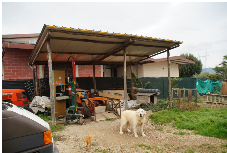
Foto n°6: altro particolare della corte, si noti la presenza di una tettoia senza autorizzazioni.
