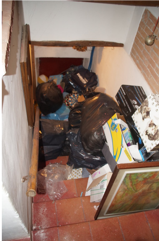
Foto n°39: particolare delle scale interne che collegano il piano primo al piano terra.
