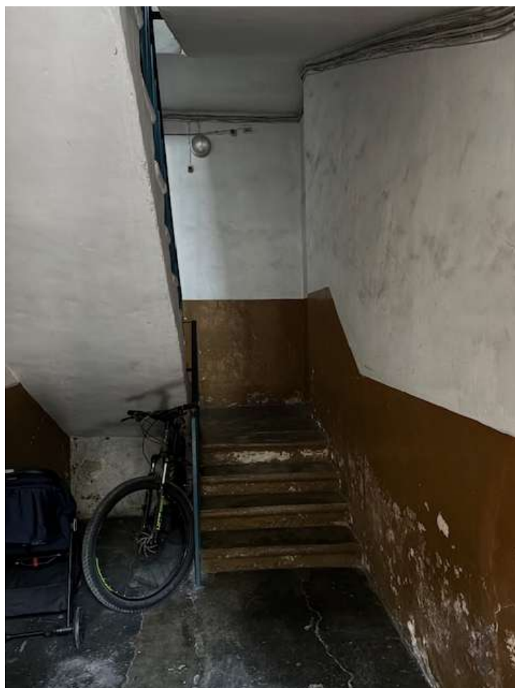
Foto n. 6 – Androne condominiale e scala d'accesso ai piani superiori
