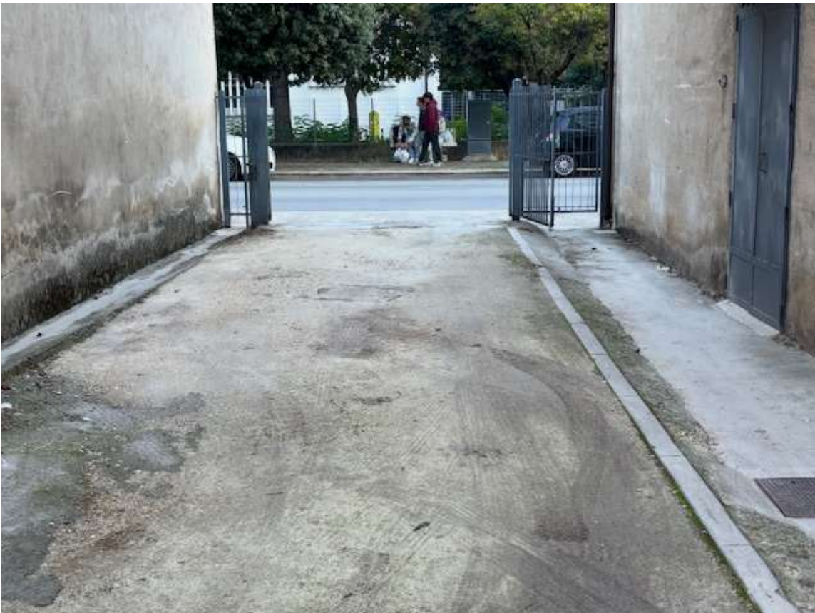
Foto n. 4 – Stradina privata laterale al fabbricato
