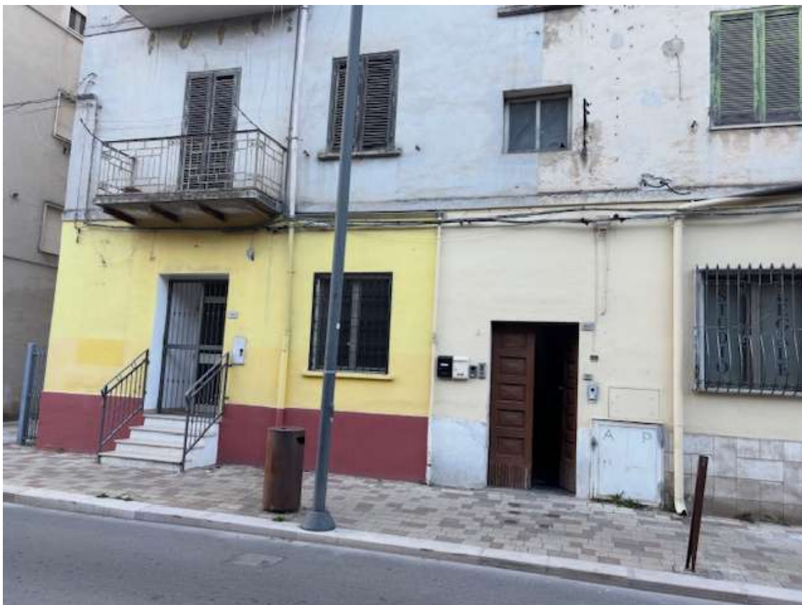
Foto n. 1 – Prospetto del fabbricato e accesso condominiale dal civico 64 di Via Risorgimento
