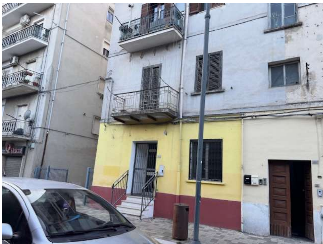
Foto n. 2 – Prospetto del fabbricato e accesso condominiale dal civico 64 di Via Risorgimento
