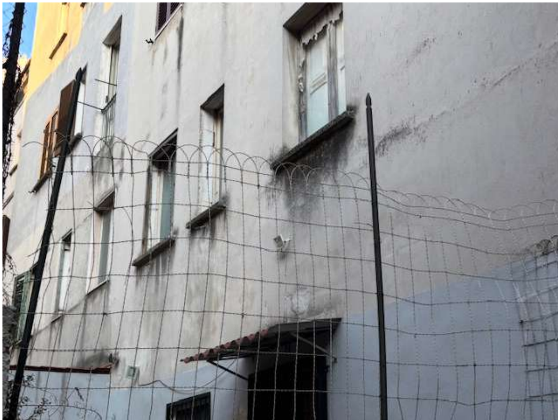
Foto n. 5 – Prospetto posteriore del fabbricato su cortile interno
