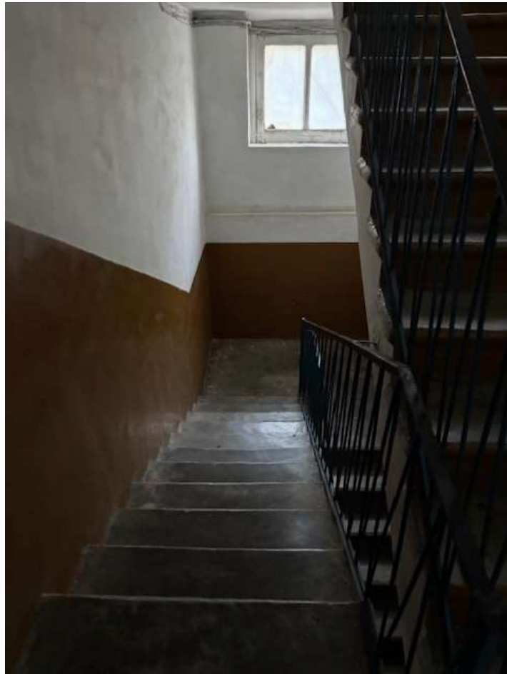
Foto n. 7 – Scala d'accesso al primo piano
