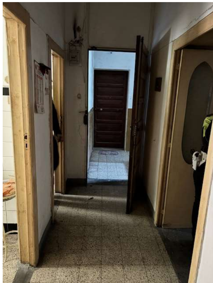
Foto n. 10 – Ingresso-corridoio e porta d'accesso dal pianerottolo del primo piano
