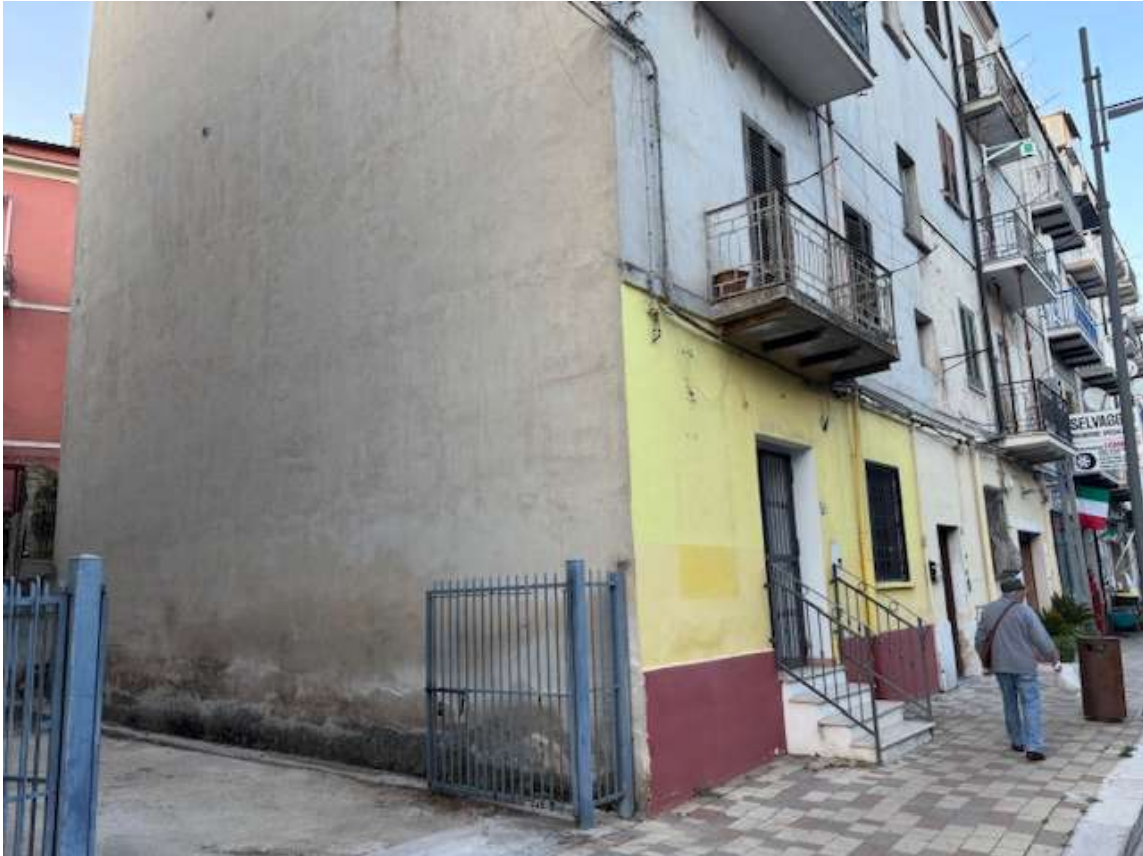
Foto n. 3 – Prospetto del fabbricato da Via Risorgimento, angolo stradina privata
