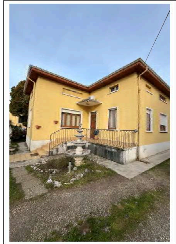
2. FRONTE OVEST DI INGRESSO ALL'ABITAZIONE
