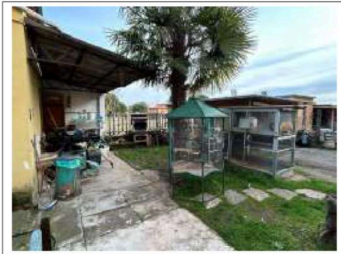
25. TETTOIA IN ETERNIT – SUL FIANCO DEL BOX
