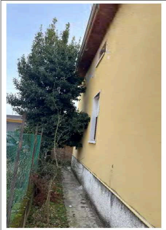
5. FACCIATA A NORD VERSO ALTRA PROPRIETA'
