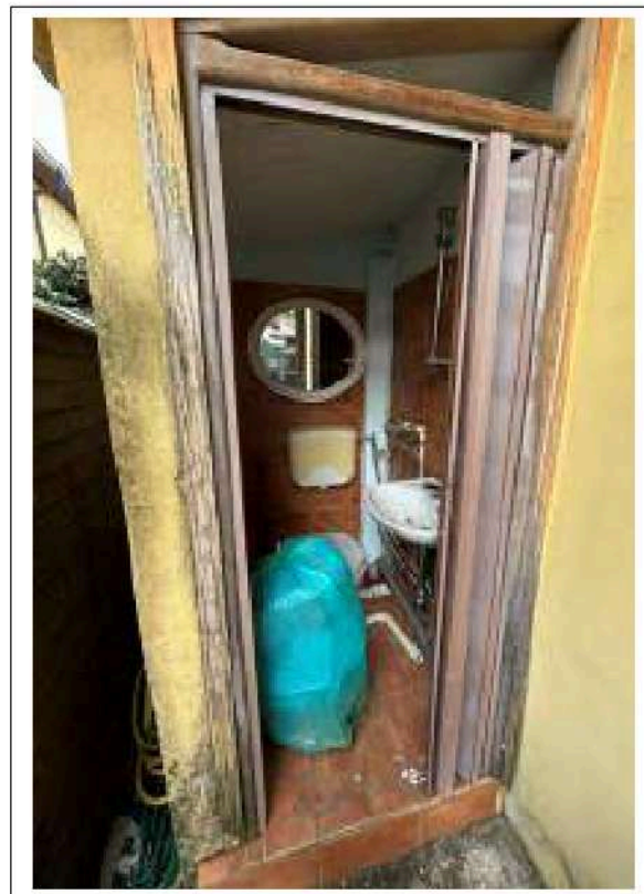
28. INTERNO DEL W.C.
