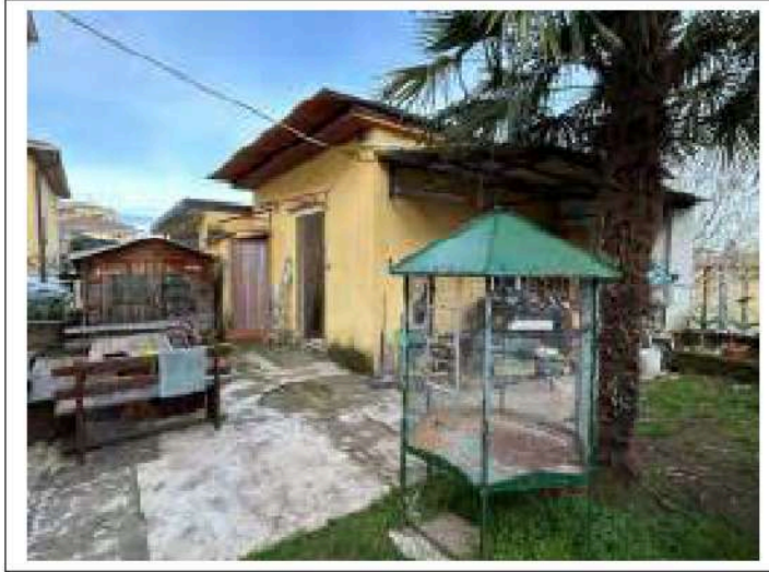
24. EDIFICIO ACCATASTATO COME BOX ALLESTITO ATTUALMENTE A LOCALE CUCINA/PRANZO
