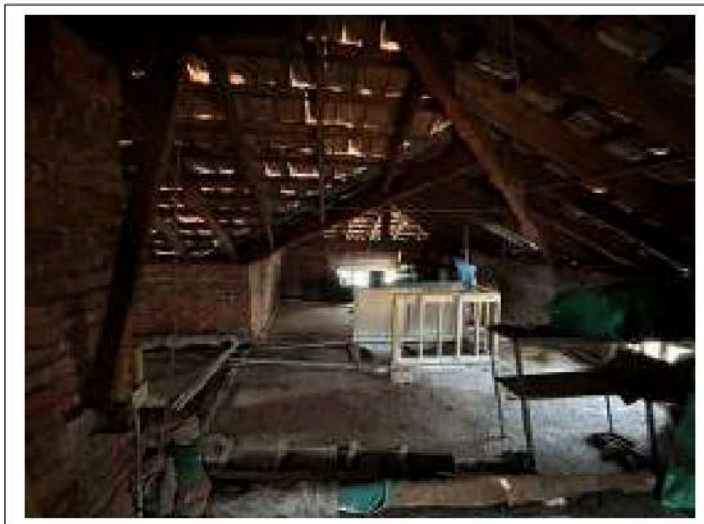
22. IL SOTTOTETTO CON LA SCALA DI ACCESSO DAL LOCALE SOGGIORNO
