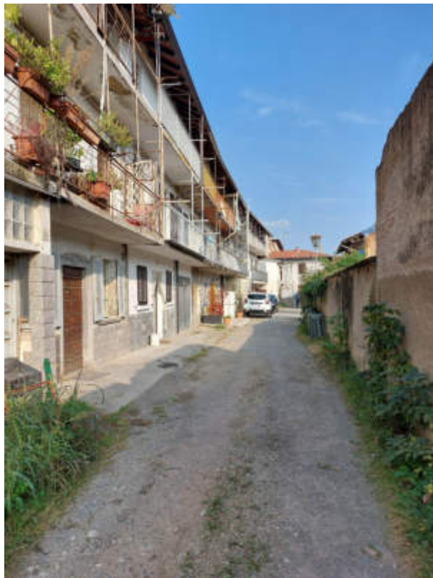
FOTO 2 Vista esterna – Fronte edificio
