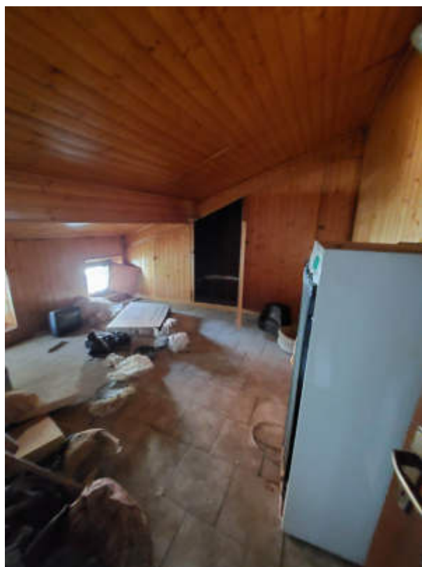
FOTO 12 Vista interna P2 – Locale nord
