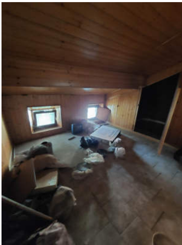
FOTO 13 Vista interna P2 – Locale nord
