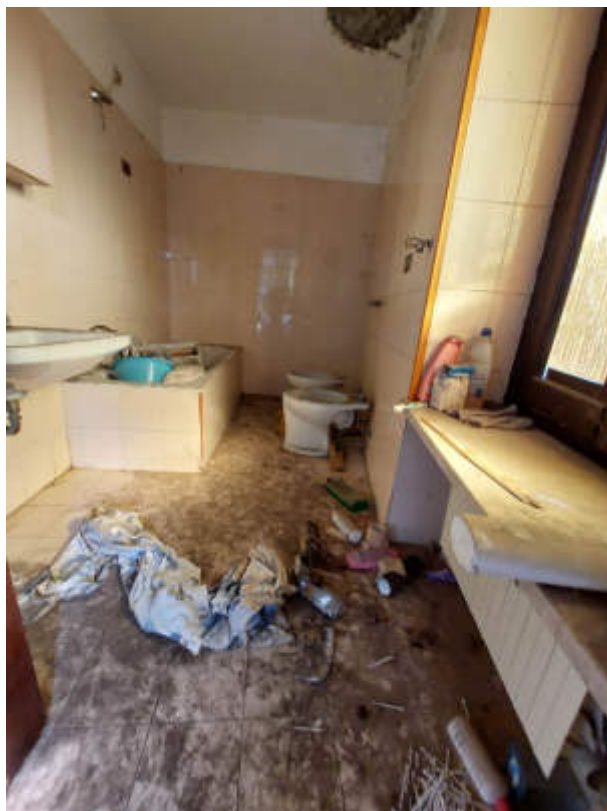
FOTO 8 Vista interna P2 – Bagno
