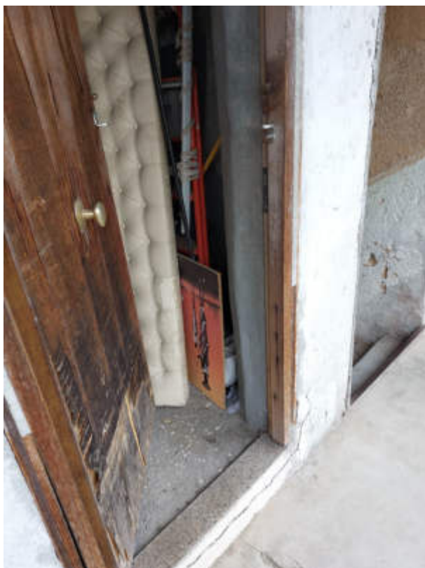
FOTO 18 Vista esterna P2 – C6 - Ingresso
