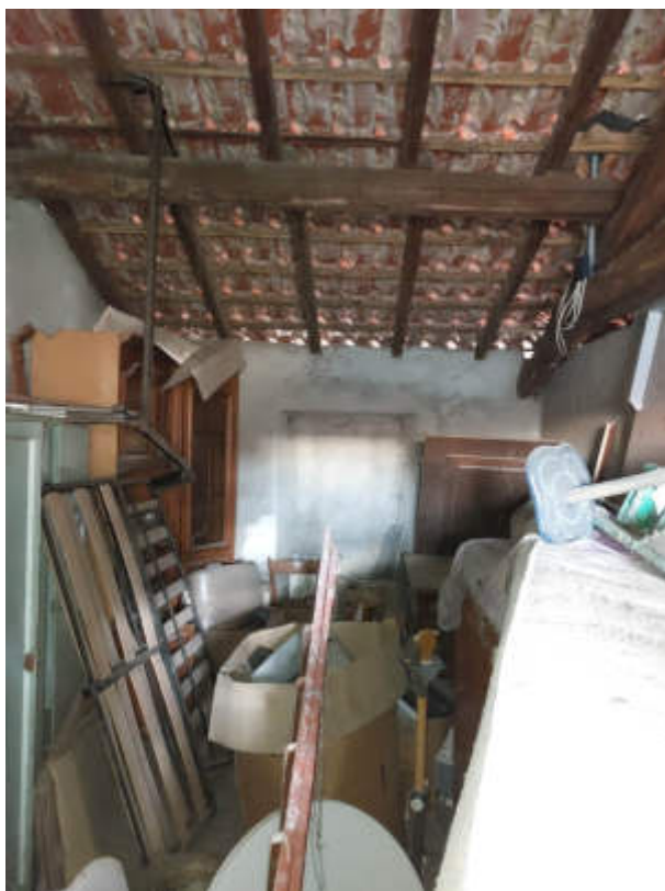
FOTO 19 Vista interna P2 – C6 - Vano al P2
