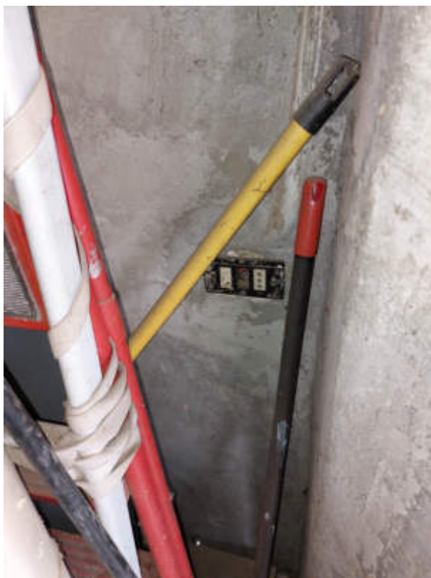
FOTO 21 Vista interna P2 – C6 - Vano al P2
