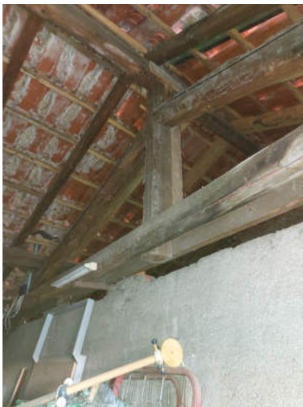
FOTO 20 Vista interna P2 – C6 - Vano al P2
