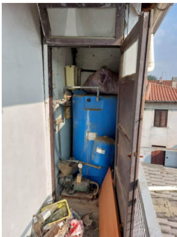
FOTO 14 Vista esterna P1 – Ripostiglio con accesso da ballatoio
