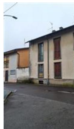
prospetto su Via Mazzini
