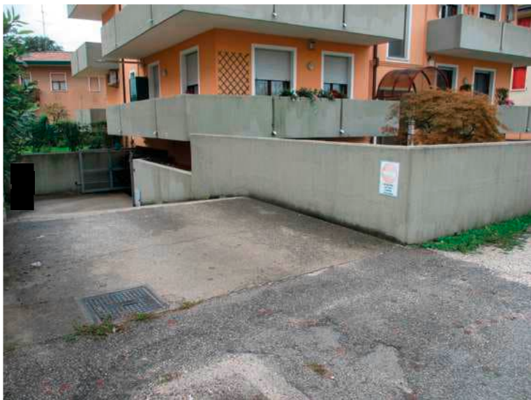
13 – Vista della rampa di accesso al piano seminterrato
