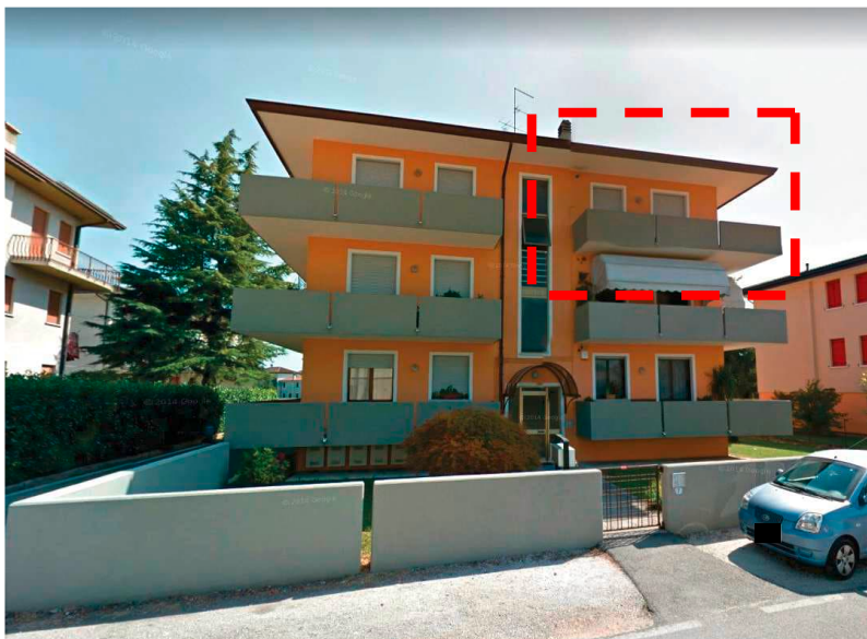
1 – Vista esterna da Nord
