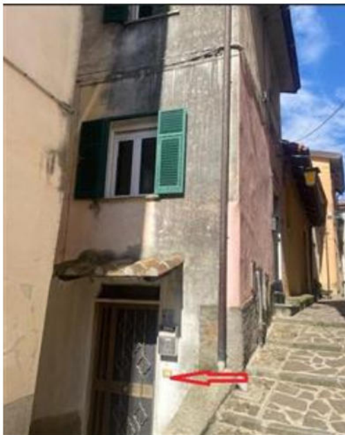
FABBRICATO ANGOLARE SU VIA ROMA . IL CIVICO 60 E' INDICATO CON LA FRECCIA
