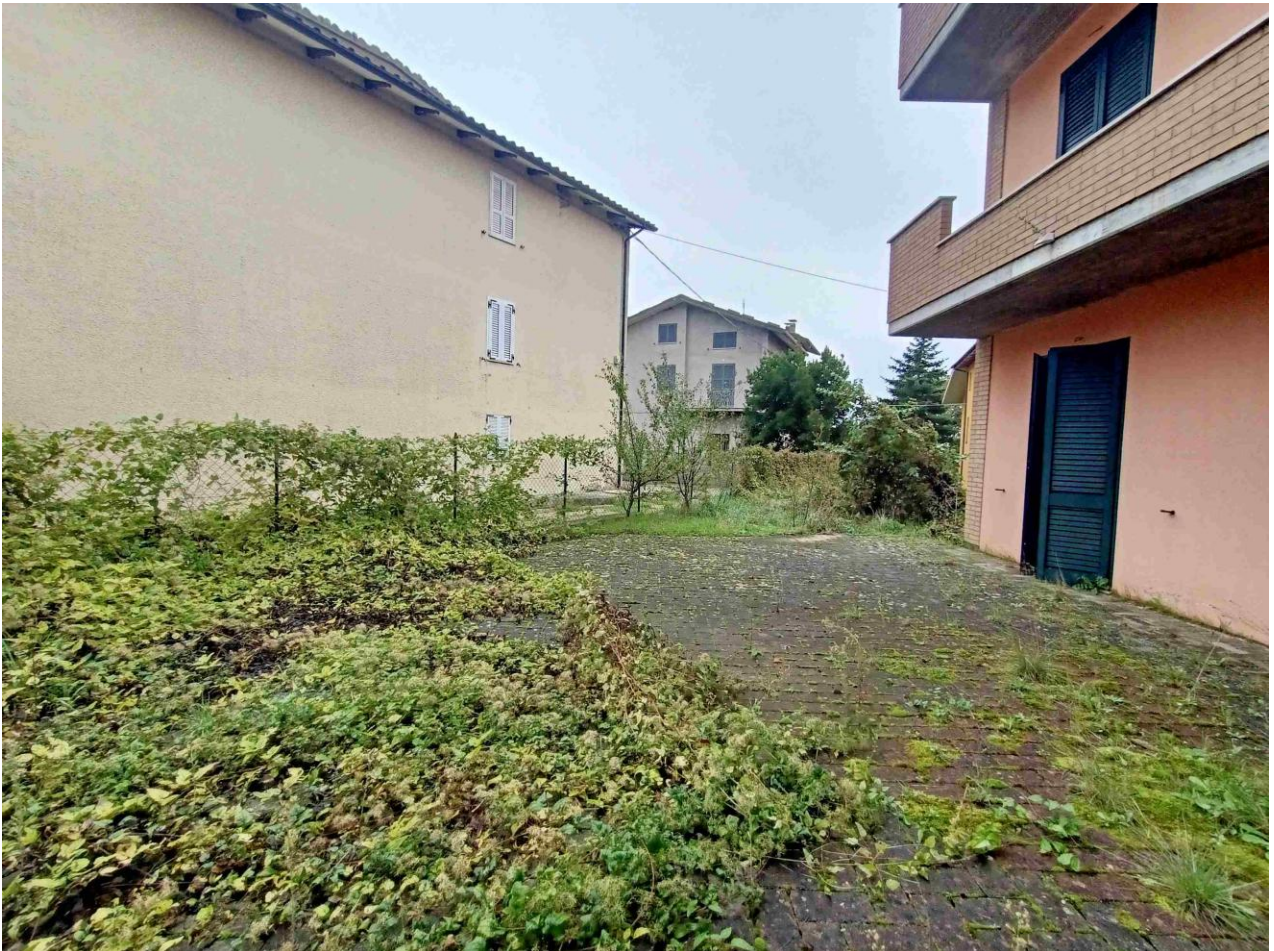
Foto 8: ESTERNO SUB. 26 PIANO TERRA
