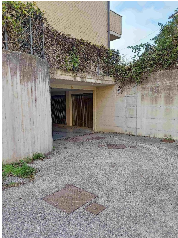
Foto 18: RAMPA DI ACCESSO CARRABILE AI GARAGE
