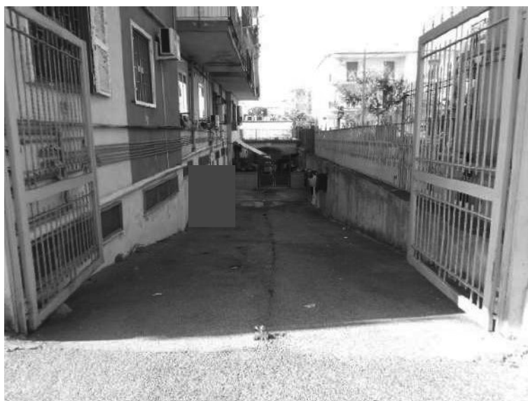
Foto n. 1: • Viale corrispondente al civico 21 di Traversa VI Via Villa Bisignano, costituente l'accesso all'immobile pignorato e ad uso comune.
